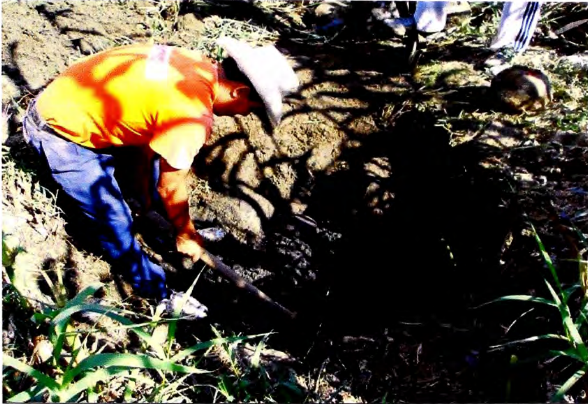
Figura 4.3: Excavación de Calicata C-1
