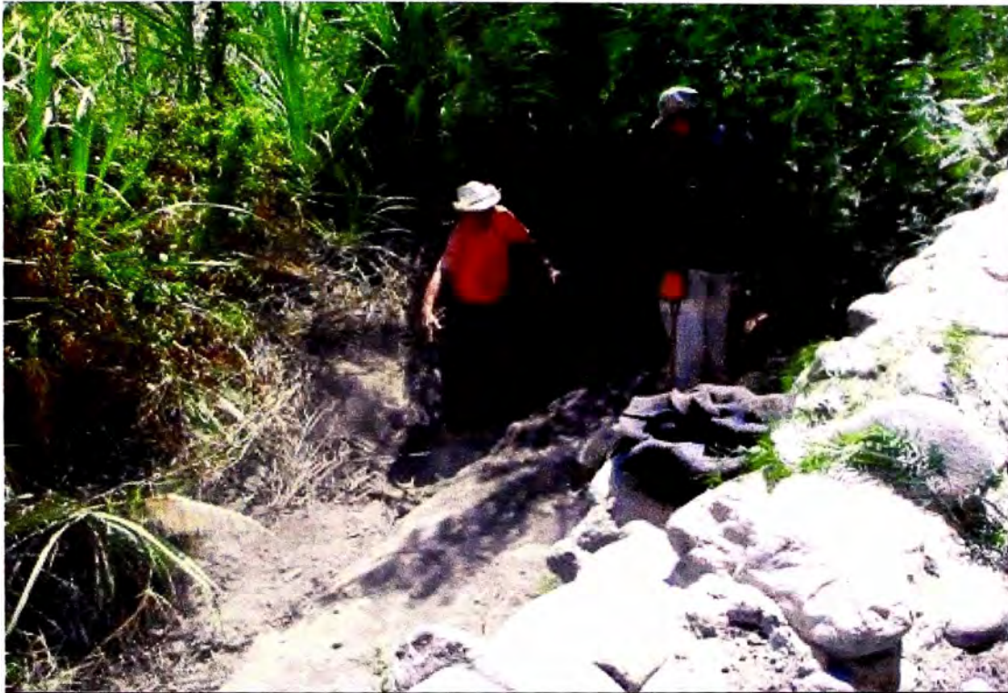
Figura 4.5: Excavación de Calicata C-2
