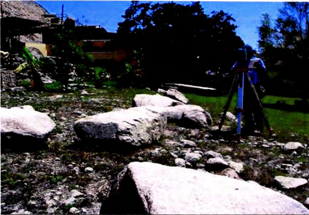
Figura 3.4. Toma de datos con Estación Total en terrenos del reservorio proyectado
