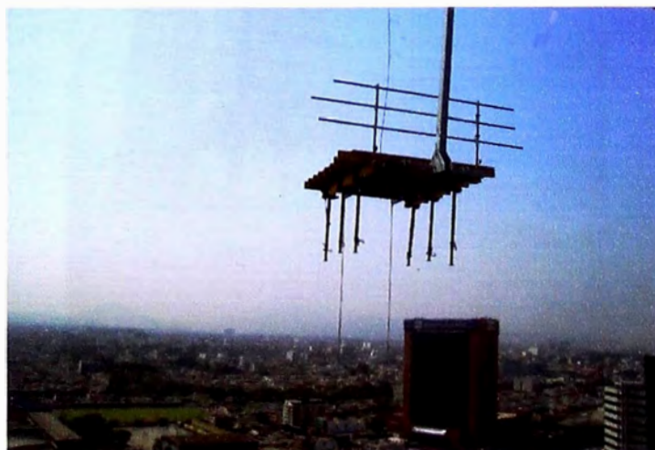
Figura 9: Paso 3- Transporte de mesa VR
