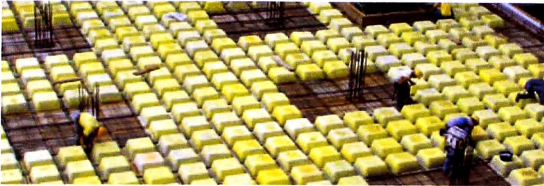
Figura 3.10: Casetones plásticos recuperables
