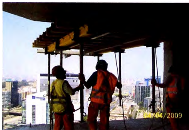
Figura 2: Fijación de gancho VR para el transporte de la mesa
