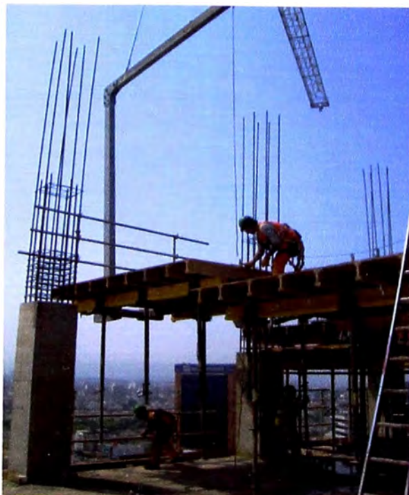
Figura 10: Paso 4-Posicionamiento de mesa VR
