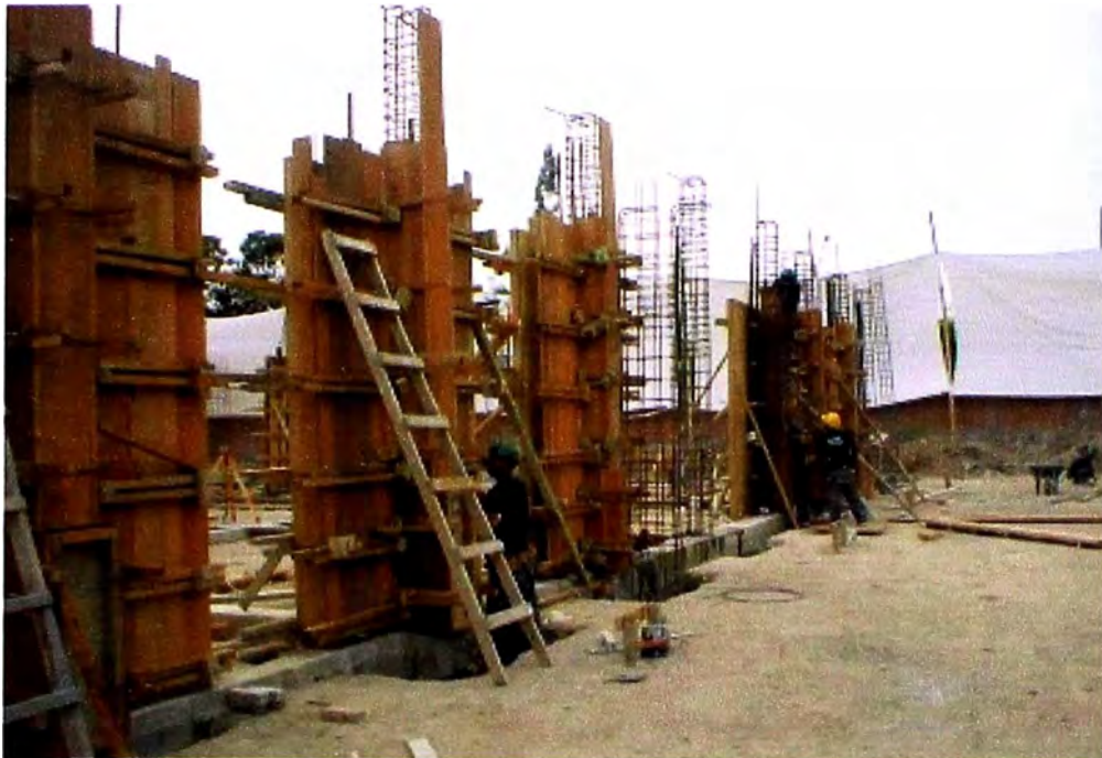
Figura 3.3: Encofrado de madera tradicional para columnas
