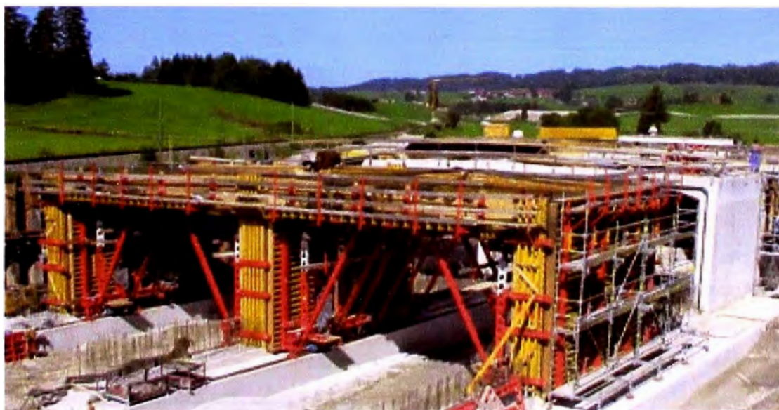
Figura 3.9: Sistema de encofrado para puente
