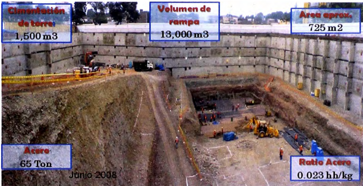
Figura 4.6: Excavación de la cimentación de Torre – Junio 2008
