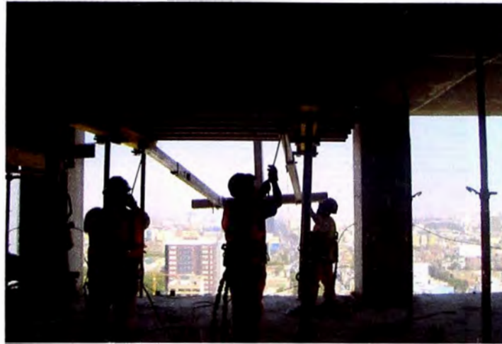
Figura 7: Paso 1- Desencofrado
