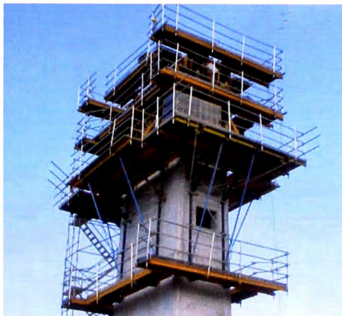
Figura 3.17: Andamios o consolas autotrepantes
