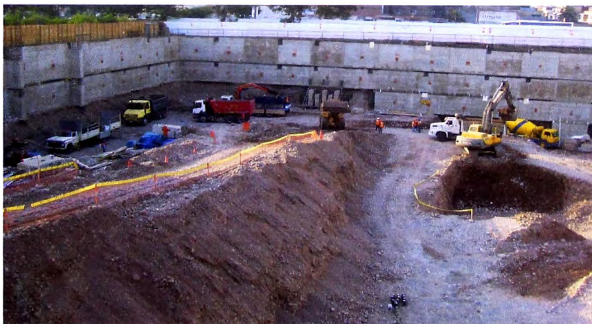
Figura 4.4: Inicio de excavación de la cimentación de Torre – Abril 2008
