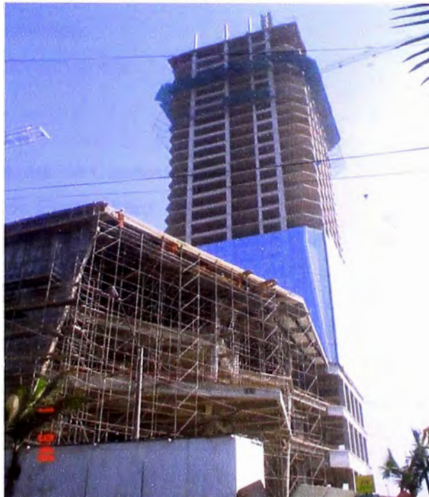
Figura 4.10: Fin de Estructuras de Torre – Junio 2009
