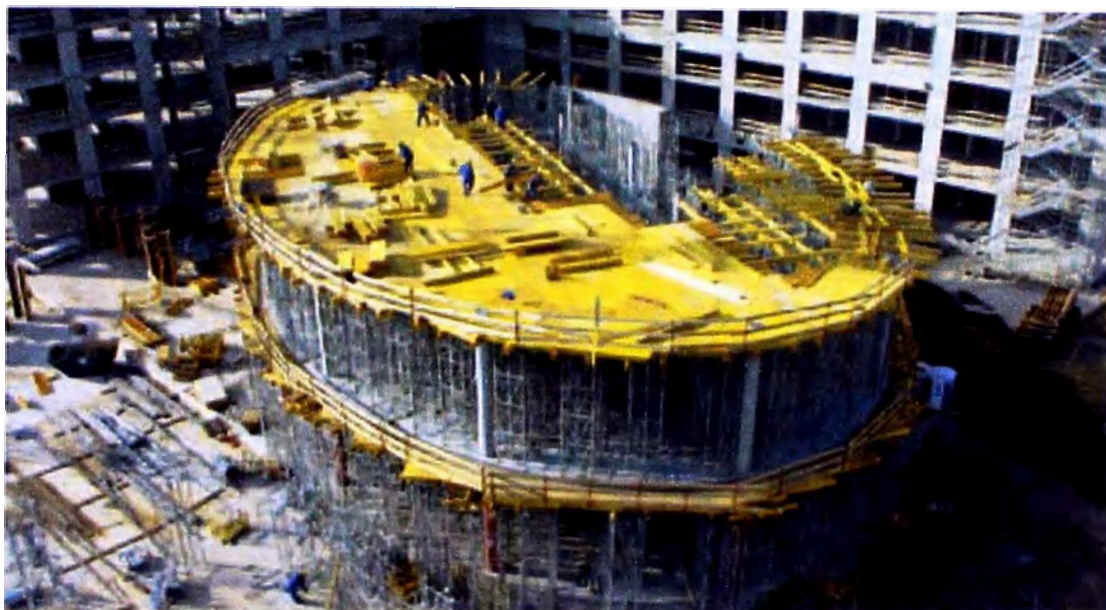
Figura 3.8: Sistema horizontal de encofrado: puntales, andamios y vigas de soporte y tableros de madera prefabricados como fondo de losa.
