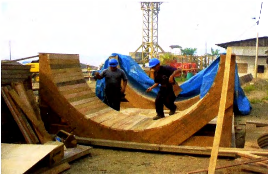
Figura 3.4: Encofrado de madera tradicional para pilares de puente
