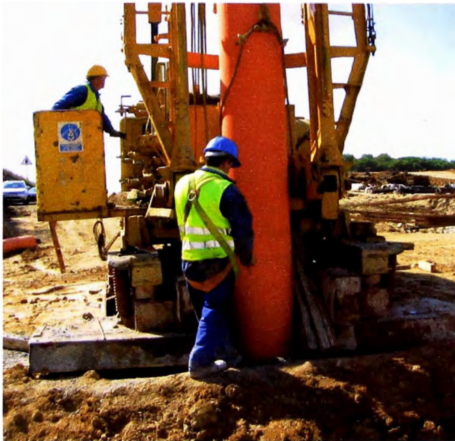
Figura 3.14: Encofrado estructural, fuste metálico de pilote que luego de ser hincado servirá como forma para el concreto
