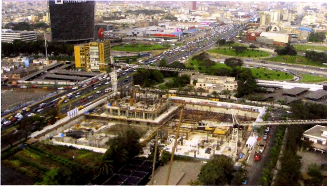
Figura 4.7: Estructuras de Torre – Noviembre 2008
