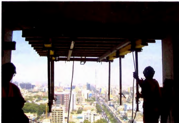
Figura 8: Paso 2 – Fijación de la mesa y elevador VR
