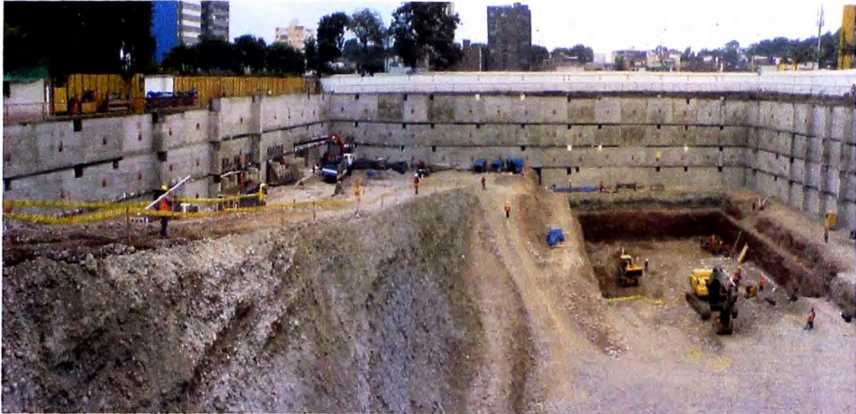
Figura 4.5: Excavación de la cimentación de Torre – Mayo 2008
