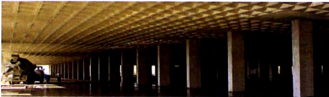
Figura 3.11: Acabado de losas vaciadas sobre casetones plásticos
