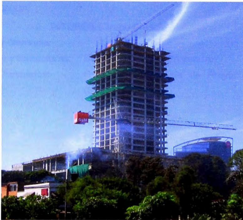
Figura 4.9: Estructuras de Torre – Abril 2009
