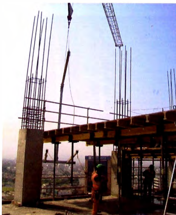
Figura 11: Paso 5- Se retira el elevador VR y se inicia el ciclo
