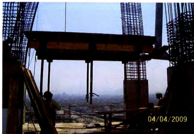
Figura 5: Posicionamiento de mesa VR
