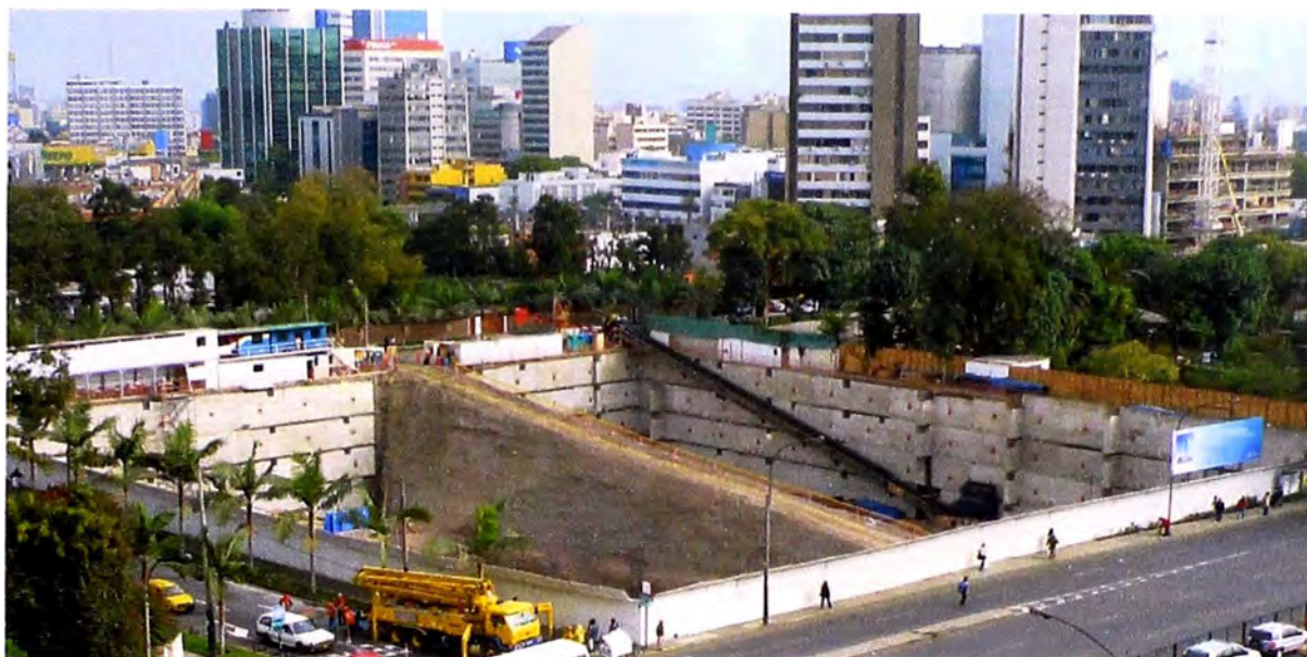
Figura 4.3: Movimiento de tierras Hotel Westin
