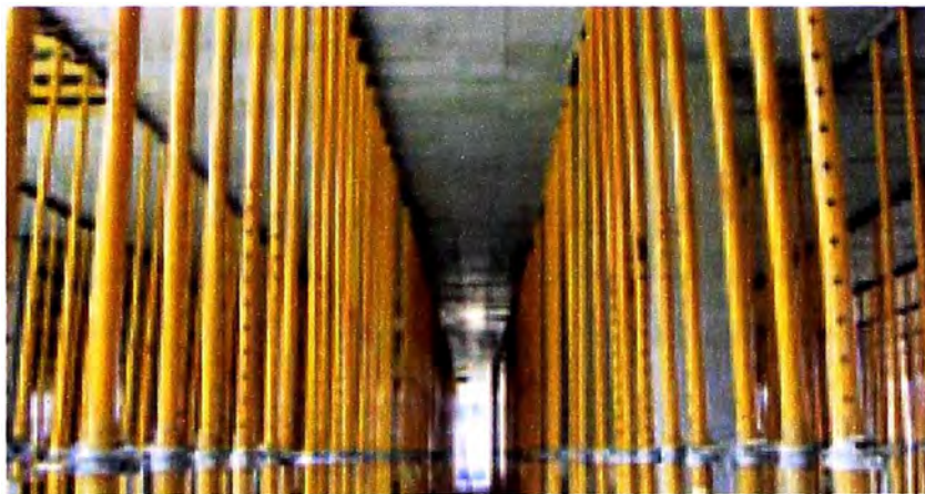
Figura 3.20: Sistema de rápido desencofrado de losas
