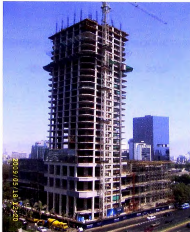
Figura 12: Vista de la Torre durante el proceso de ejecución
