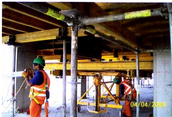
Figura 1: Desencofrado de mesa VR
