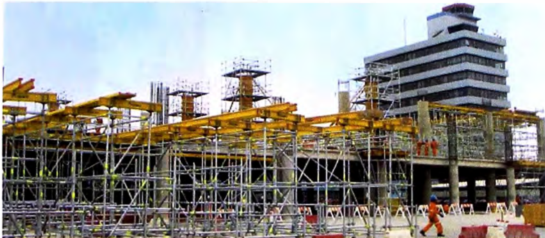
Figura 3.2 – andamios y vigas de soporte para encofrado de losas
