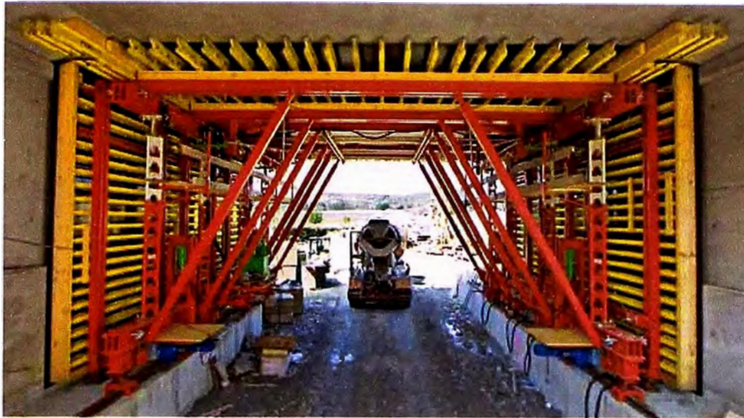
Figura 3.18: Encofrado deslizante
