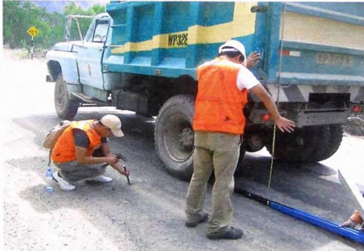
**FIGURAN° 02 OBTENIENDO EL ESPESOR DE CARPETA Km 104+000**
