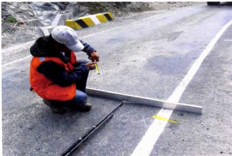
**FIGURA N° 05 MEDIDA DEL AHUELLAMIENTO Km 104+600**
