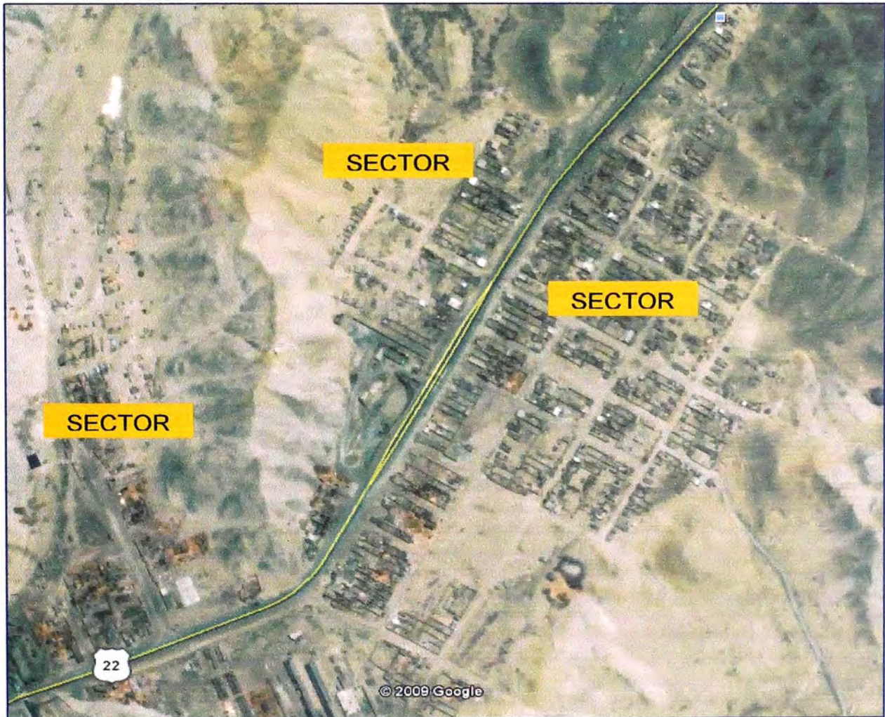
VISTA PANORAMICA DEL PROYECTO FIGURA 1.1
