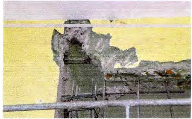
**Comentario:** *Se demolió parcialmente la viga y colocó refuerzo de corte en viga.*
