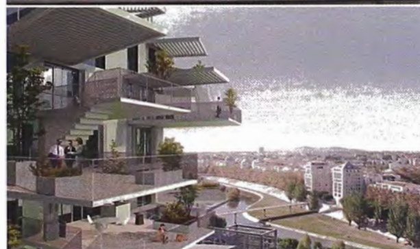
Figura 2: Cité des Savoirs, sede de los archivos departamentales del Hérault, proyecto de la Arquitecta Zaha Hadid.
