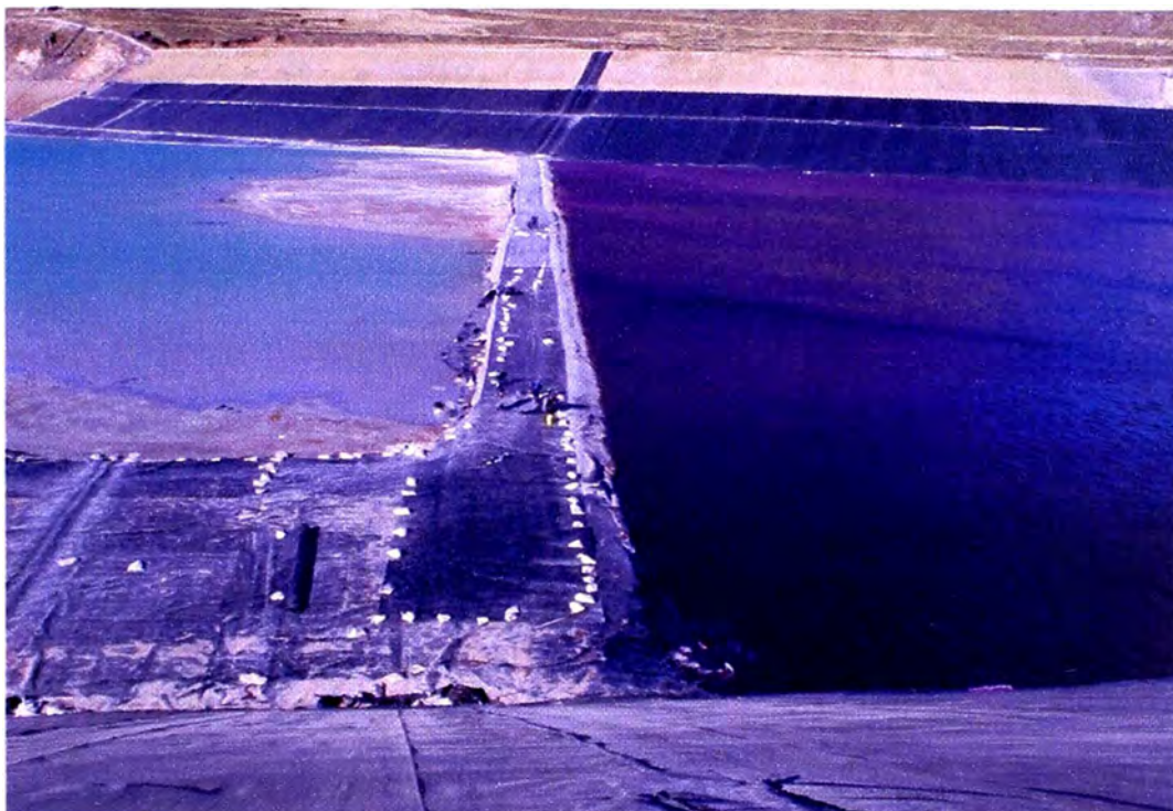
Fotografía N° 16 : Se muestra la unión terminada entre ambas etapas. Se observa que el nivel del relave se encuentra cerca de donde se están realizando los trabajos.
