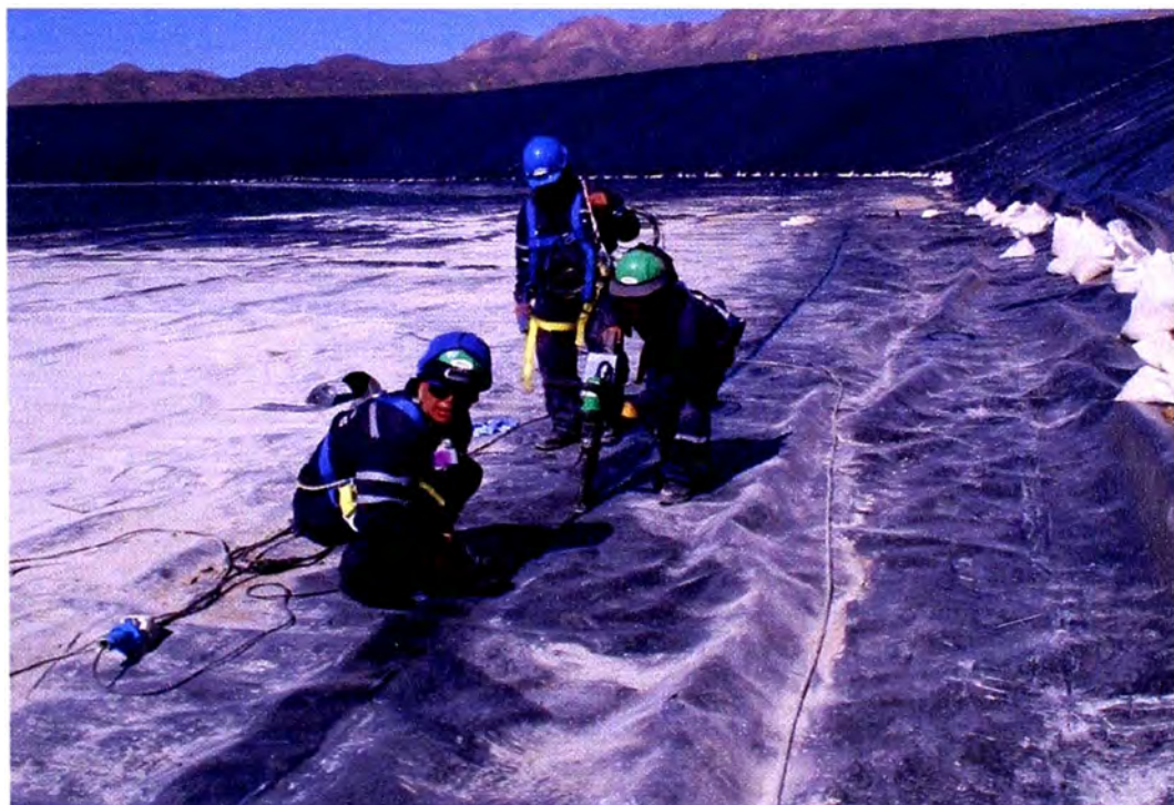
Fotografía N° 17 : La vista muestra los últimos detalles de la instalación. Se completan los últimos trabajos de soldadura por extrusión.
