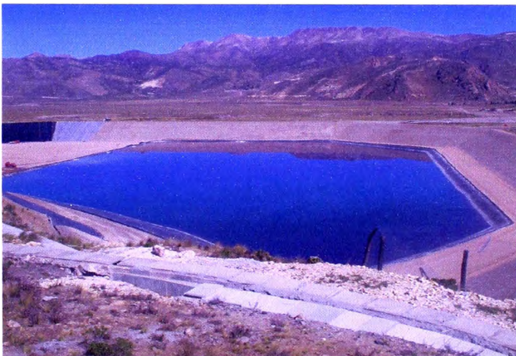
Fotografía N° 5 : En la vista se aprecia que el nivel del relave esta alcanzando la corona de la Etapa Pre-Inicial (Poza de Contingencia). Se hacía necesario la inmediata puesta en marcha de la Etapa Inicial.
