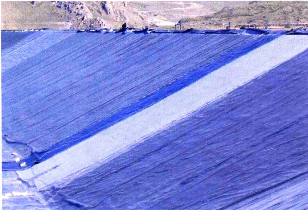
Fotografía N° 15 : Detalle de revestimiento de taludes con Geomembrana y con GCL.
