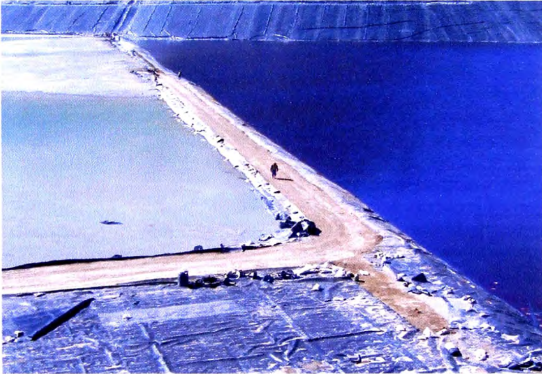
Fotografía N° 14 : Detalle de la berma de unión entre las Etapas Pre-Inicial y la Etapa Inicial. Obsérvese que dada la urgencia del área de Operaciones de Mina, se tuvieron que terminar los trabajos en plena operación de depósito de relaves.
