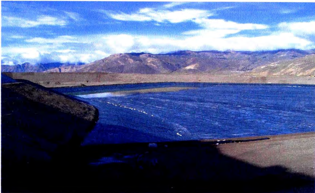
Fotografía N° 4 : Etapa Pre-Inicial concluída y en inicio de operaciones.
