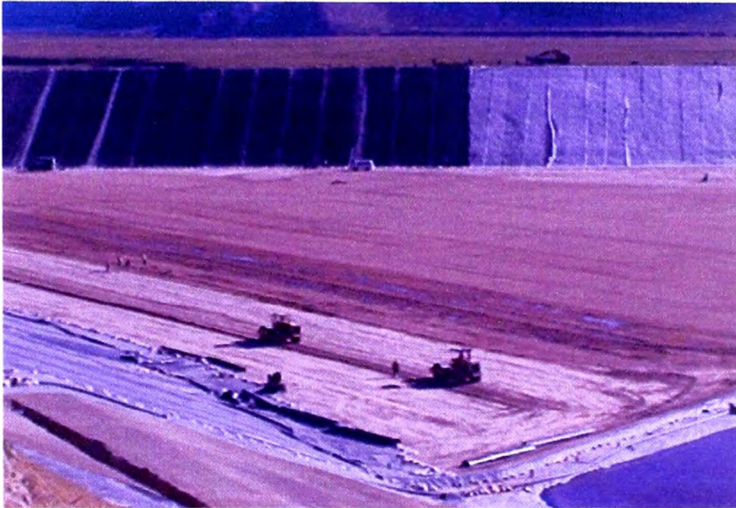
Fotografía N° 6 : Etapa Constructiva de la Etapa Inicial. Se aprecian los trabajos de nivelación y compactación de la capa de arcilla del fondo del depósito.
