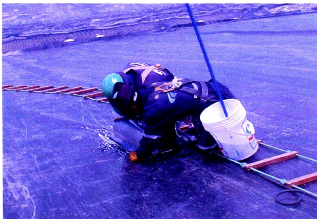
Fotografía N° 13 : Realizando la prueba de Caja de Vacío a un parche.
