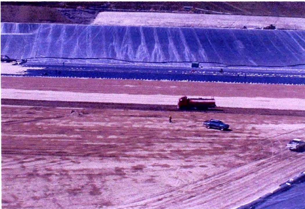
Fotografía N° 7 : Etapa Inicial. Se aprecia el revestimiento de los taludes con geomembrana de HDPE.
