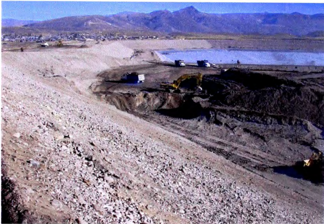
Fotografía N° 2 : Etapa de Movimiento de Tierras para la construcción de la Relavera
