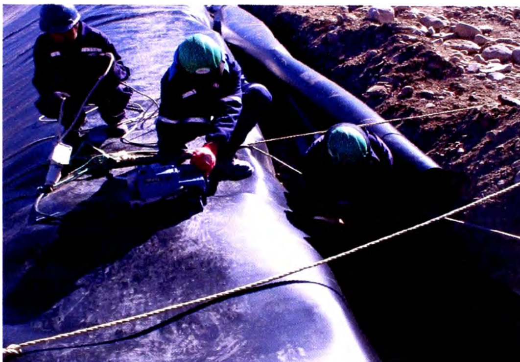
Fotografía N° 12 : Realizando la soldadura por fusión (cuña) en la zona de la zanja de anclaje.
