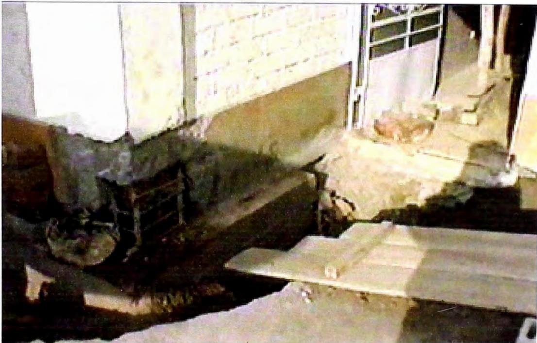
**COLUMNAS** .- *Se colocan nuevas columnas y otras se refuerzan según los cálculos realizados por el Ing. estructural.*
