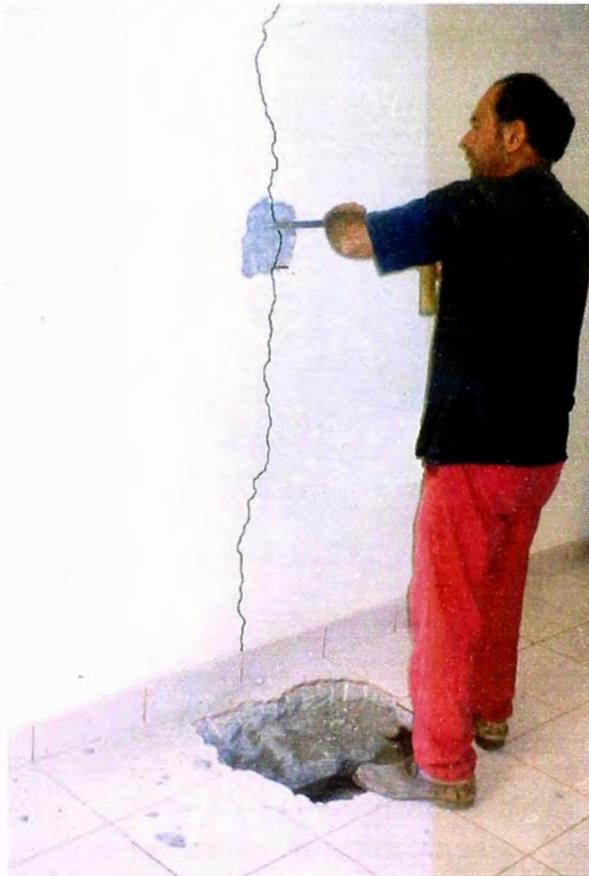
**Foto 9.-** Se hizo la verificación estructural de las columnas cumpliendo con el acero vertical según los planos, pero no respetando el recubrimiento indicado.
