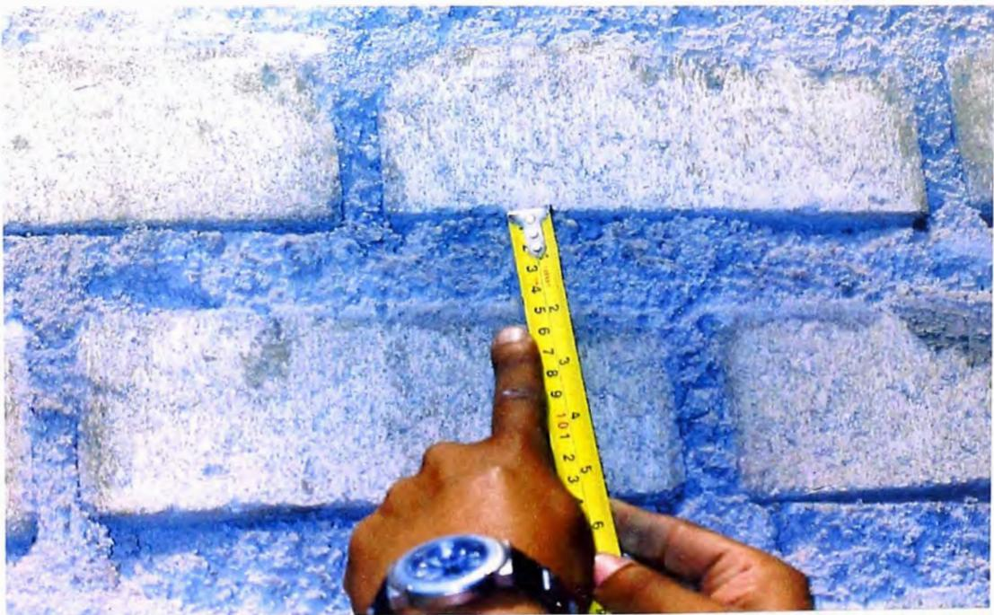
**Foto 6.-** Se muestra el mal uso del mortero para la pega de los ladrillos el cual se muestra de 4 a 5 cm de espesor, siendo lo recomendable 1.5 cm. como máximo.
