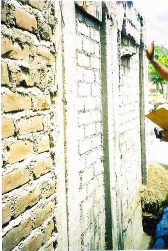
**Foto 5.-** Se muestra la albañilería confinada, apreciándose también el muro antiguo de ladrillo de arcilla cocida y muros con el nuevo ladrillo king concreto.
