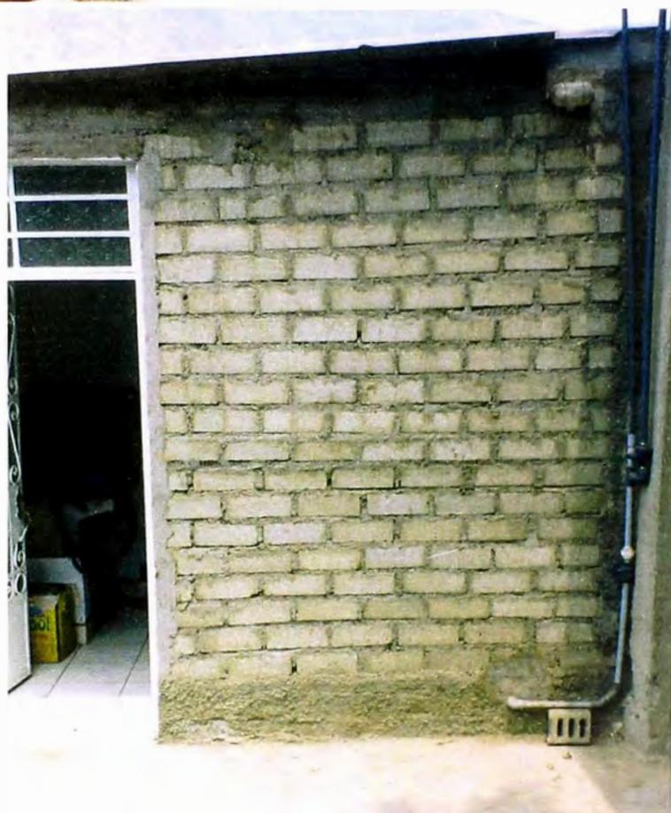
*Foto 8.- Muestra de un muro usando el ladrillo king concreto, se puede apreciar la mala calidad de construcción en su totalidad.*
