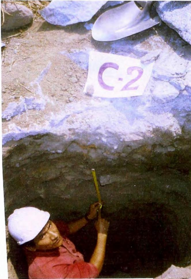
**MEDICIÓN .-** Se toma la medida de los estratos encontrados de la calicata a una profundidad de 3m. Observándose que hay una capa de 40 cm. de relleno que deberá ser reemplazado por un material de mejor resistencia.
