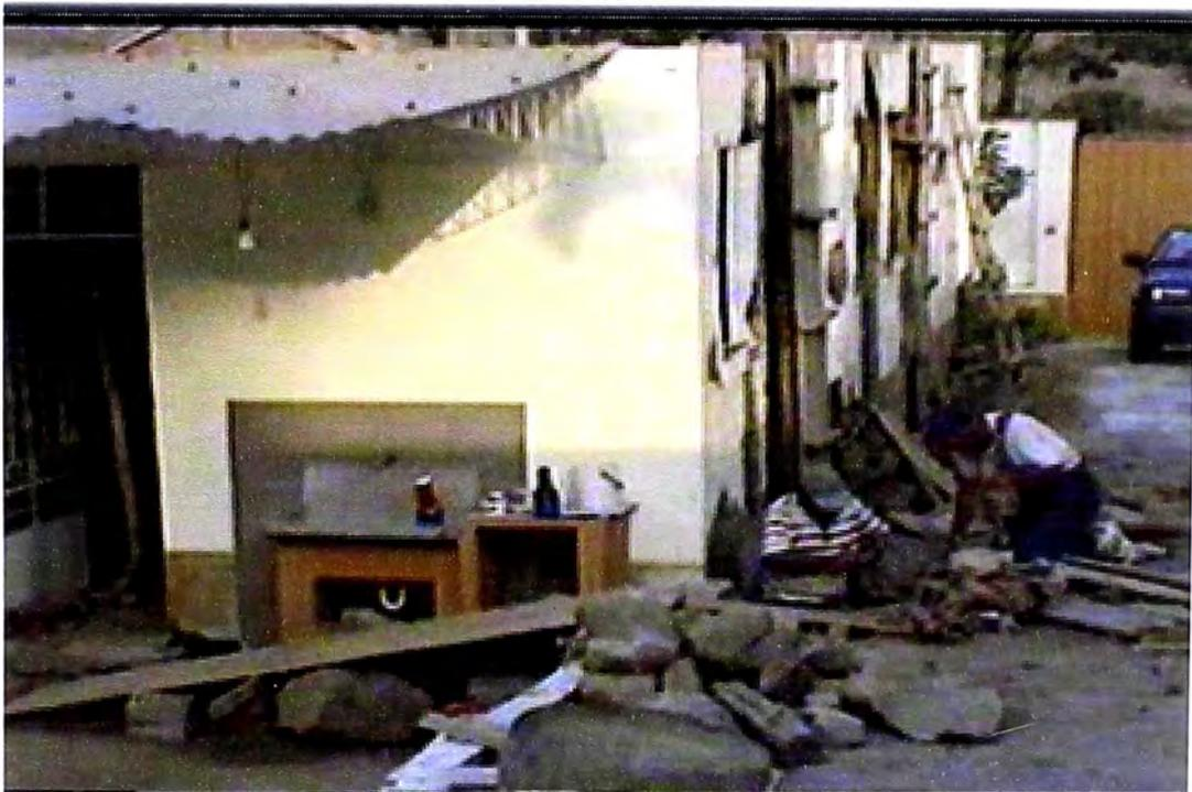
**ESCAVACIONES** .- Se hacen excavaciones por tramos de 1.50 m. y a una profundidad de 1.40 m. para las nuevas cimentaciones y colocaciones nuevas de placas y columnas.
