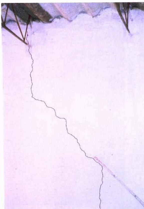
**GRIETA 6.-** Pertenece al garaje, es una grieta de configuración errática con tramos de diversas inclinaciones, al estar el muro en limite de propiedad y no es posible asegurar si atraviesa el muro.
