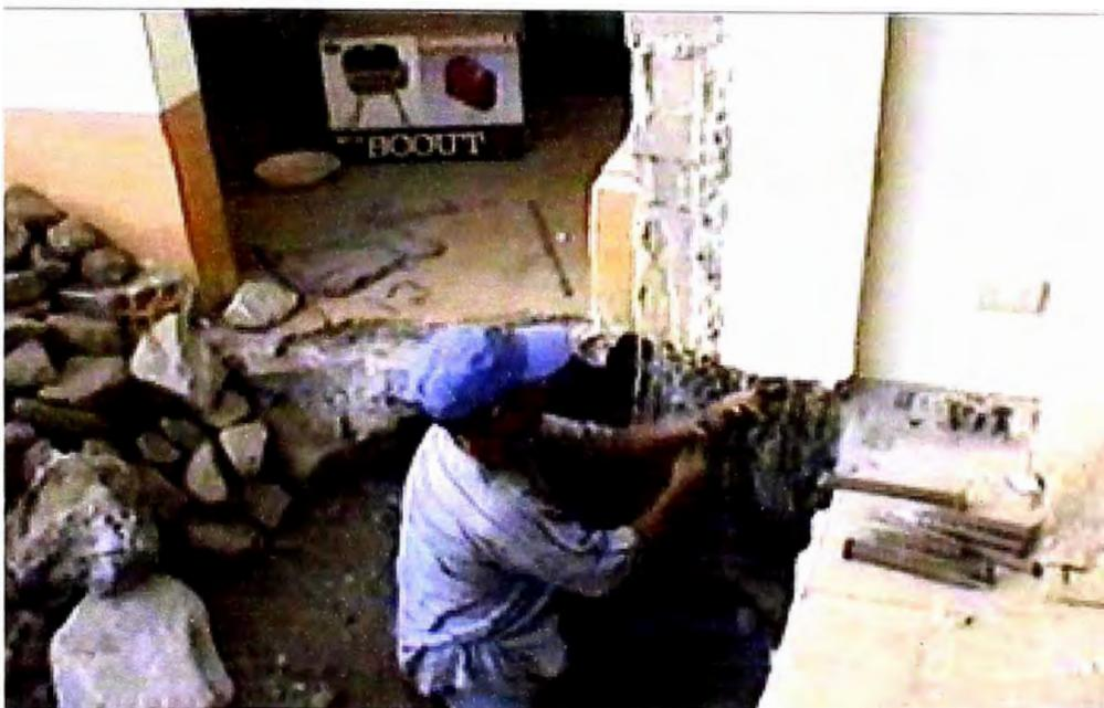
**REFORZAMIENTO** .- Se muestra que algunas columnas existentes, serán reforzadas según lo establecido por el Ing. Estructural, teniendo que empalmar entre 60 a 80 cm. según sea el diámetro del acero.
