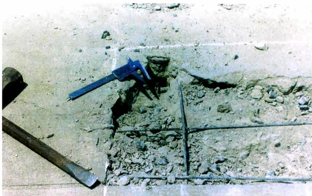
**Foto 11.-** Se hizo la verificación de la losa aligerada encontrándose que el refuerzo de las viguetas es el que se indican en el plano de losa aligerada. También sobre la losa aligerada se ha vaciado una losa armada de 5 cm de espesor que sirve de protección al techo.
