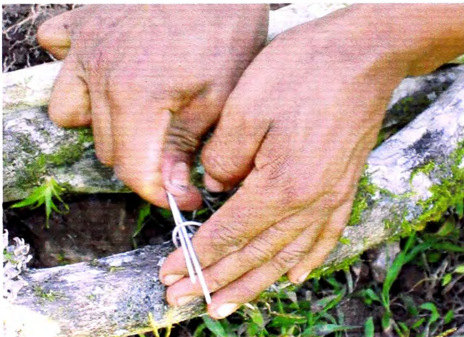
Figura N° 3.04 Amarre de fajinas con alambre
