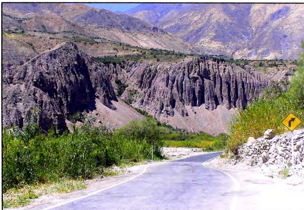
KM 99+530 – SE OBSERVA DESLIZAMIENTO DE MATERIAL SUELTO
