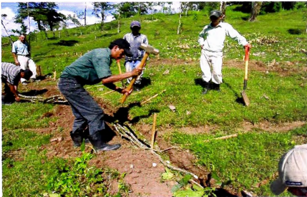
Figura N° 3.06 Fijación con estacas de madera
