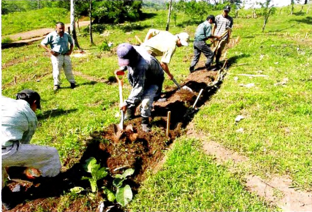
Figura N° 3.08 Disposición horizontal de las fajinas
