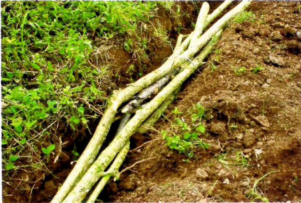
Figura N° 3.06 Fijación con estacas de madera
