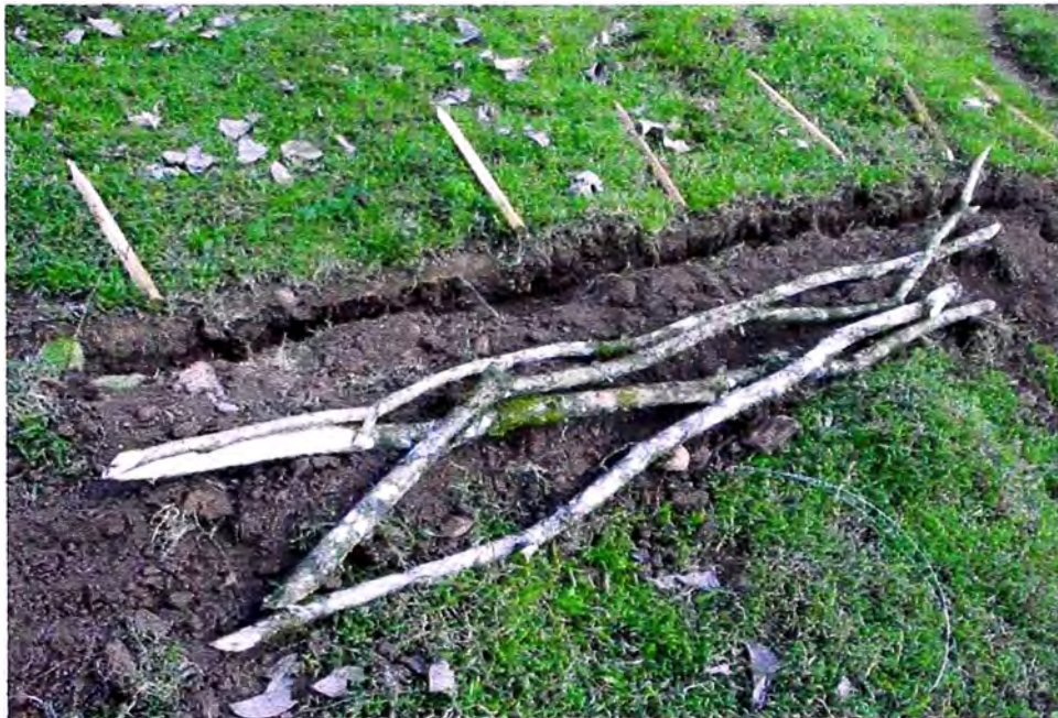
Figura N° 3.03 Habilitación de fajinas de ramas vivas
