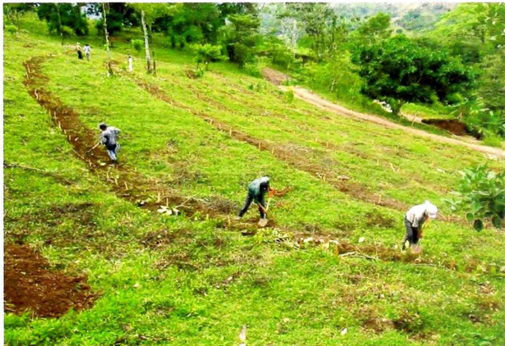
Figura N° 3.08 Disposición horizontal de las fajinas
