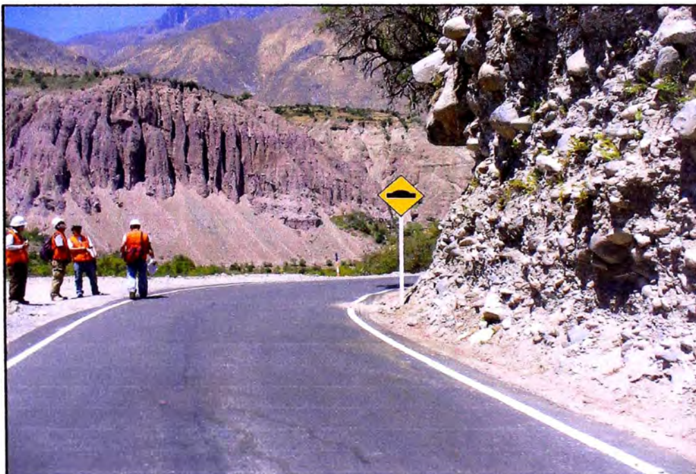
KM 102+500 - SE OBSERVA MALA VISIBILIDAD EN LA CURVA
