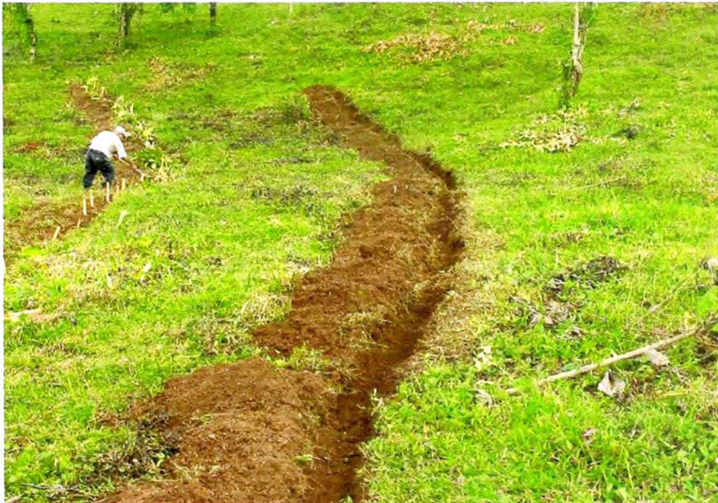
Figura N° 3.02 Excavación de terreno para la construcción de fajinas
