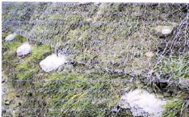
**Gráfico N° 3.22**– Fijado de la Biomanta en la parte superior del talud.
