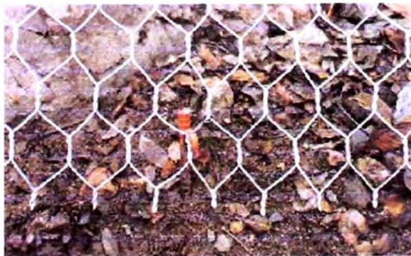
**Gráfico N° 3.21**– Fijado de la Biomanta en la parte superior del talud.
