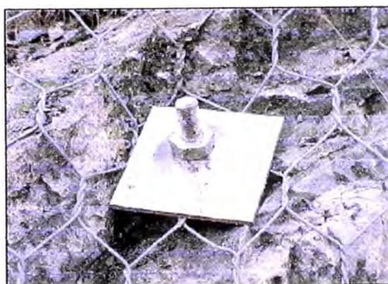
**Gráfico N° 3.19** – Anclaje en la parte mediana del talud compuesto por una varilla de construcción fileteada ( $\varnothing$  20-30mm, L = 1,0 –1,5m), una placa metálica (12 x 12 cm.) con tuerca de fijación, colocada en una perforación de la roca y fijada con resina o mortero. Usado en rocas sanas, compactas, duras y sujetas a meteorización.
