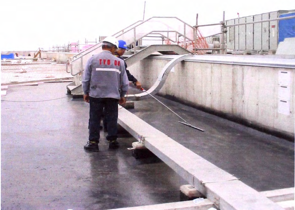
Foto N° 04 - Prueba de Holliday.- En esta prueba se mide la continuidad de la electricidad a través de un aparato que emite un sonido cada vez que encuentra zonas donde el líquido impermeabilizante no ha penetrado de manera correcta.
