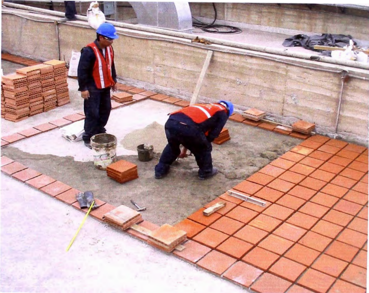
Foto N° 08 - Asentado de ladrillo pastelero.- Se realizó con una plantilla previamente definida, y dejando cada 9m2 espacio suficiente para sellar las juntas de dilatación con emulsión -arena.
