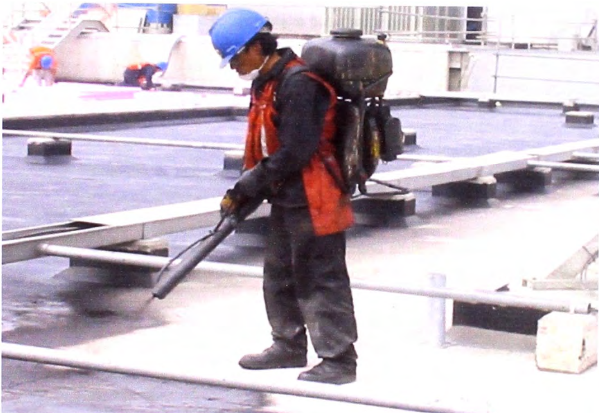
Foto N° 02 - Imprimación.- Se observa como el operario aplica el líquido imprimante sobre la superficie del techo. Antes de la aplicación del mismo se ha limpiado la superficie del techo con compresora de aire.
