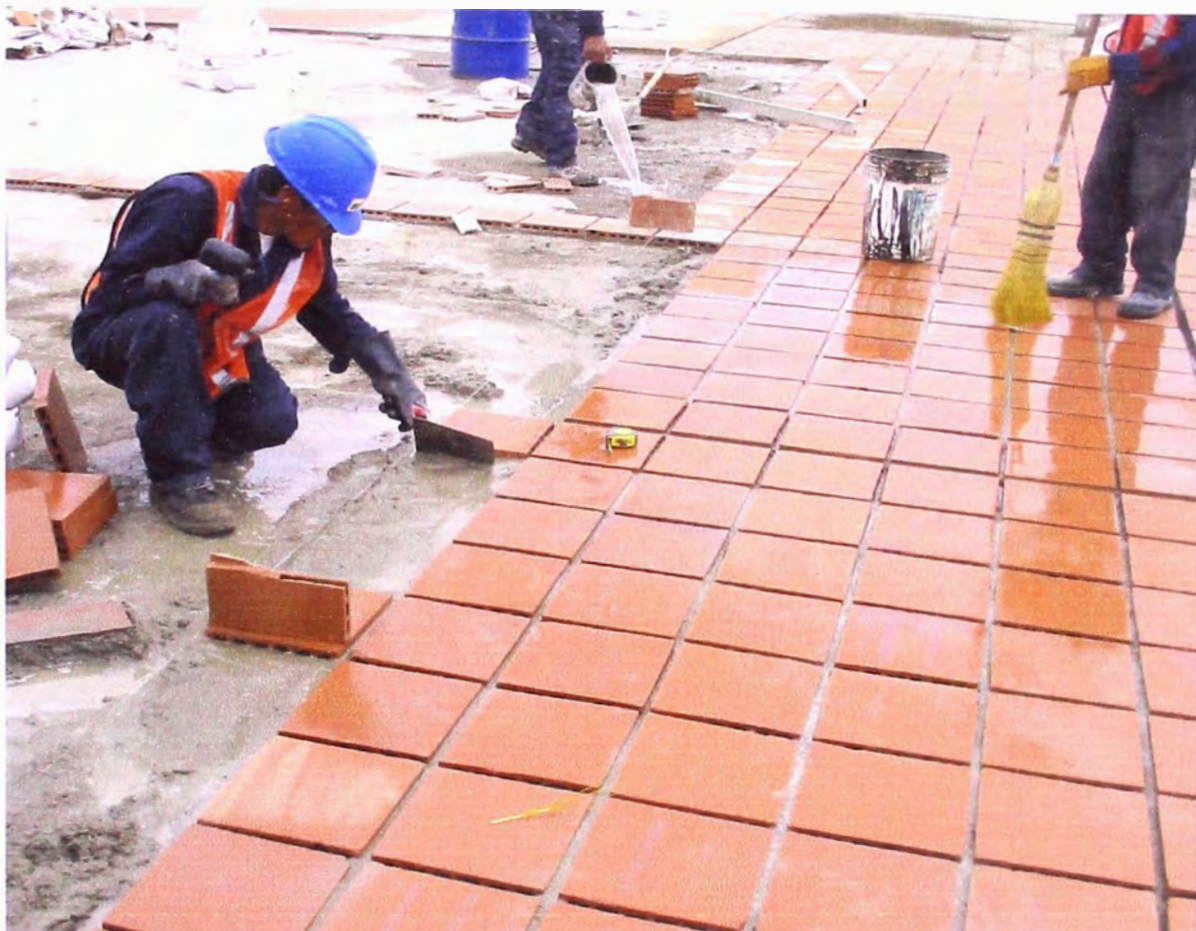
Foto Nº 09 - Asentado de ladrillo pastelero.- Se observa el asentado en la zona del Concourse. El ladrillo se asienta sobre la capa de concreto ligero.
