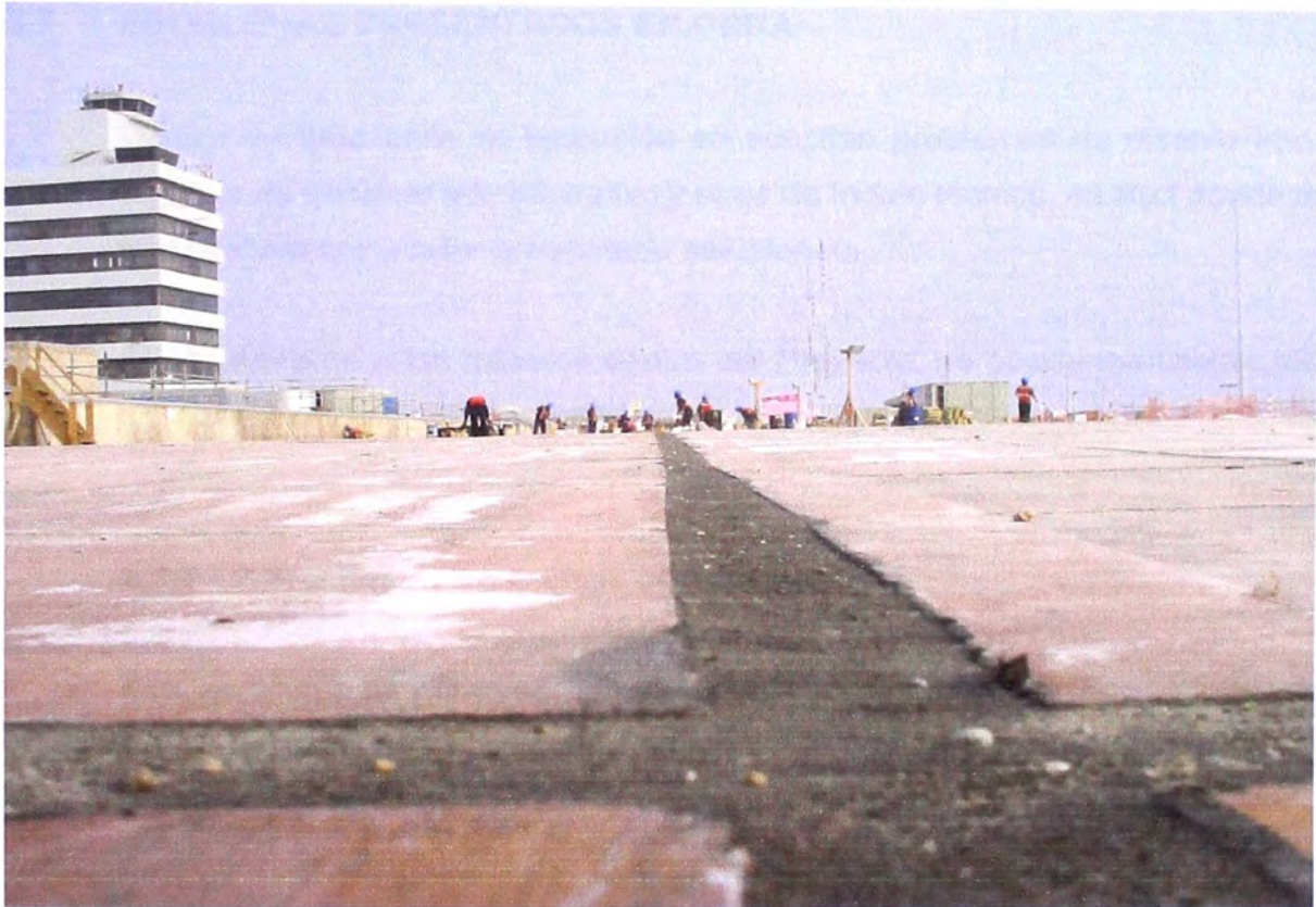
Foto N 12 - Juntas de dilatación colocadas.- Se puede apreciar el mortero de emulsión-arena colocado sobre el corte realizado sobre el ladrillo pastelero.
