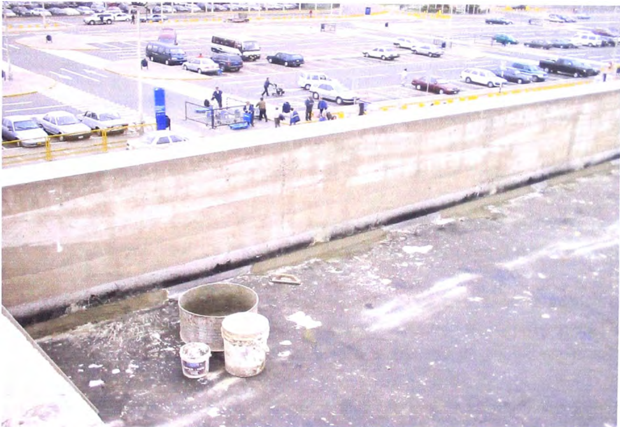
Foto Nº 01 - Faja en chaflán.- El trabajo a ejecutarse en la zona de encuentro entre losa y sardineles, se construyó con mortero en una relación cemento arena 1:5 en peso.
