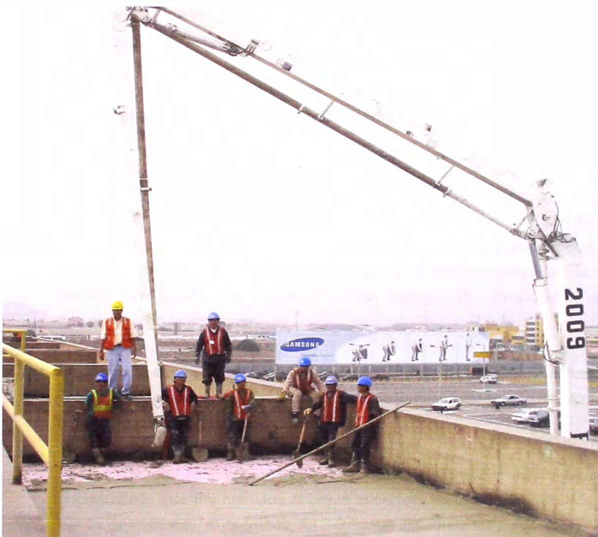
Foto N° 07 - Vaciado de concreto.- Se realizó con camiones mixers y además se empleó bombas de concreto para alcanzar la altura requerida.
