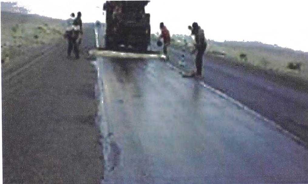
Foto colocación de Mortero Asfáltico mecanizado (Slurry Seal tipo II)
