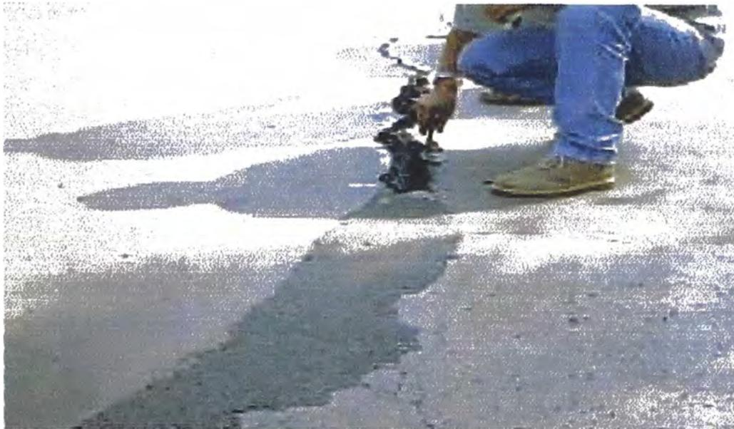
**Foto Sello de grietas con mortero asfáltico**
