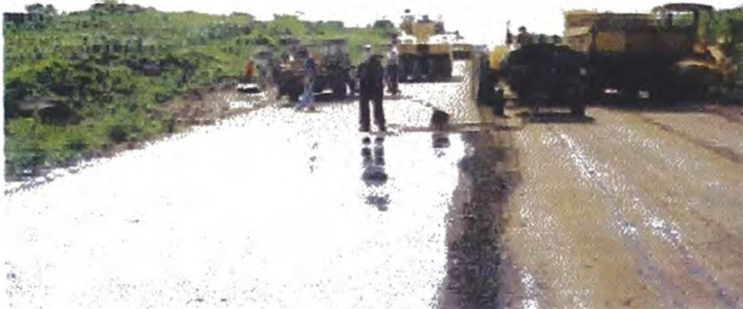
**Foto: Imprimación con Emulsión Asfáltica**
