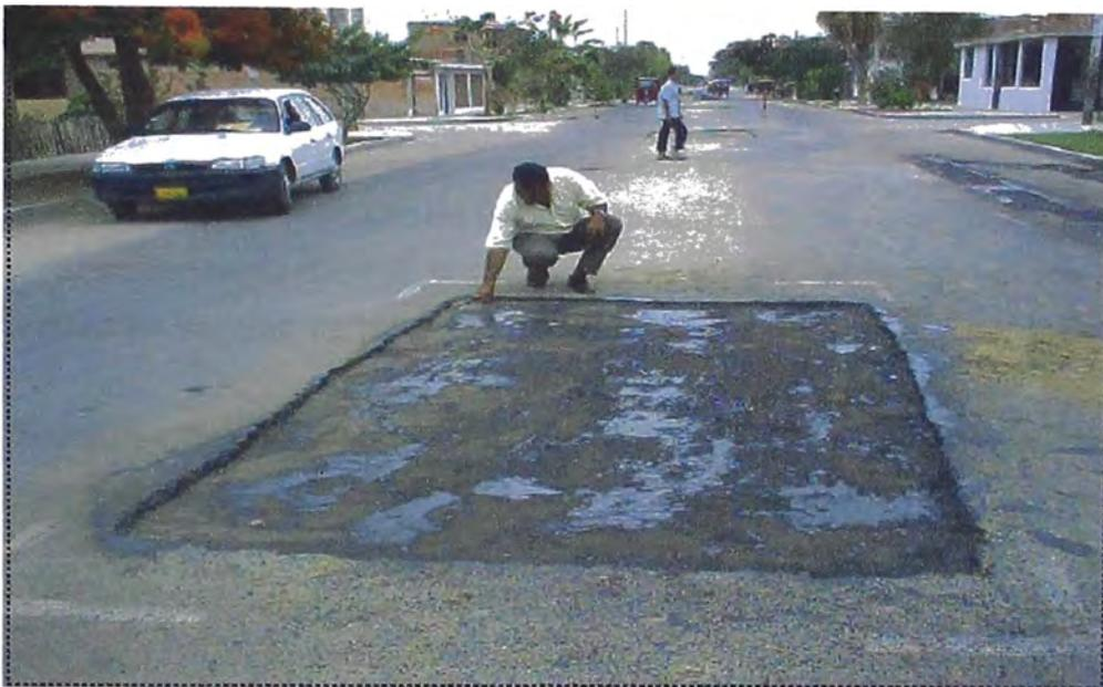
**Foto: Imprimación Con Emulsión Asfáltica para Parches**
