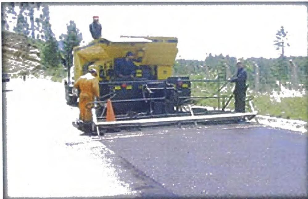
**fig. Proceso de colocado del Micropavimento Asfáltico Mecanizado**
