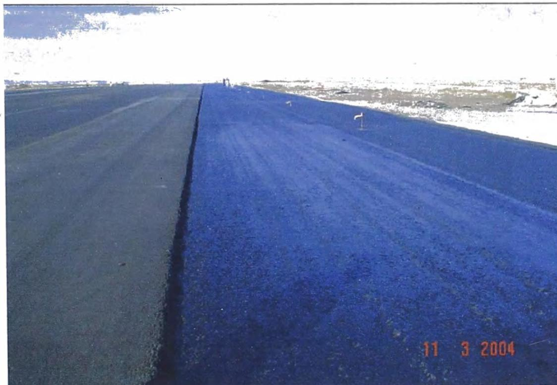
**Foto: Riego de Liga para posterior colocado de Mortero Asfáltico**
