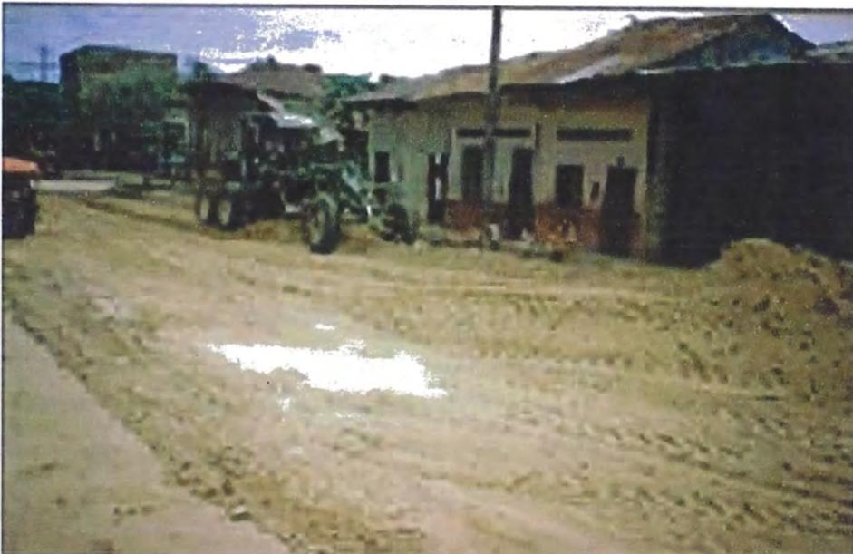
**Foto: conformación de base estabilizada con emulsion**
