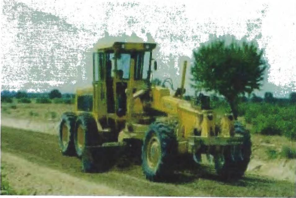
**Foto: conformación de base estabilizada con emulsión Asfáltica**
