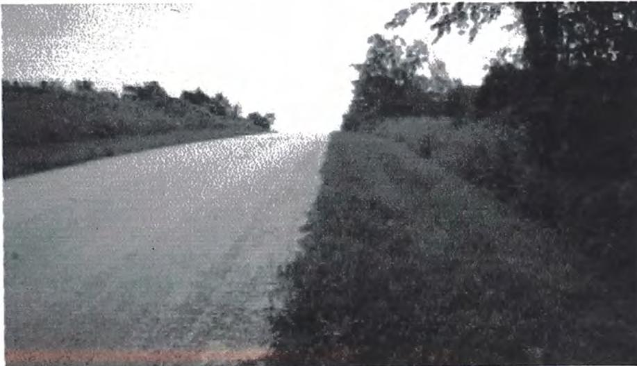
Foto: Acabado después de colocado Coat Seal
