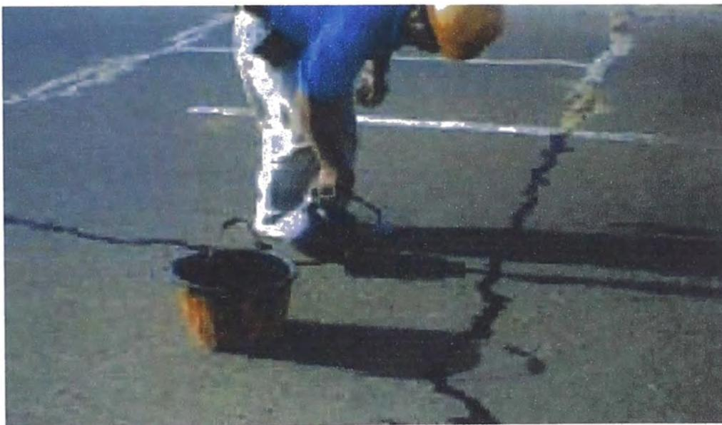
**Foto Sello con emulsión previo al mortero aplicado (Slurry Seal tipo II)**
