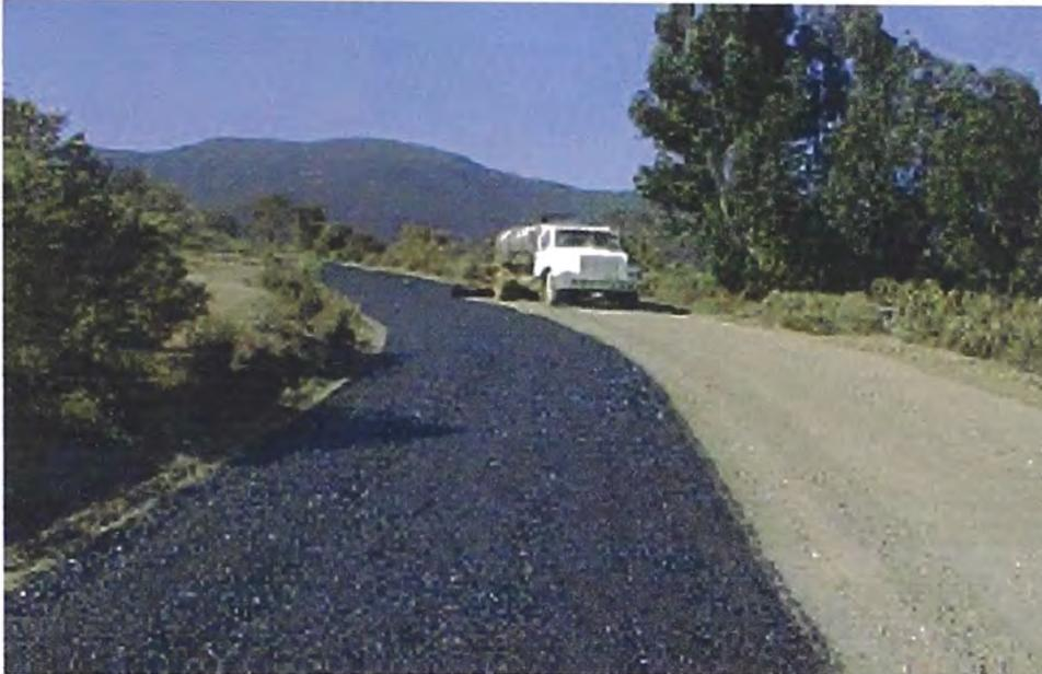
**Foto: Segundo Riego para colocacion de la segunda Capa del Tratamiento**
