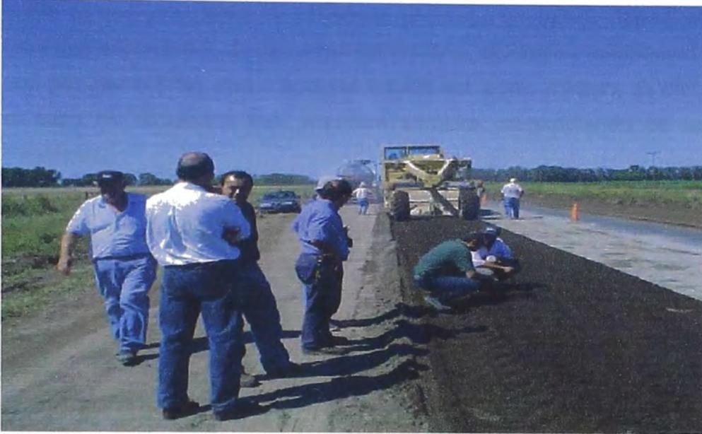
**Foto: Colocación del Asfalto en frío**
