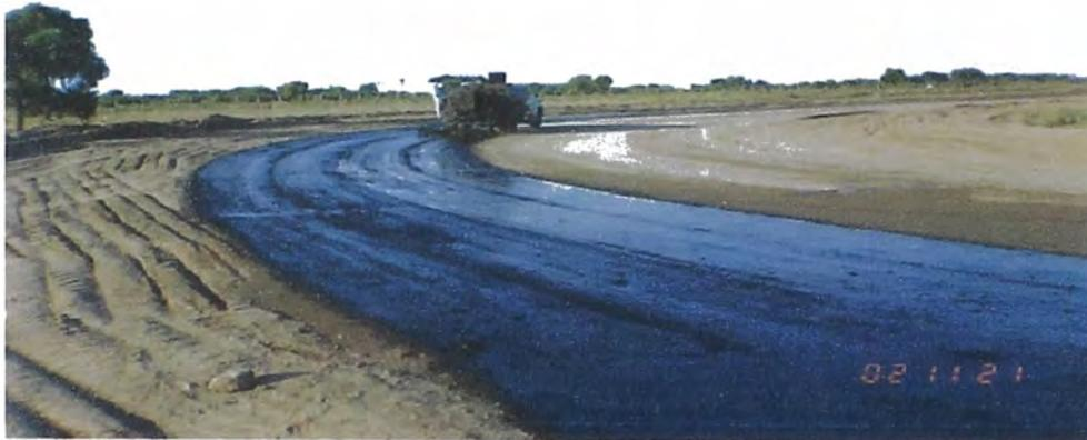
**Foto: Imprimación Con Emulsión Asfáltica**
