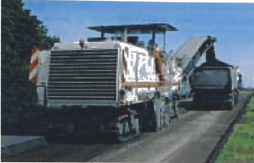
**Foto Maquina Fresadora en el proceso Constructivo del reciclado en frío**
