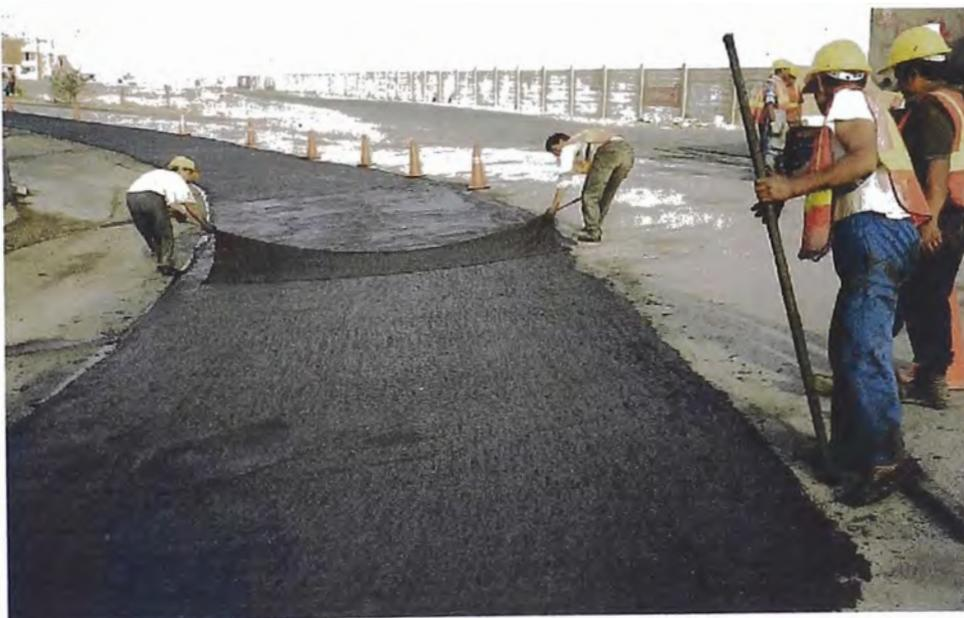
**Foto: Proceso de colocado del Mortero Asfáltico manual**
