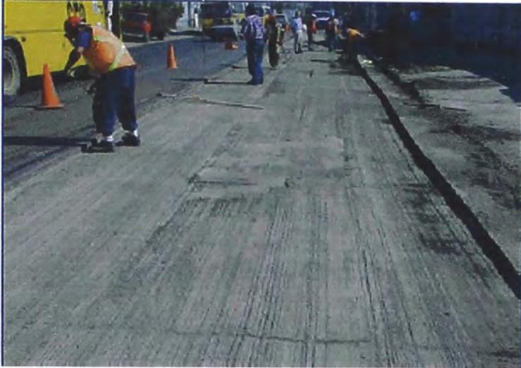
**Foto: Carpeta Asfáltica Fresada**
