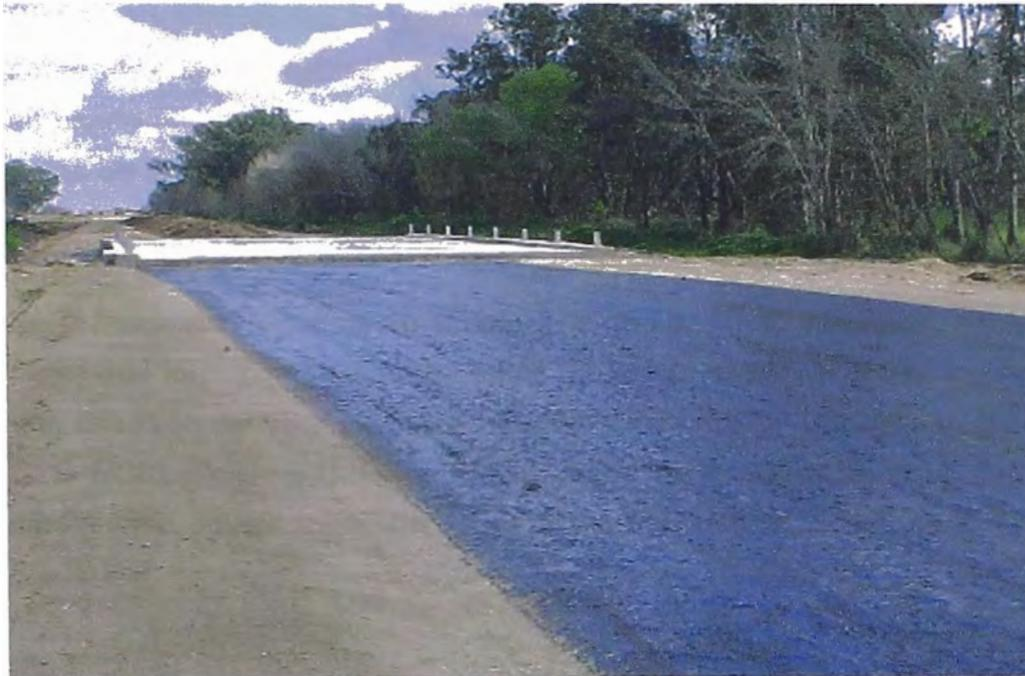
Foto: Riego de curado en Base Estabilizada
