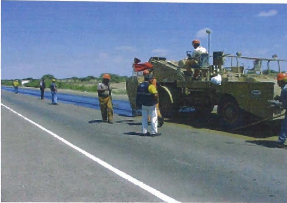
**Foto: Colocación del Agregado**
