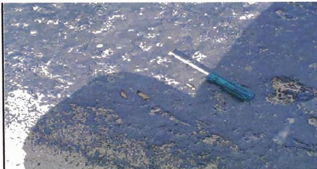
Foto: textura después del riego de curado
