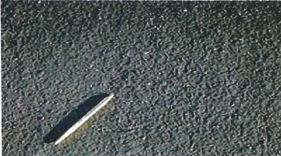
**Foto Textura del acabado de una Lechada Asfáltica**
