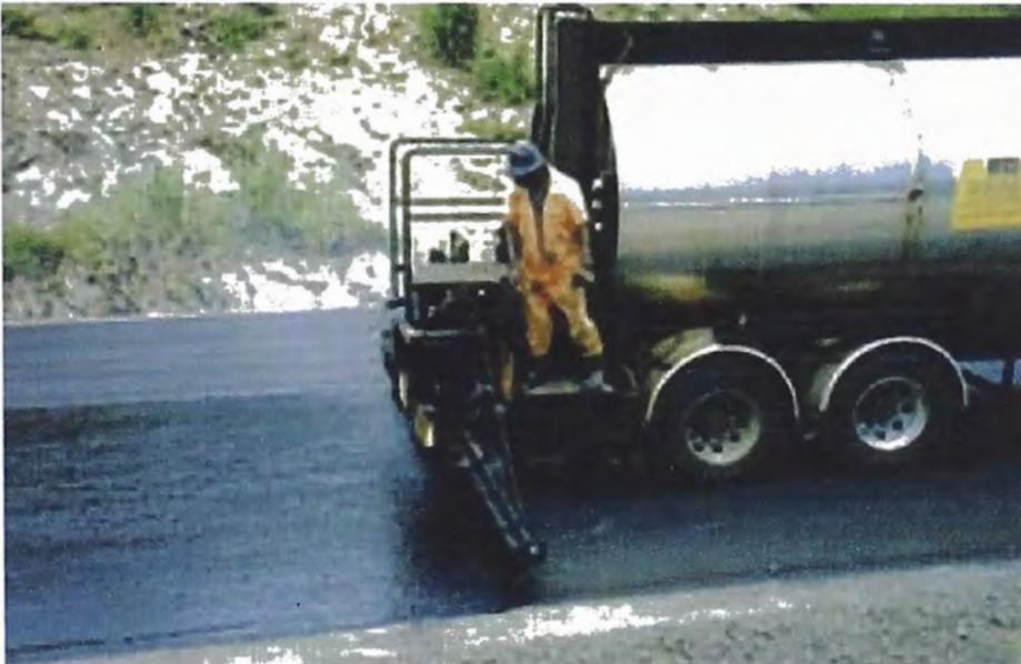
**Foto: Riego Fog Seal con camión imprimador.**
