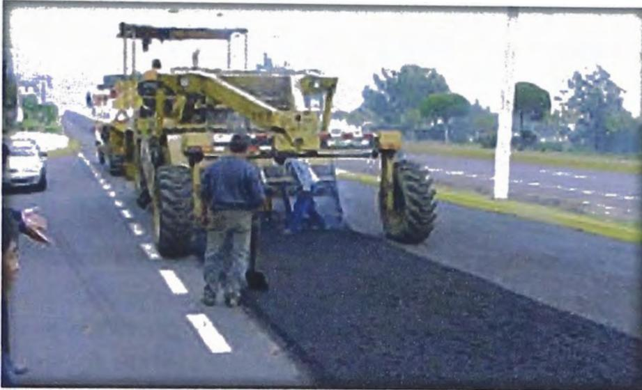
**Foto: Estabilización y mezcla con emulsión Asfálticas**
