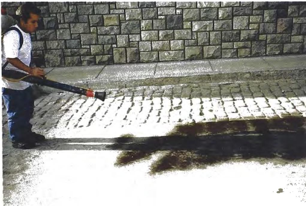
Foto: Riego de Liga Manual sobre pavimento existente
