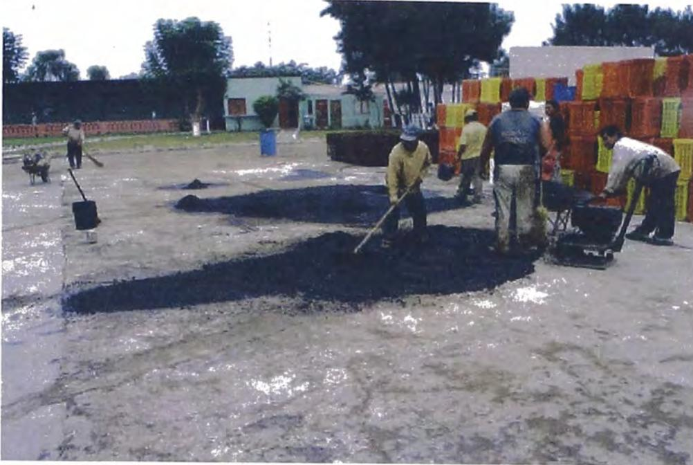
**Foto Bacheo de una Planta Industrial Con Emulsion Asphaltica**
