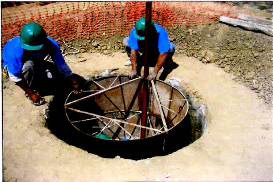
FOTO N°02 ENCOFRADO DE BUZON
