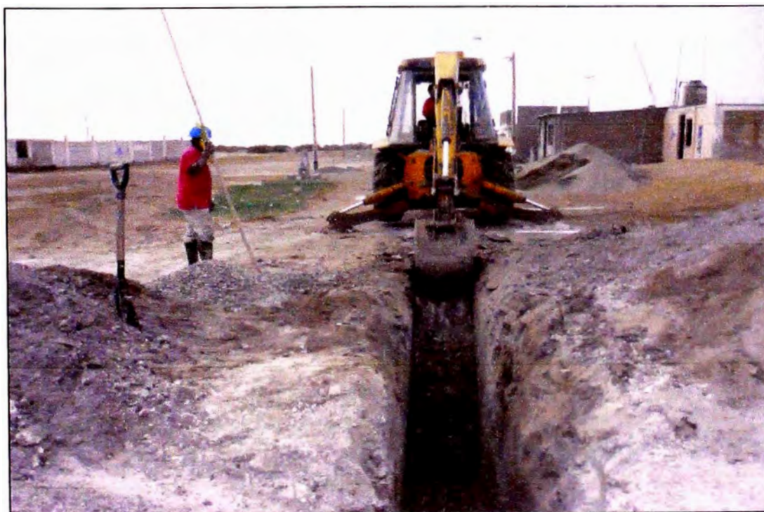
FOTO N° 06 EXCAVACION DE ZANJAS EN COLECTORES
