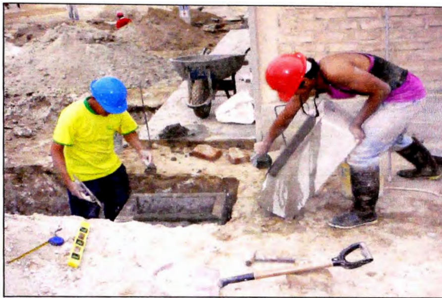
FOTO N°12 COLOCACION DE CAJAS DE DESAGUE
