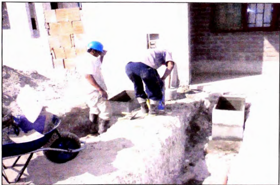
FOTO N°15 TARRAJEO DE CAJAS DE DESAGUE
