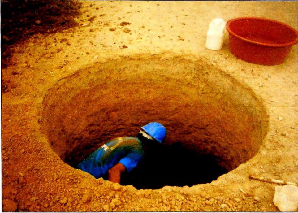
FOTO N°01 EXCAVACION MANUAL DE BUZON
