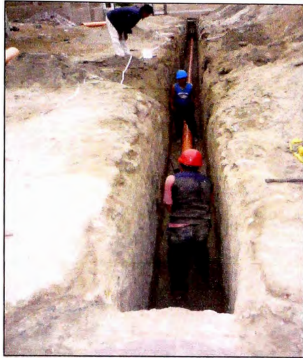
FOTO N°07 COLOCACION DE TUBERIA EN EL COLECTOR
