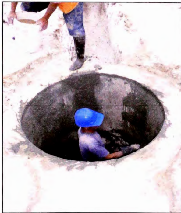
FOTO N°08 TARRAJEO DE BUZON
