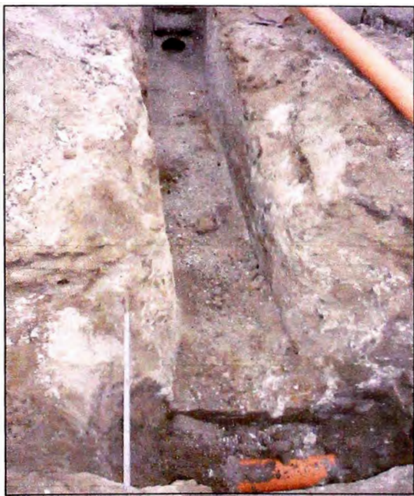
FOTO N°13 EXCAVACION DE ZANJAS
