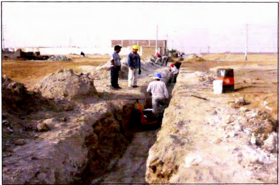
FOTO N°10 RELLENO DE ZANJAS
