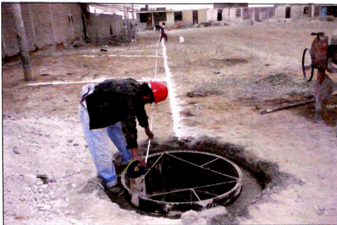
FOTO N°05 TRAZO DEL COLECTOR LISTO PARA EXCAVAR LA ZANJA
