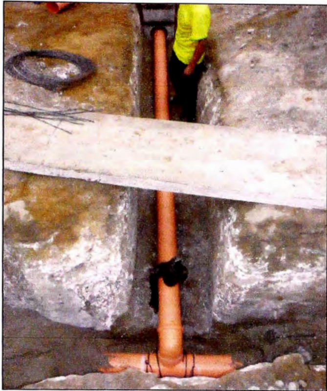
FOTO N°14 INSTALACION DOMICILIARIA DE ACCESORIOS
