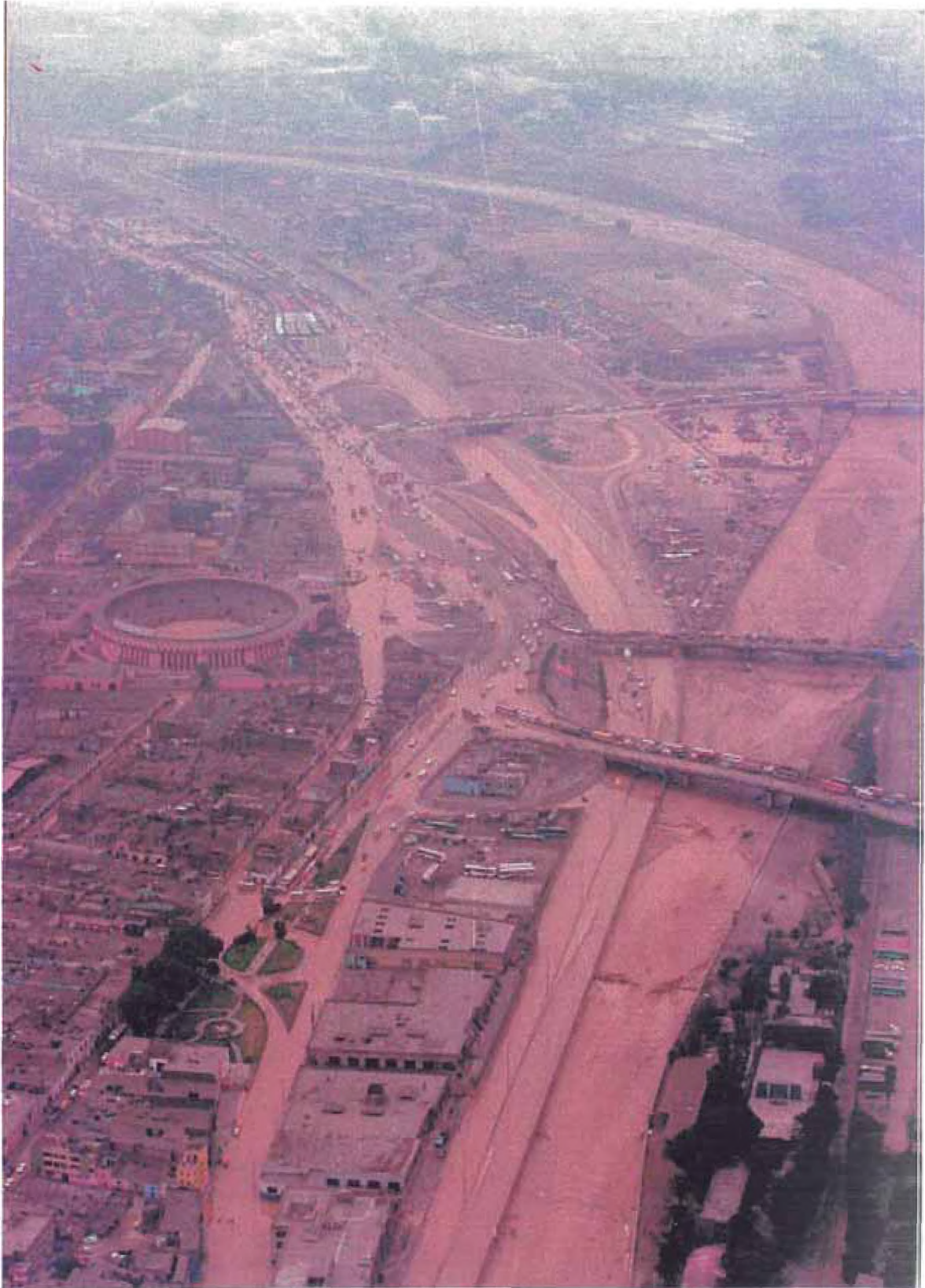
Vista área del desborde de la Quebrada Huaycoloro y el río Rímac (febrero 1998)
