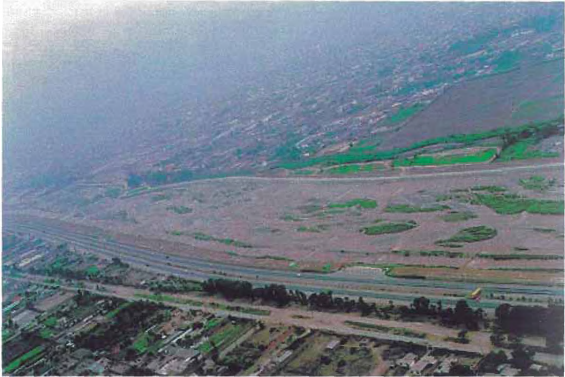
Vista aérea desde del sitio de estudio hacia el río Rímac. Se observa uno de los miradores construido por SEDAPAL
