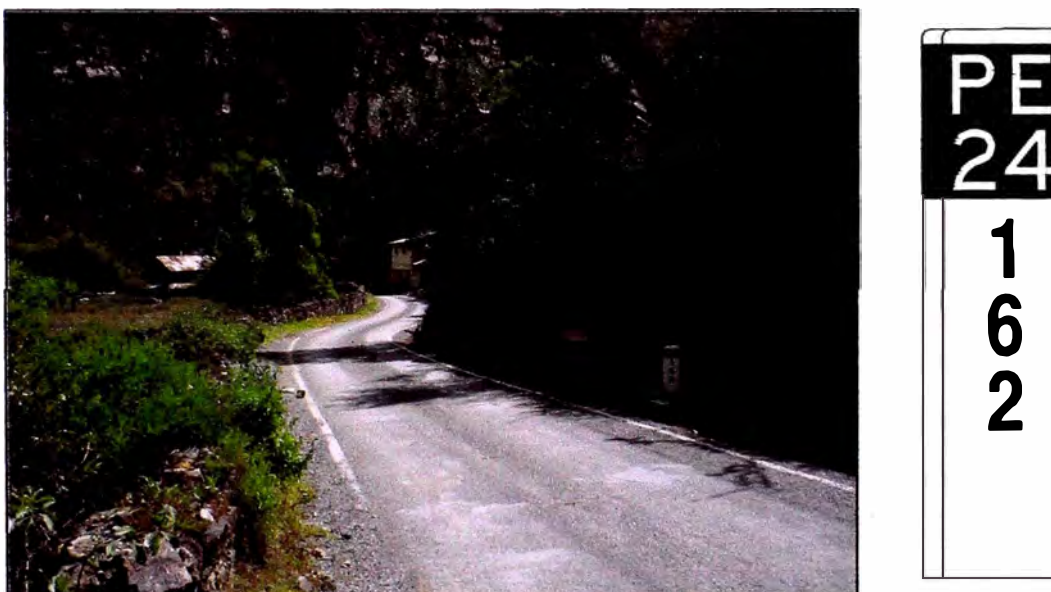
Figura N° 2.21: Poste de Kilometraje de número par ubicada km 162+000 LI
