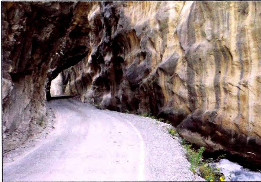
Figura N° 2.06: Carretera Cañete-Huancayo, km 171+250 Cañón de Uchco, corte a medio túnel con ancho de plataforma menor de 3 m y altura limitada de 3.5 m.
