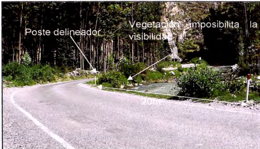
Figura N° 2.24: Espaciamiento entre postes delineador de 20m, km 171+800 LI
