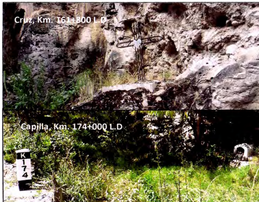
Figura N° 2.33: Capillas y Cruces ubicadas en el Sector de monitoreo
