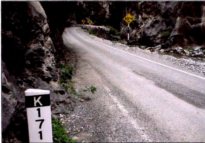
Figura N° 2.07: Carretera Cañete-Huancayo, km 171+050
