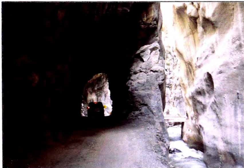
Figura N° 2.12: Túnel L=30m, fin del sector Cañón de Uchco
