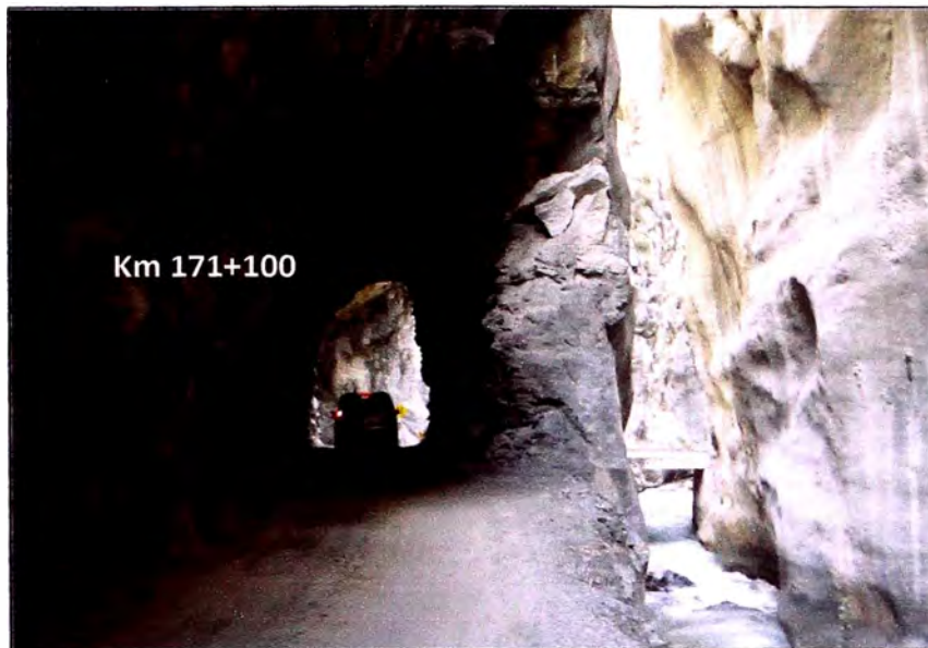
Figura N° 2.27: Continuación, Pintura de borde cubierta y despintada
