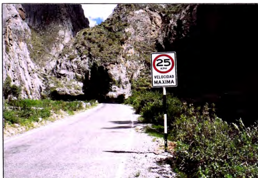
Figura N° 2.15: Panel señal R-30, conforme al Manual de Tránsito km 171+700
