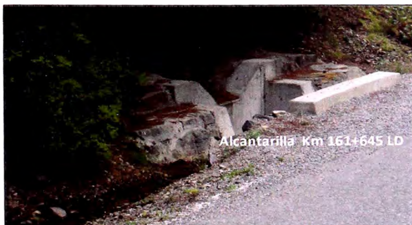
Figura N° 2.29: Alcantarilla y Pontón sin recubrimiento con pintura
