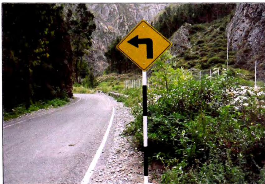
Figura N° 2.8: Carretera Cañete-Huancayo, km 171+700 LI
