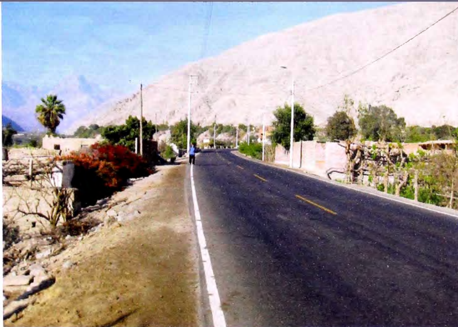
Foto N° 6: Se observa la carretera Cañete-Yauyos, por la berma de la margen izquierda se realizara la excavación para la colocación de la tubería de distribución principal.
