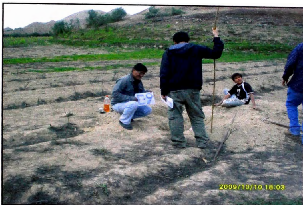
C-09 VISTA PARCIAL DE LA CALICATA EN PLENA EXCAVACIÓN Nº 09
