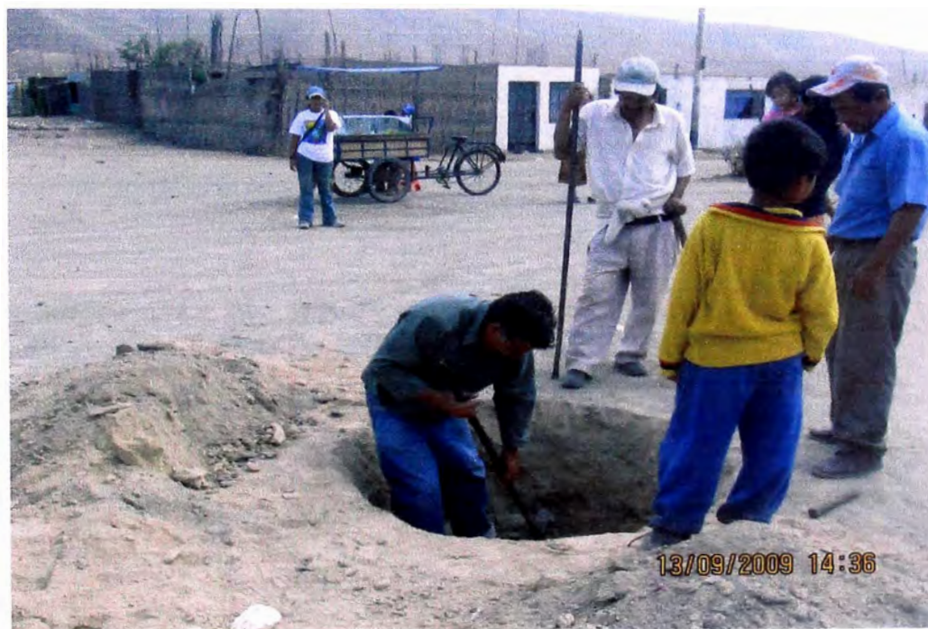
C-04 EXCAVACIÓN DE LA CALICATA Nº 04
