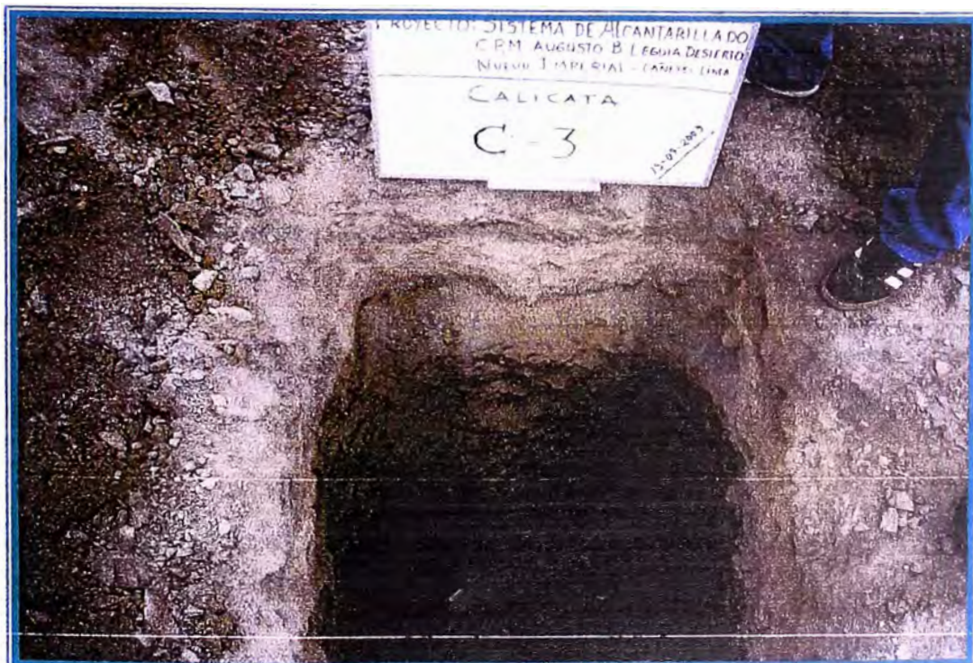
Foto N° 4: Vista del interior de la calicata C3, observándose los suelos granulares encontrados, así como las cementaciones (caliches) de difícil excavación manual.
