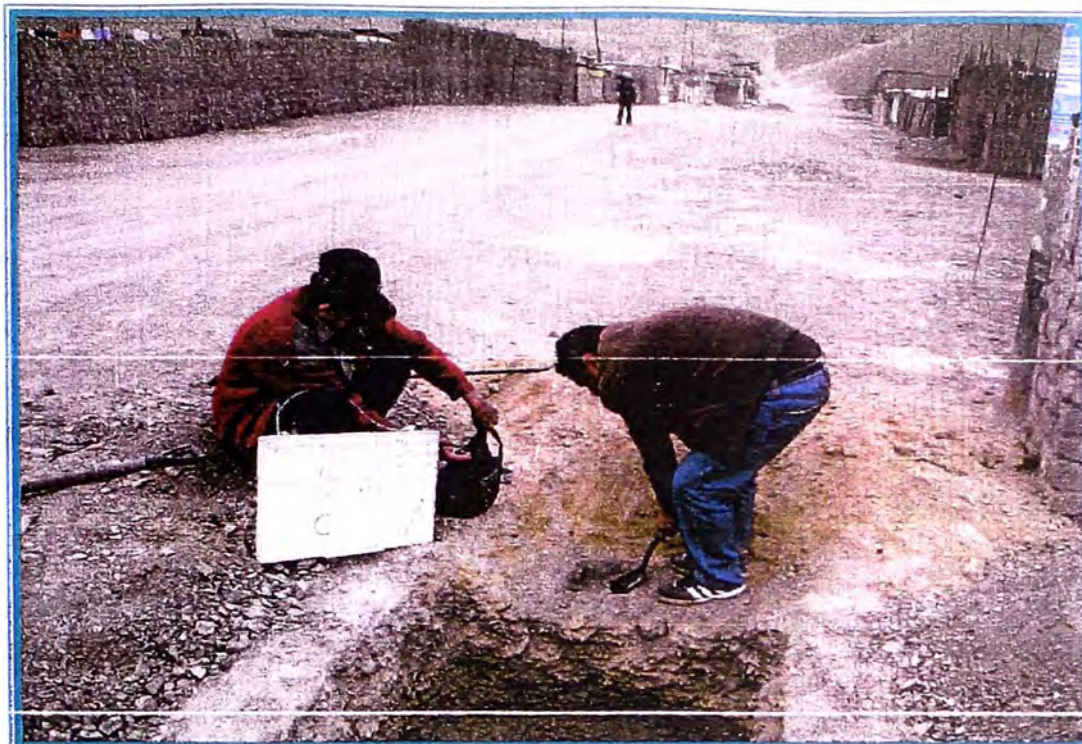
Foto N ° 25: Vista panorámica de la ubicación de la calicata C11, observándose la toma de densidad natural por el método de reemplazo de agua.
