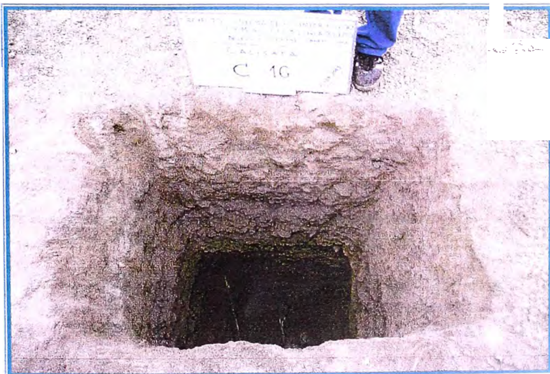
Foto N ° 36: Vista del interior de la calicata C16, observándose los suelos granulares encontrados.
