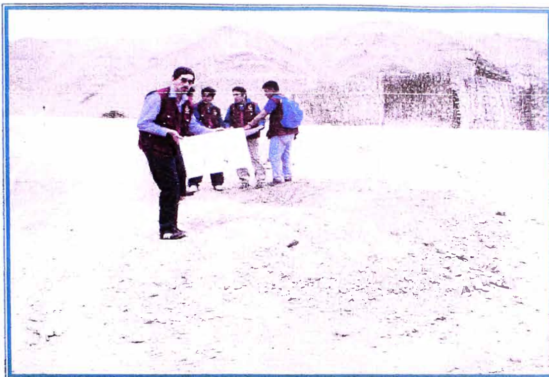
Foto N ° 5: Vista panorámica de la ubicación de la calicata C4, observándose los suelos encontrados.
