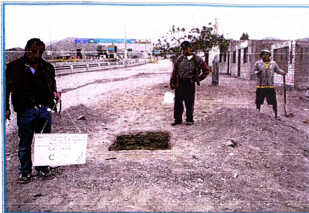
Foto N ° 19: Vista panorámica de la ubicación de la calicata C9, observándose los suelos granulares encontrados.
