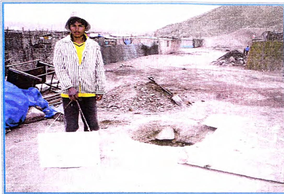
Foto N ° 39: Vista panorámica de la ubicación de la calicata C18, observándose los suelos y fragmentos de rocas encontrados.
