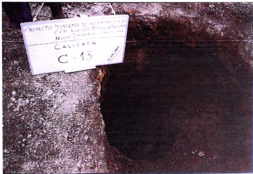
Foto N ° 32: Vista del interior de la calicata C13, observándose los suelos granulares encontrados con cementaciones
