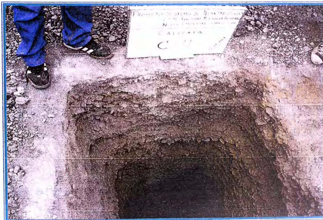
Foto N ° 24: Vista del interior de la calicata C11, observándose los suelos granulares encontrados.
