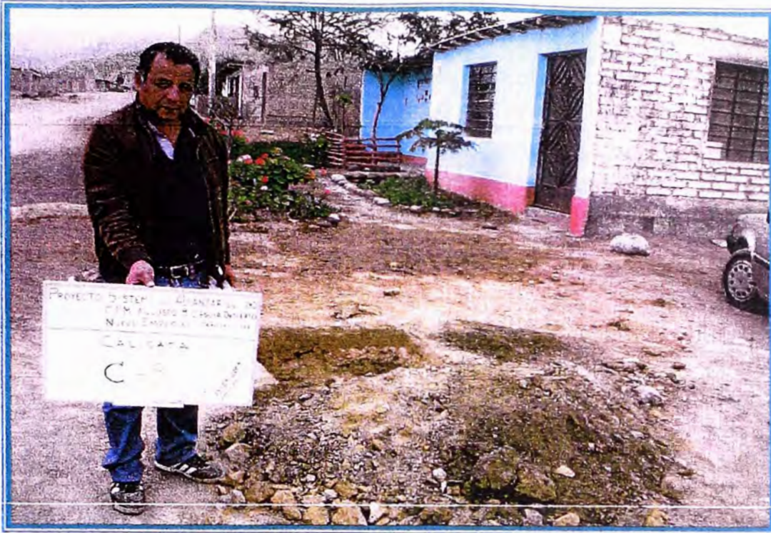
Foto N ° 17: Vista panorámica de la ubicación de la calicata C8, observándose los suelos granulares encontrados cementados.
