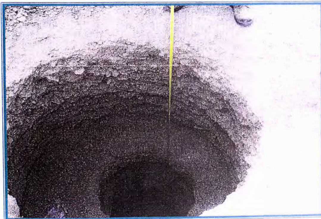
Foto N ° 14: Vista del interior de la calicata C6, observándose los suelos granulares encontrados.
