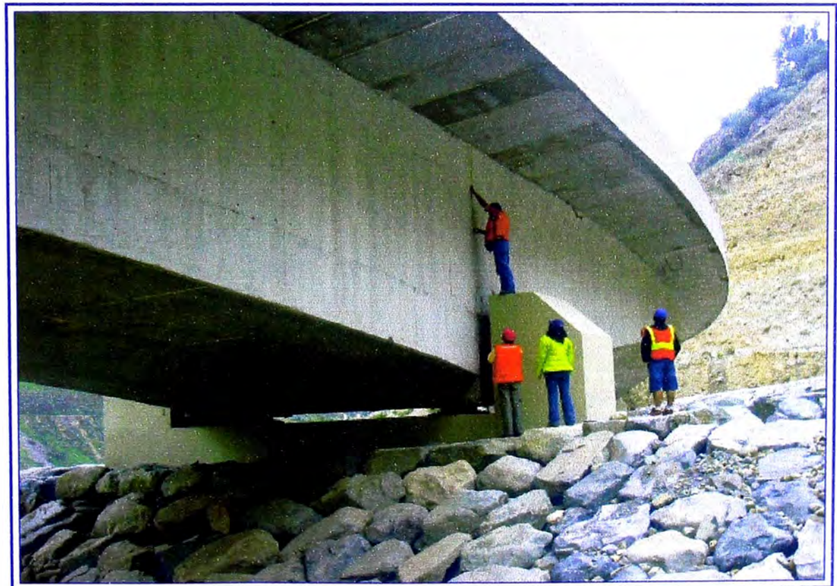
Foto N°4: Puente Collana; se observa la superestructura, el pilar izquierdo tipo tarjeta, los aparatos de apoyo tipo freysinets y el enrocado de protección. Esta obra de gran importancia son diseñadas considerando periodo de retorno de 100 años.
