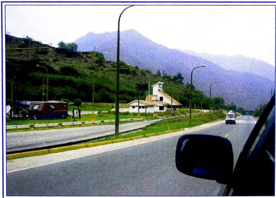
Foto N°6: Estación de Pesaje. Para el pesaje el vehículo pasa por el control con una velocidad lenta, se registra en pantalla la placa del vehículo y el peso individual de cada eje. Luego haciéndose la suma total se define si el vehículo cumple con la capacidad de su peso.
