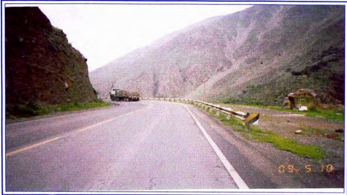
Foto N°7: Km. 59+900, se observa el agrietamiento longitudinal de la carpeta asfáltica, prematuramente, posiblemente sea producto de un insuficiente espesor de carpeta asfáltica o inadecuada dosificación, ó mala practica de colocación; ya que no hay hundimiento en la zona adyacente
