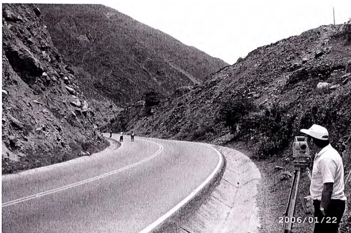
**Foto 03.-** Curva 101, Km. 72+400, levantamiento topográfico y chequeo de la visibilidad de parada in situ.
