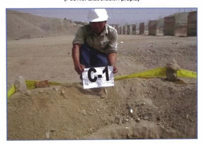
Foto Nº 2.01. Excavación de la calicata C-1.
