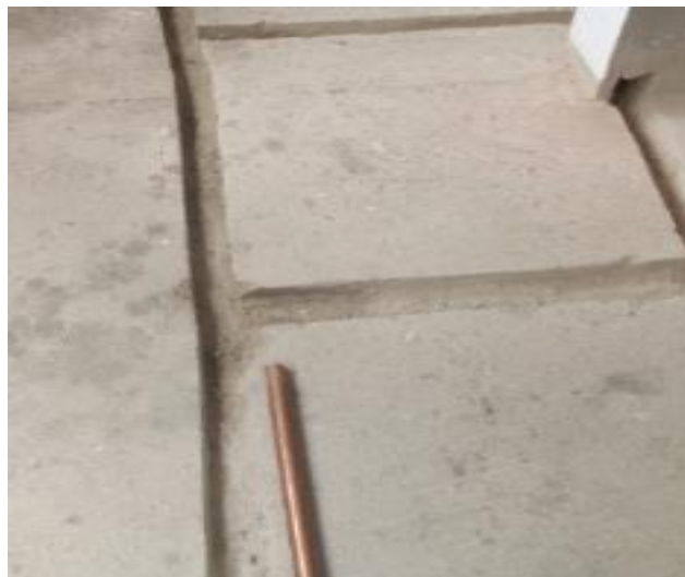
Figura N°5.18 Ancho y profundidad de picado excesivo para conexión de gas Fuente: Elaboración propia
