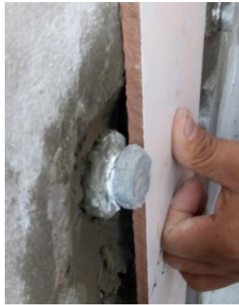
Figura N°5.22 Correcciones sanitarias teniendo en cuenta el espesor de enchape Fuente: Elaboración propia
