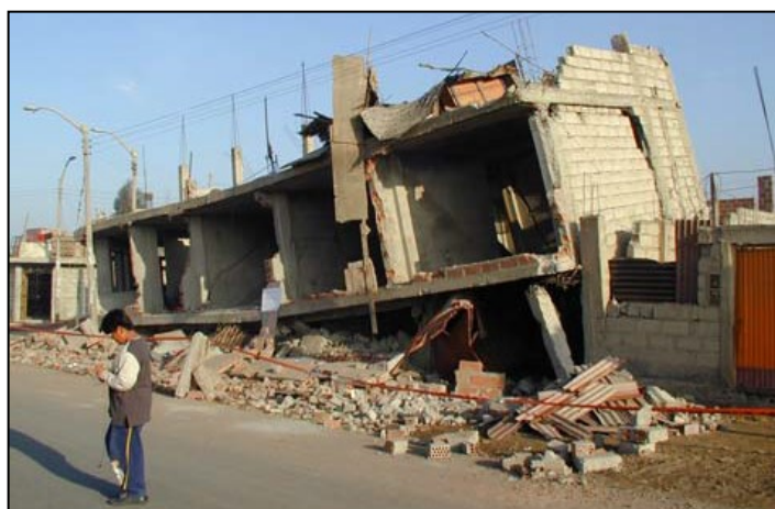
Figura 4.8 En Tacna casas construidas sobre relleno no consolidado colapsaron, la mayoría por el efecto de columna corta.
