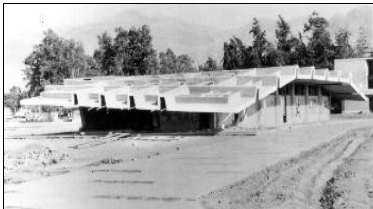
Figura 4.5 Colapso de uno de los laboratorios de la Universidad Agraria La Molina
