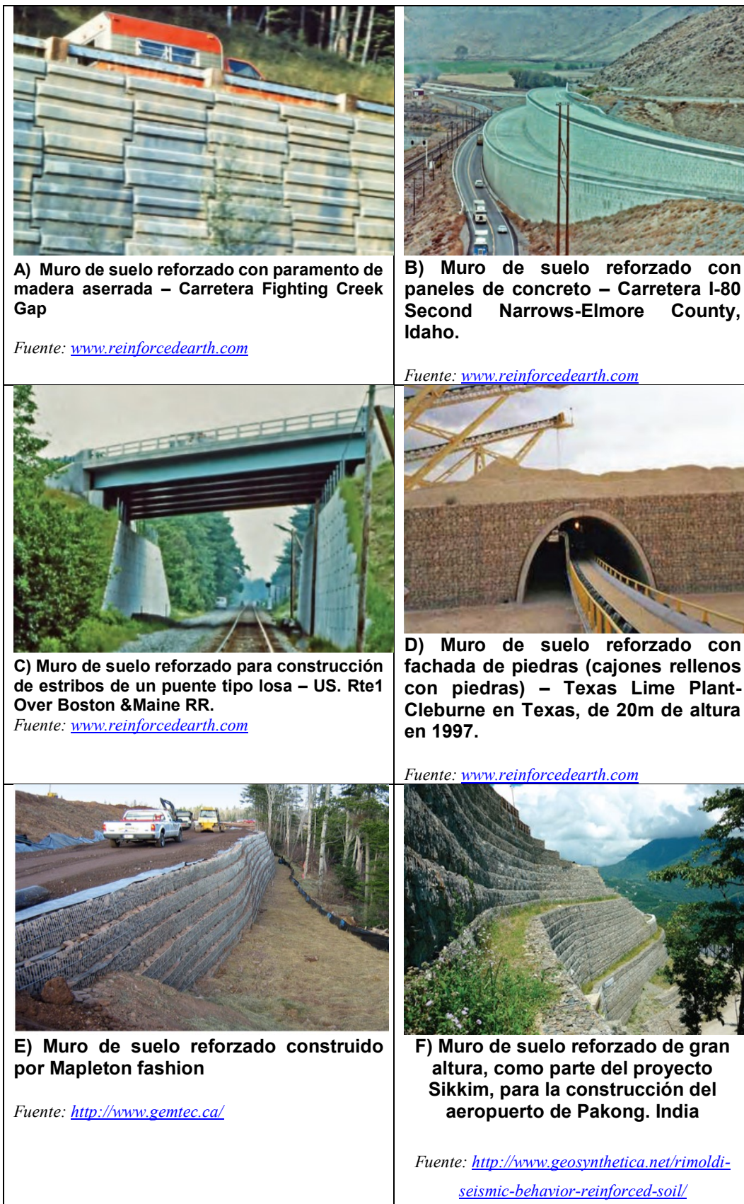
Figura 1.1 Tipos de muros de suelo reforzado
