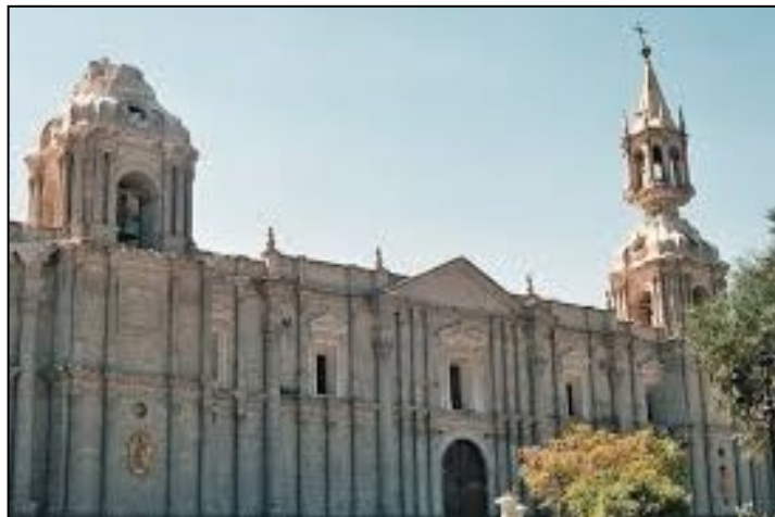
Figura 4.6 Catedral de Arequipa, estructura que presentó el mayor daño en la ciudad.
