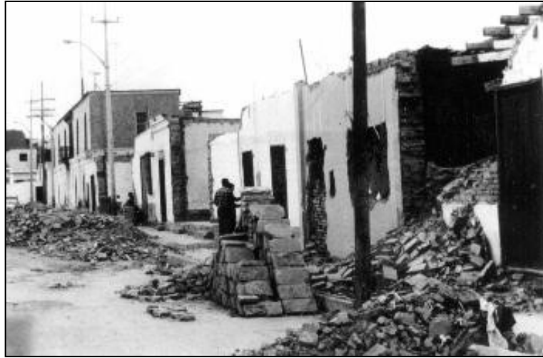
Figura 4.3 Chorrillos luego del terremoto de 1974.
