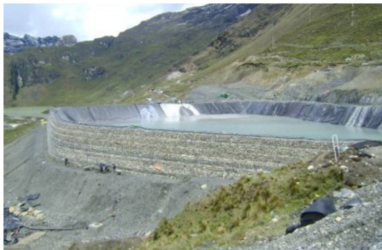
Figura 1.3 MSR instalado para el depósito de relaves Minera Sinaycocha, subsidiaria de Atacocha en Pasco, Perú, de 8 m de altura.
