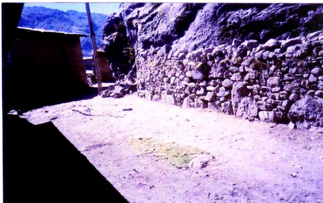
Estado de la vía al paso por la localidad de Pisacha
