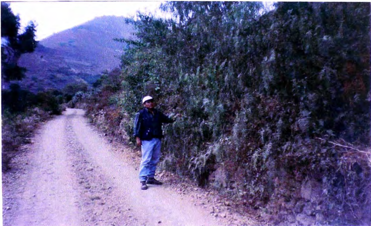
Invasión de la vía por la crecida de arbustos, estado de la vía, se muestra el estado de la superficie de rodadura antes del trabajo de rehabilitación
