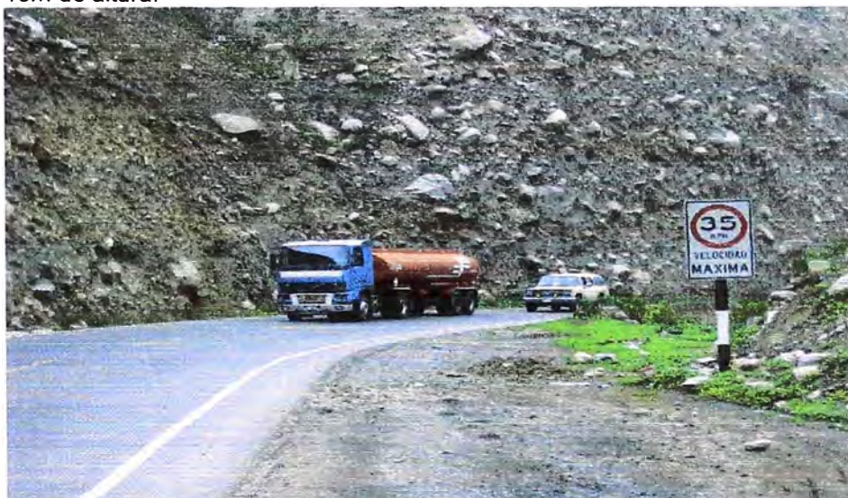
Figura N° 2 Lado derecho de la vía se aprecia depósito coluvio aluvial, de más 18m de altura.
