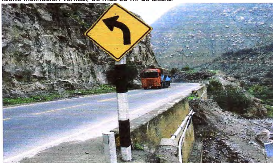
Figura N° 3 Lado derecho de la vía se aprecia material de roca riodacitas con fuerte inclinación vertical, de más 20 m. de altura.
