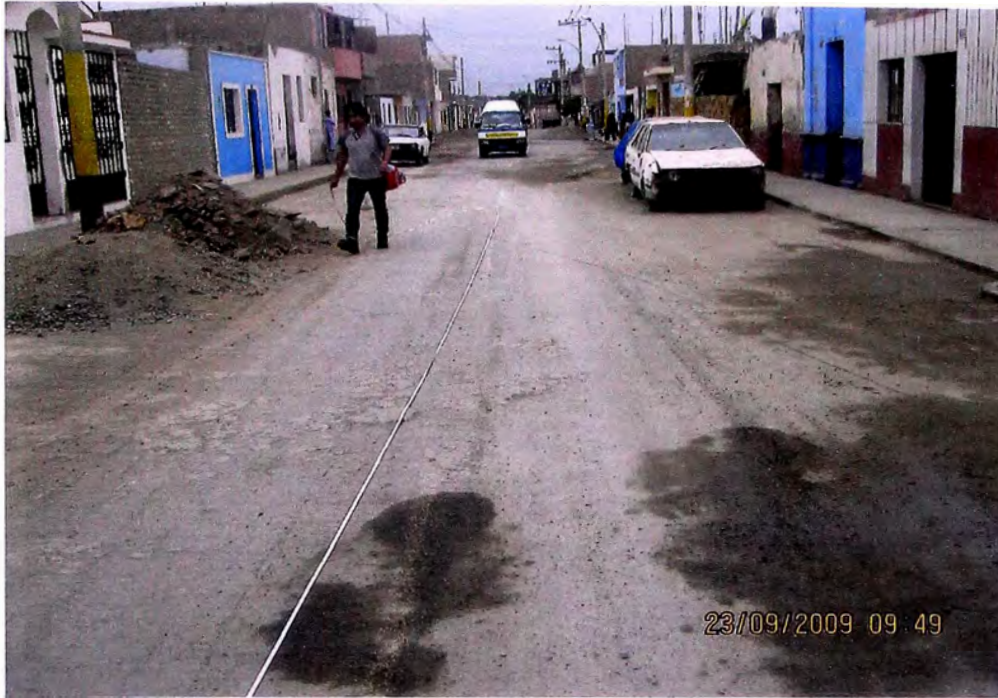
Foto Nro 3: En la vista observamos el wincheo realizado en la calle Santo Solano, verificando las distancias entre tapas de buzones Existentes.
