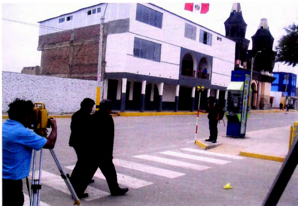
Foto Nro 8: Se observa en la foto el levantamiento topográfico que se realizó en la Plaza de Armas.
