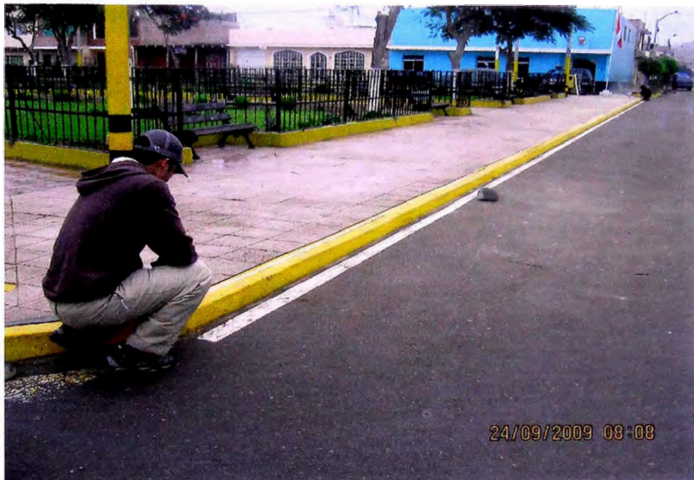
Foto Nro 2: En siguiente vista observamos las mediciones con wincha que se realizó alrededor de la plaza de Armas, para luego realizar la nivelación respectiva.
