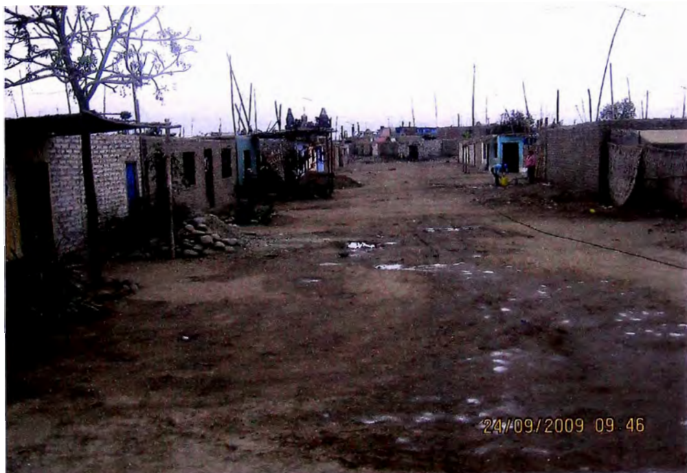
Foto Nro 12: La foto corresponde a la Calle las Palmeras, la cual es una zona que posee sistema de alcantarillado y también se puede observar que aun no esta pavimentada dicha Calle.
