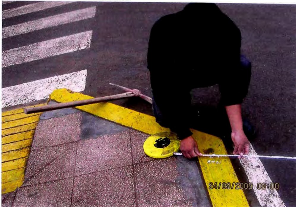
Foto Nro 1: En la foto se observa la demarcación del Bm auxiliar ubicada en la esquina del la plaza de Armas de la Localidad de San Luis.
