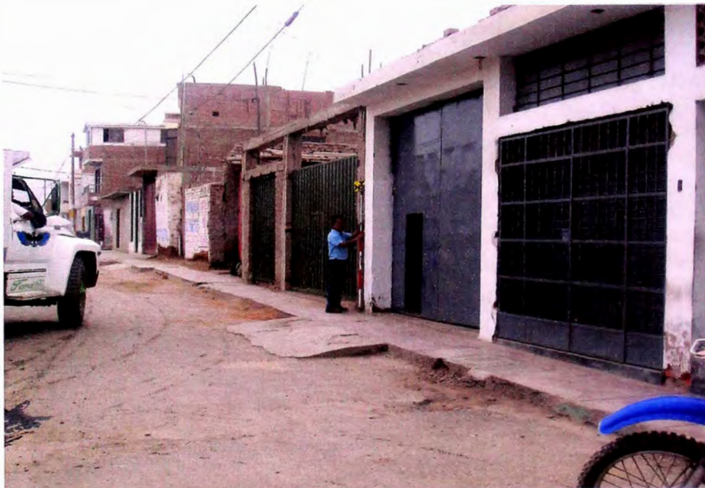
Foto Nro 6: En la foto observamos al personal con su jalón y prisma ubicándose al borde de un lote en la Calle Comercio.
