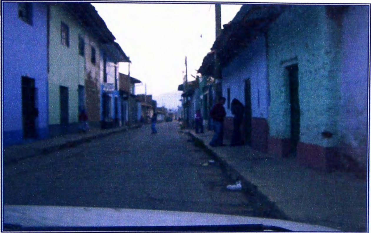
FOTO N° 05: VISTA DE LA CALLE BOLOGNESI. Se observa que la calle es angosta como la mayoría de las que conforma el distrito de Jauja, así mismo las casas que se observan a los lados de la calle muestran un deterioro en sus paredes producto de los años y las condiciones climáticas propios de la zona.
