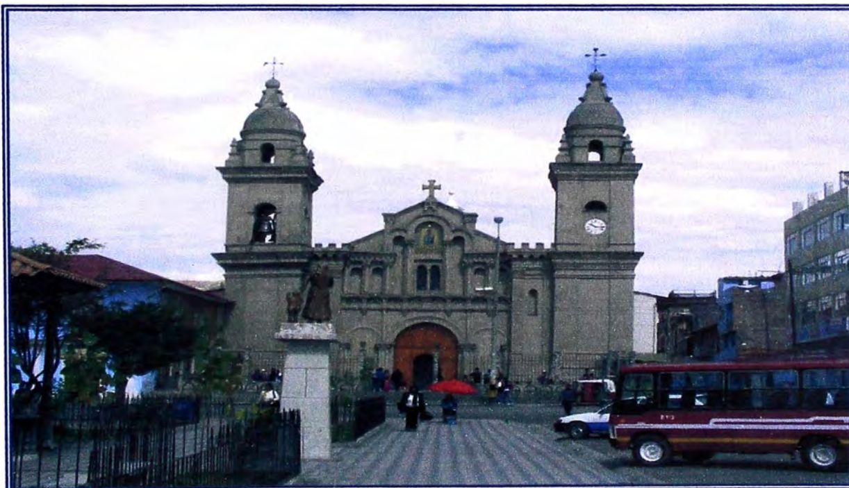
FOTO N° 02: VISTA DE LA IGLESIA MATRIZ DE LA CIUDAD DE JAUJA. La Catedral de Jauja es la primera catedral que Francisco Pizarro ordenó construir.
