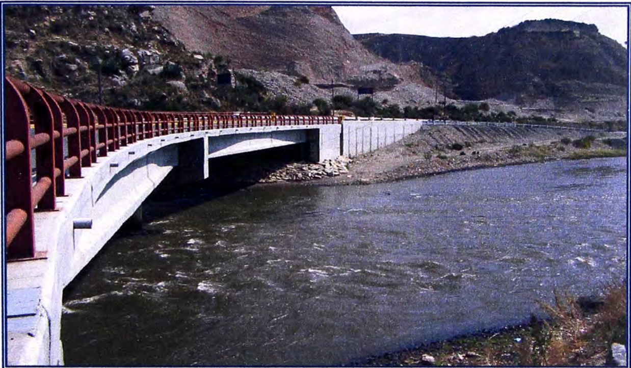
FOTO N° 13: VISTA DEL PUENTE STUART. El nuevo puente tiene dos tramos continuos de trazo curvo, con un ancho de ocho metros para la circulación en dos carriles: uno de ida y otro de regreso; el antiguo tenía un solo carril de cuatro metros.
