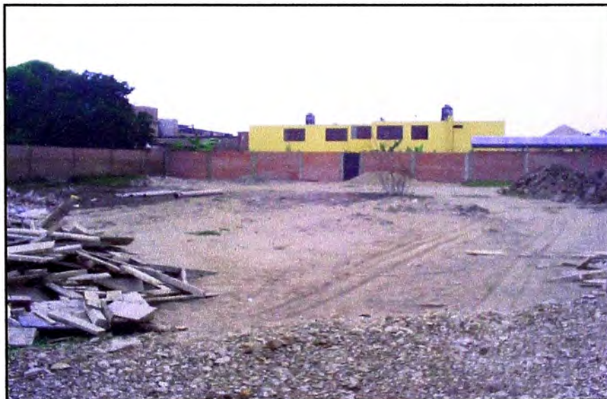
Foto N° 2.- Vista interior del terreno, donde se aprecia su uniformidad y el material de desmonte en poca cantidad.
