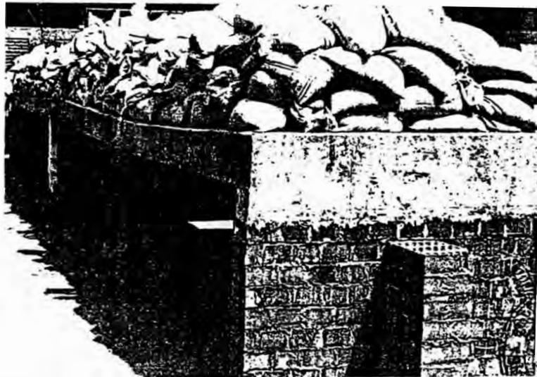
Foto 4. Losa sometida a "prueba de Carga"
