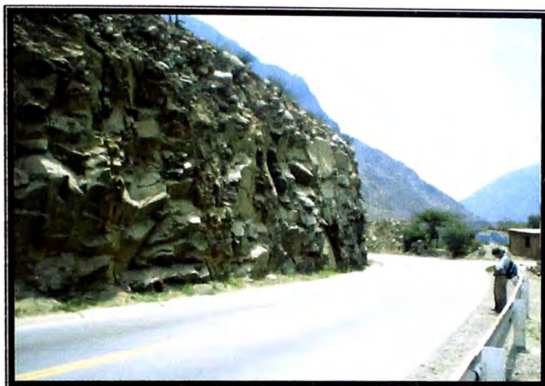
FOTO N° 01: Vista hacia atrás de la curva horizontal N° 50, Km. 63+100 inicio del tramo, se observa que no existen bermas laterales, el talud esta constituido por roca.
