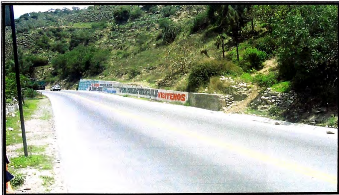
FOTO N° 12: Vista hacia adelante Km. 65+500. Se observa un muro de concreto utilizado para estabilizar el talud de corte.
