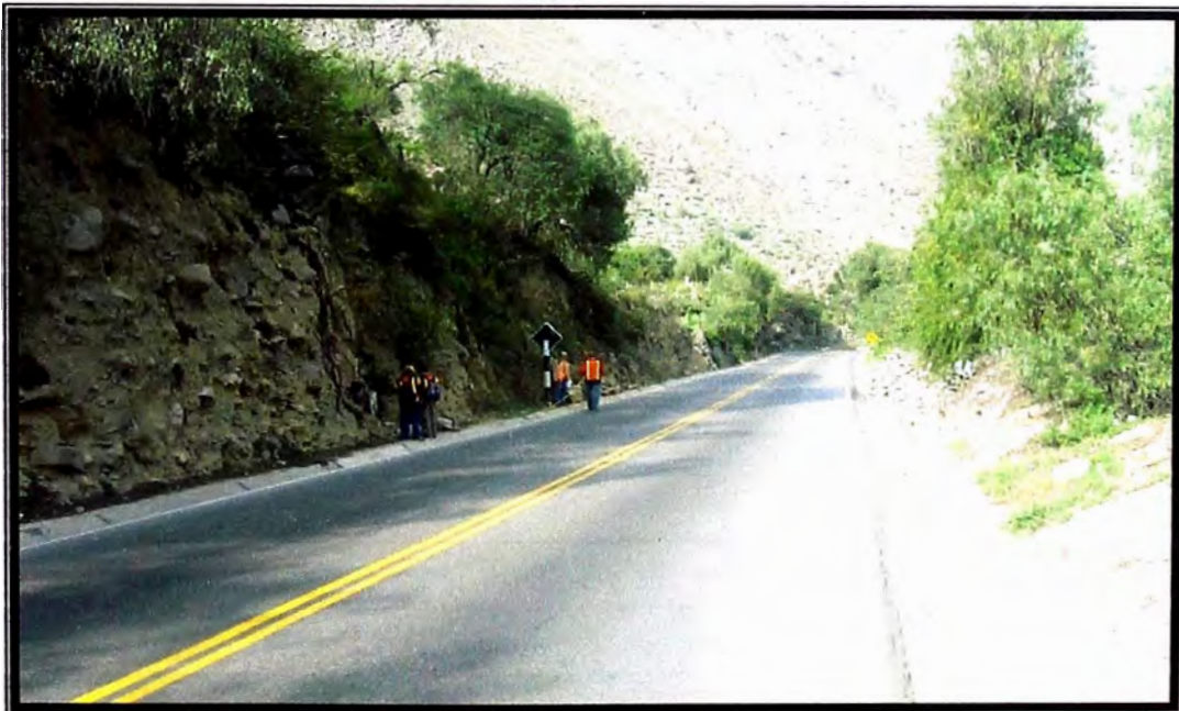
FOTO N° 10: Vista hacia atrás Km. 65+400. Se observa en este tramo en tangente cunetas a ambos lados de la vía, carece de bermas y los taludes son verticales.
