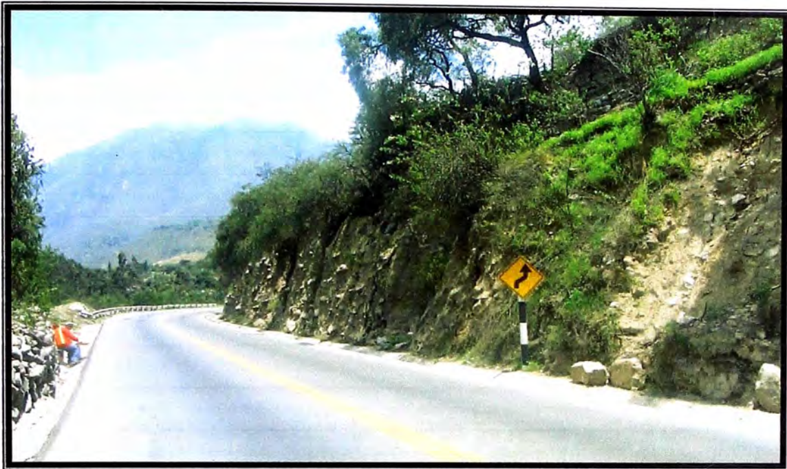
FOTO N° 11: Vista hacia delante Km. 65+380. Curva horizontal N° 65 cuyo talud de corte requiere una banqueta de visibilidad de 3m de ancho.
