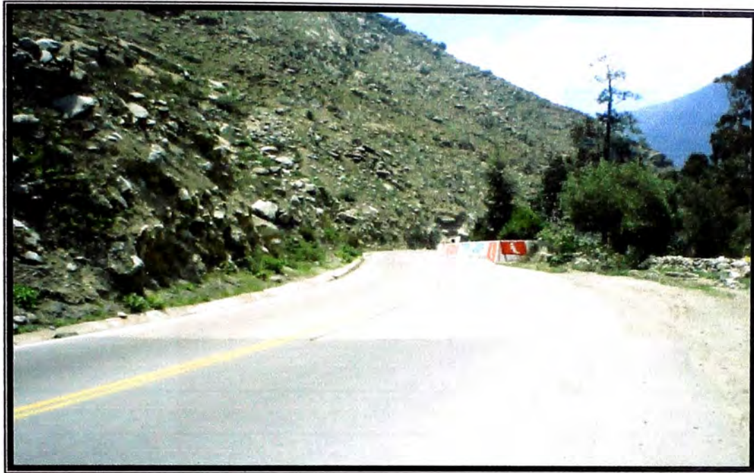
FOTO N° 03: Vista hacia atrás Km. 63+900. Se aprecia un tramo de la vía de concreto, también una plazoleta de cruce al lado izquierdo de la vía. El talud conformado por conglomerado.
