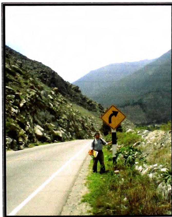
FOTO N° 02: Vista hacia atrás Km. 63+670, se puede apreciar que la vía tiene bermas laterales en este tramo.
