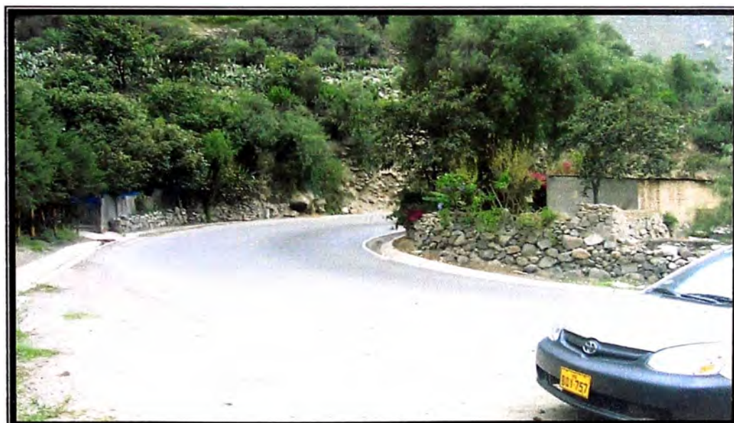
FOTO N° 08: Vista hacia adelante Km. 64+950, curva N° 59 y N° 60. Se observa que esta curva compuesta carece de banqueta de visibilidad por la existencia de una vivienda, ubicada dentro de la faja de dominio de la vía.
