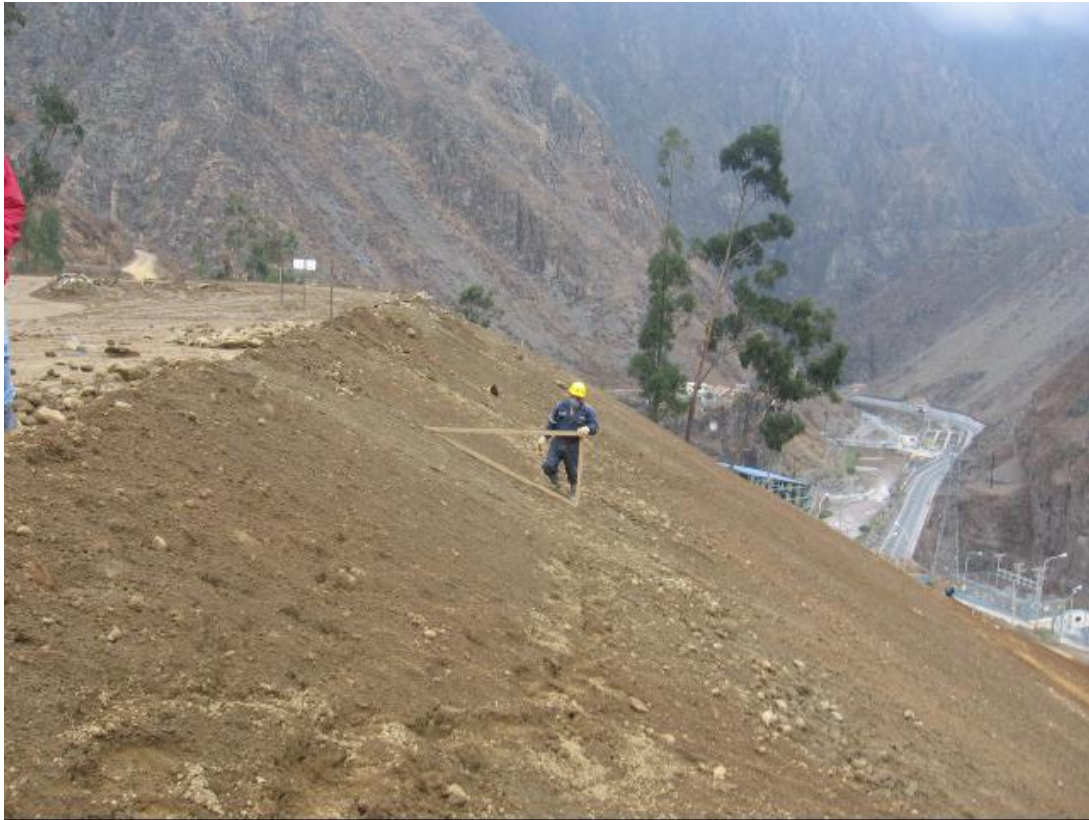
FOTOGRAFÍA N° 1.4.- Recrecimiento de la plataforma inferior de los depósitos N° 1 y 2 de Tamboraque, con una geometría de talud de 2H:1V-Sector Oeste 2005.
