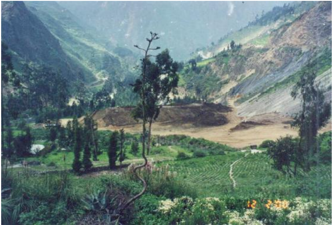
FOTOGRAFÍA N° 1.1.- Vista de Mayoc de Norte a Sur, se aprecia el dique del depósito de relaves proyectado. Curva de la carretera central.
