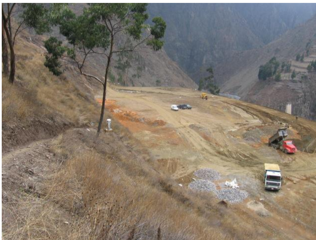
FOTOGRAFÍA N° 1.3.- Descarga directa de relave en la plataforma superior de los depósitos N° 1 y 2 de Tamboraque, 2005.
