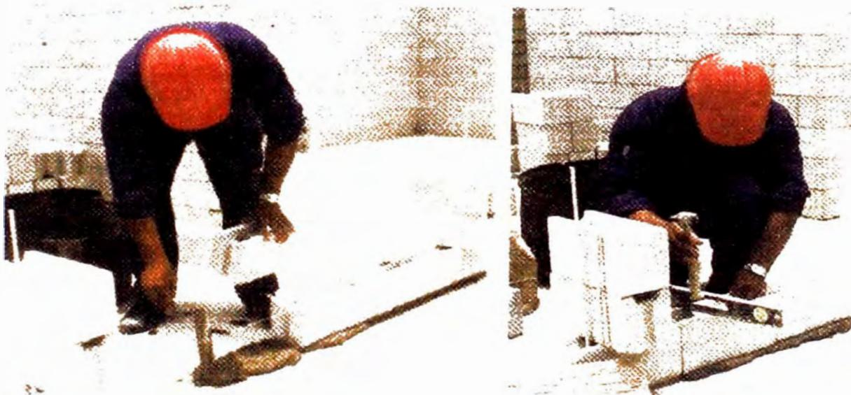
**2. Asentar sobre mortero las unidades de los extremos de cada muro, nivelar y alinear con cordel, completar la primera hilada certificando que ambos lados de sus canales (alas) estén nivelados entre si. Verificar que todas las hiladas de los muros estén en un solo plano horizontal con una regla de 1" x 4" de 6mt.**
