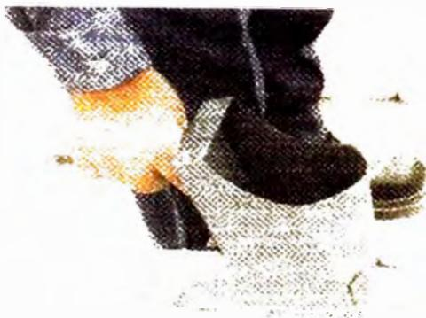
**4. Si la exigencia estructural lo requiere (3 a 5 pisos) se logra la íntima continuidad, al aplicar (sólo en la superficie de las alas de las unidades) una mínima capa de "mortero de acoplamiento" con una herramienta especial que lo extiende con facilidad y rapidez.**
