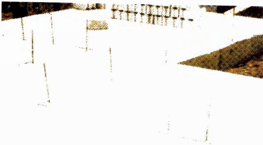
**1. Construir la cimentación (cimientos corridos o losa de concreto) dejando los anclajes de la armadura y tuberías de instalaciones eléctricas y sanitarias, con sus cajas de pase. Trazar todos los muros.**
