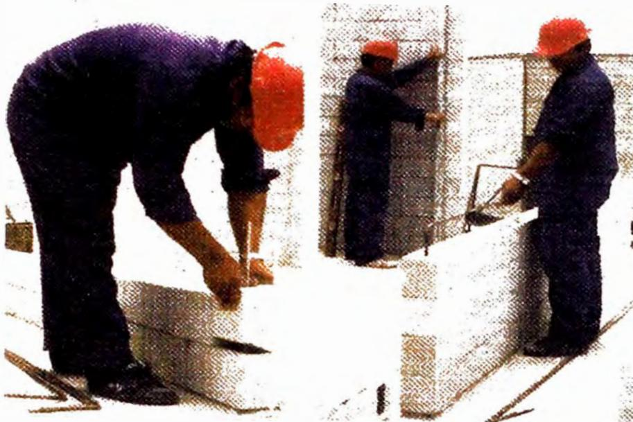
**3. Iniciar el apilado de las unidades de un extremo de muro hacia el otro. Con una regla de  $\frac{1}{2}$ "x 2" de 1.5 m, se certifica su correcto apilado. Colocar los fierros horizontales en las hiladas indicadas en el diseño estructural.**
