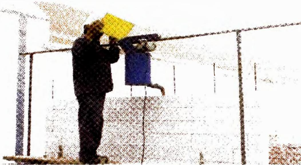
**9. Vaciar el concreto líquido que llenará los alvéolos y canales del muro, por el alveolo de un extremo de él, hasta que se llene y así en orden uno por uno. El concreto debe ser agitado enérgicamente justo antes de vaciarlo, con el badilejo o con un equipo mecánico simple.**
