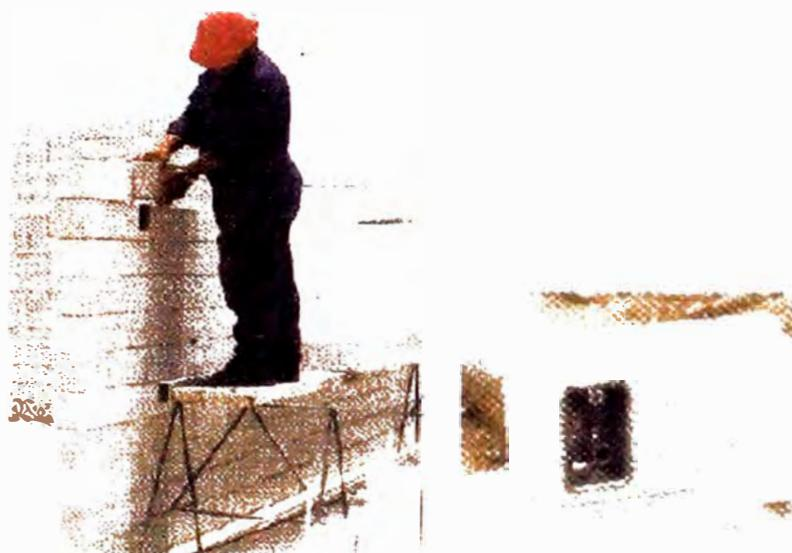
**6. Colocar las unidades con las cajas de instalaciones durante el proceso de apilado.**
