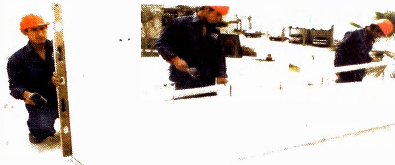
**5. La verticalidad y el alineamiento horizontal del muro se mantiene mediante una regla de  $\frac{3}{4}$ "x3" de 3m y un nivel de precisión. Con una comba de caucho se precisa la correcta ubicación de cualquier unidad en el plano del muro.**
