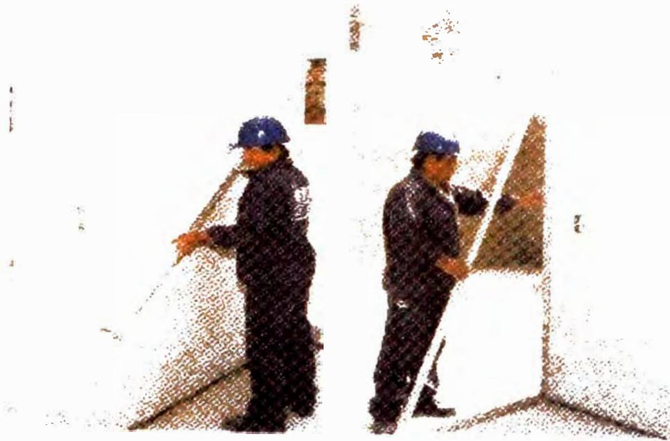
**7. Terminado el apilado del muro, verificar con una regla y una escuadra el plano del muro y su verticalidad. Corregir el alineamiento de cualquier unidad con la comba.**
