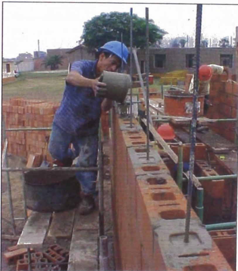
Foto N° 10: VACIADO DE ALVEOLOS CON CONCRETO LÍQUIDO
