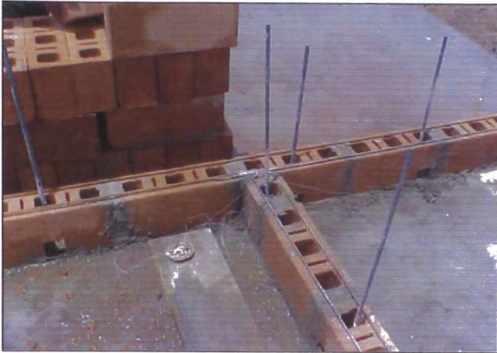
Foto N° 5: DISPOSICIÓN DE ACERO DE REFUERZO
