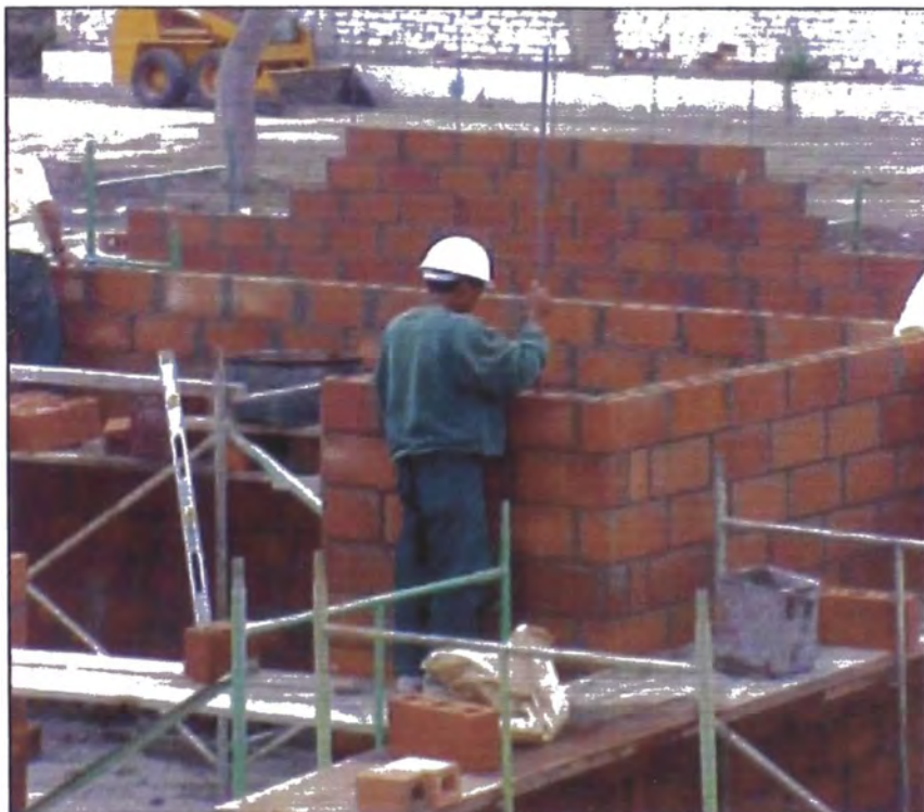
Foto N° 8: EMPALME DE DOWELS – COLOCACIÓN DE REFUERZO VERTICAL
