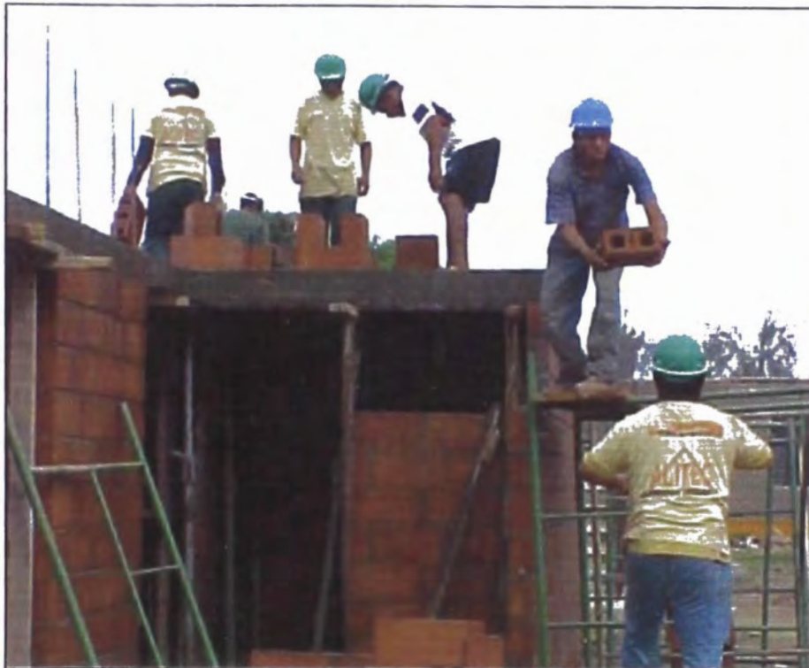
Foto N° 1: MANIPULEO DEL LADRILLO ITALBLOCK
