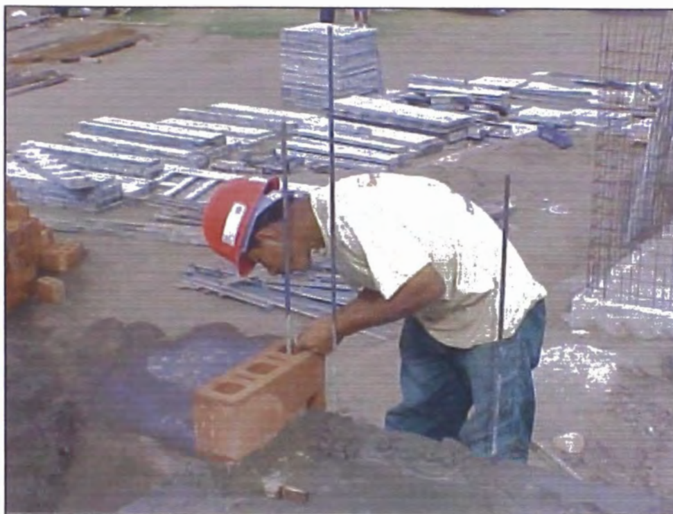
Foto N° 3: ASENTADO DE LADRILLOS
