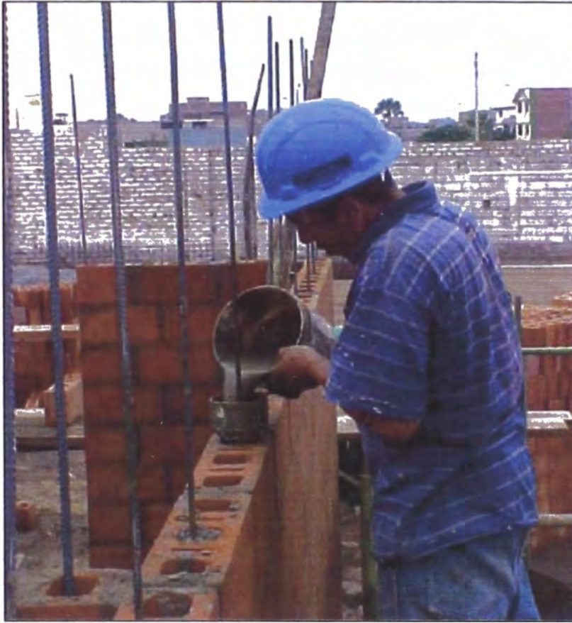
Foto N° 11: VACIADO DE ALVEOLOS CON CONCRETO LÍQUIDO
