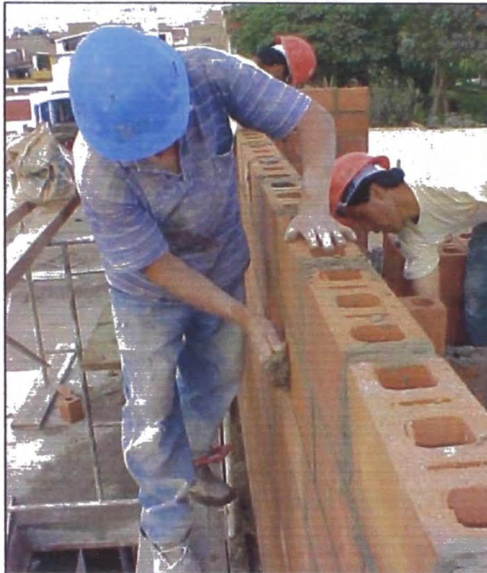
Foto N° 7: LIMPIEZA DE MUROS
