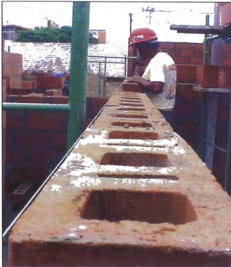
Foto N° 6: ALINEAMIENTO DE MUROS
