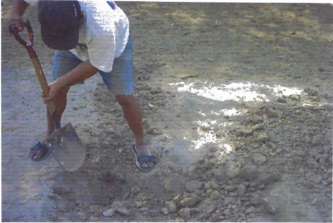
Foto N° 1: EXCAVACIÓN DE CALICATA C-07
