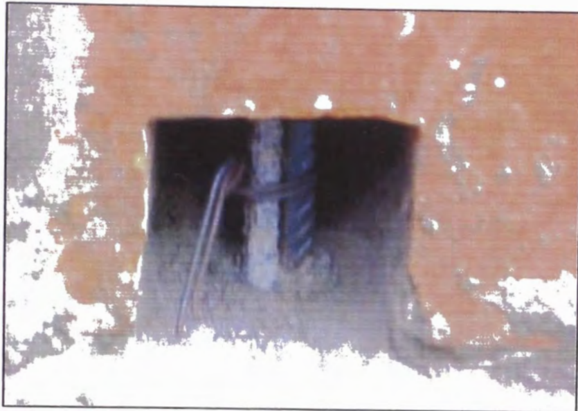
Foto N° 9: AMARRE DE DOWELS A TRAVÉS DE ORIFICIOS DE REGISTRO
