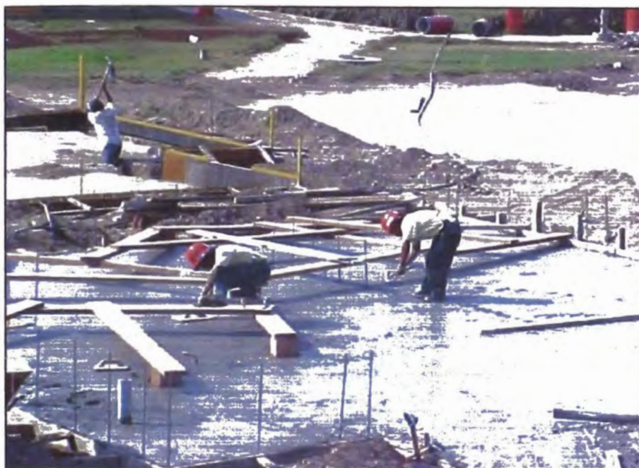
Foto N° 2: CIMENTACIÓN QUE INCLUYE DOWELS PARA EL USO DEL ITALBLOCK
