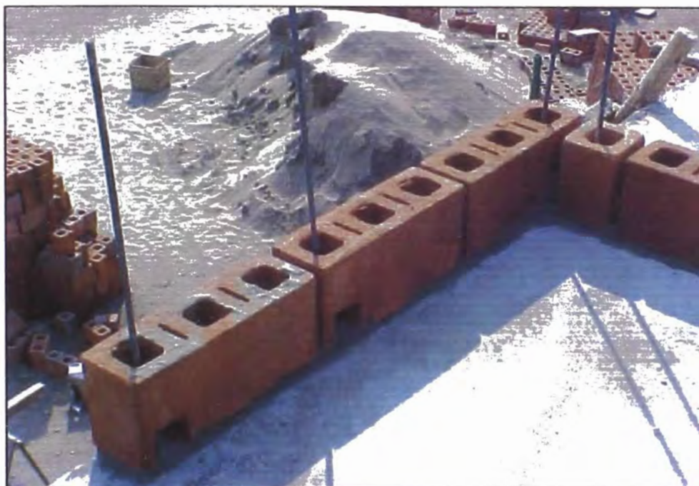
Foto N° 4: ASENTADO DE LADRILLOS
