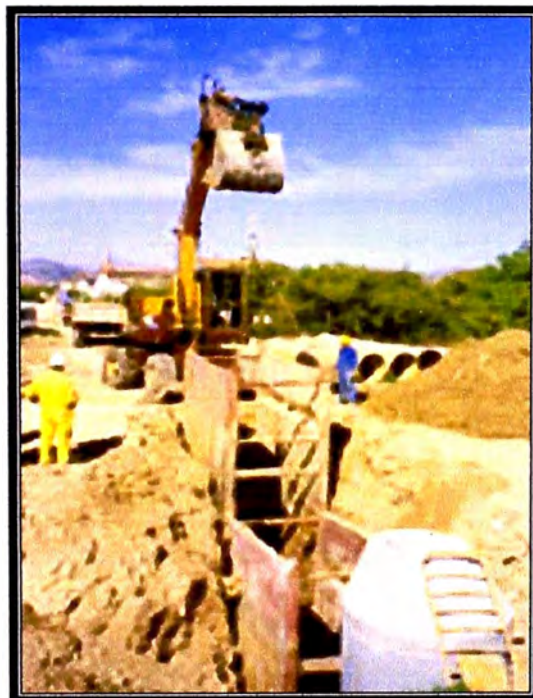
Foto 41 (abajo): Excavadora colocando los paneles en la zanja.
