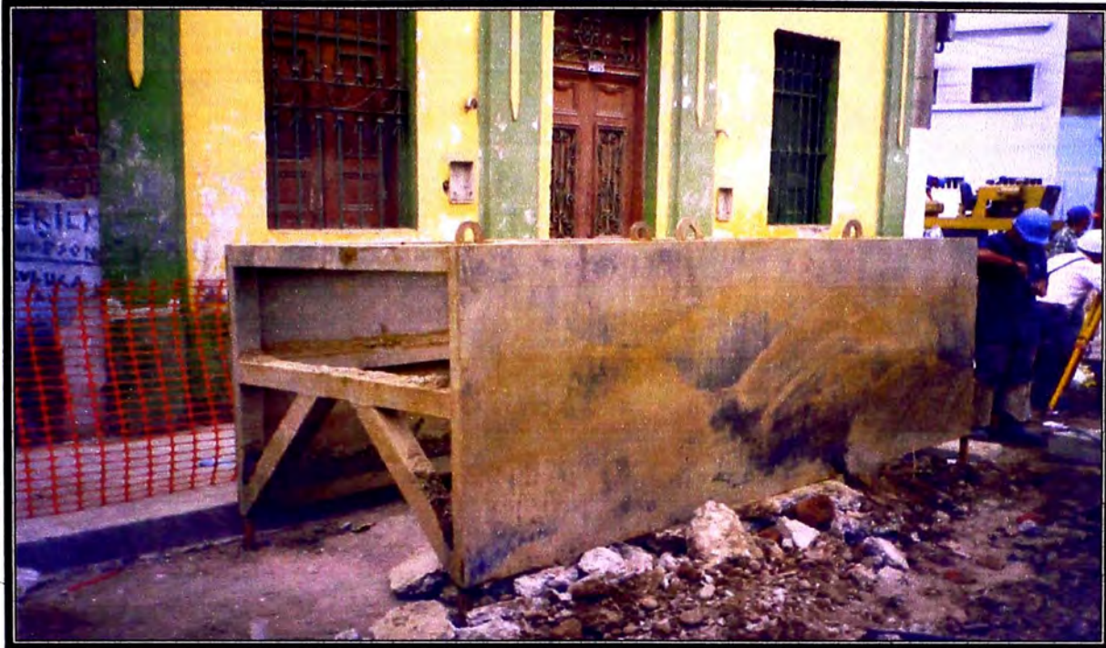
Foto 35 (arriba): Cajón metálico antes de ser bajado a la zanja.
