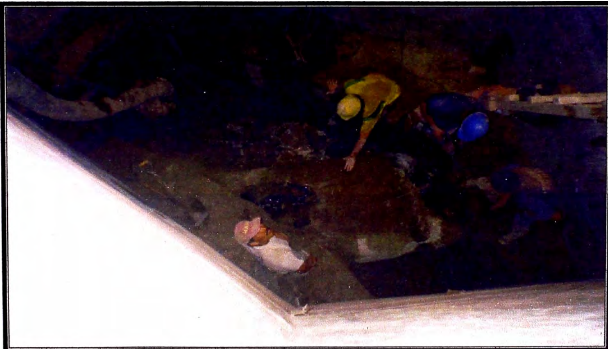
Foto 20 (abajo): Trabajos de rotura de tubería existente de \Phi 42'' en empalme final, dentro de la cámara C.R.2., para su puesta en funcionamiento.
