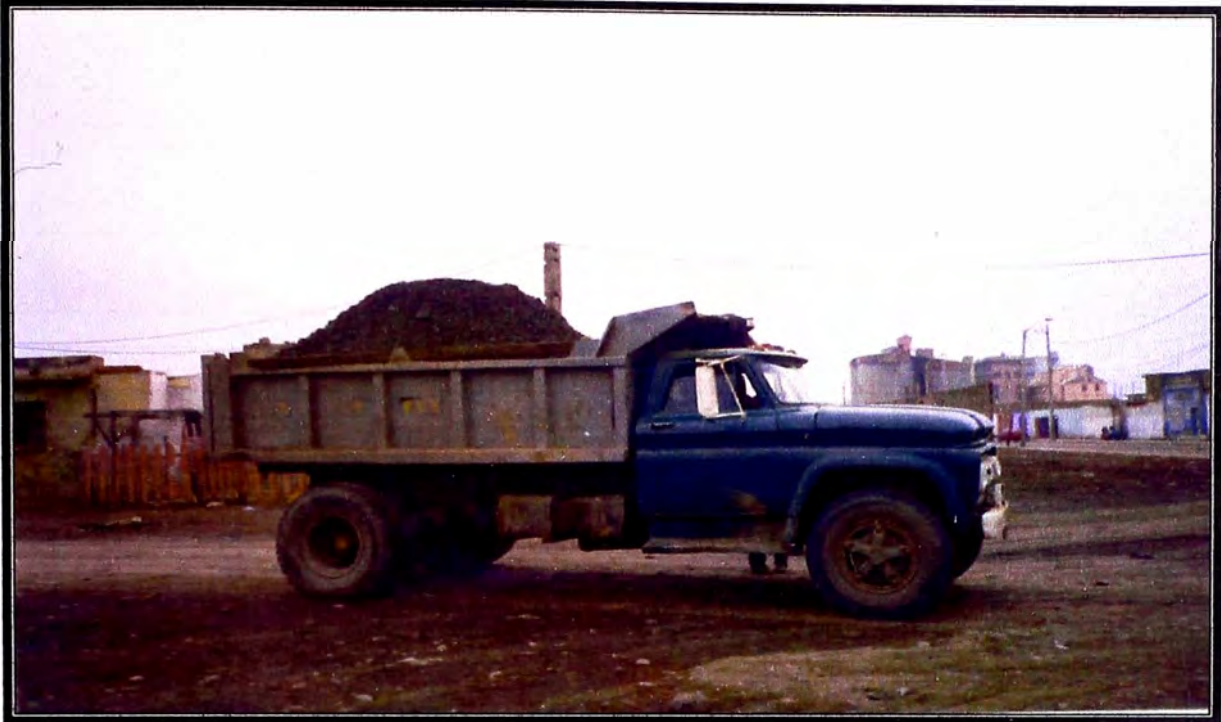
Foto 05 (arriba): Partiendo a eliminar el material orgánico, se aprecia el color negruzco, característico de estos suelos.
