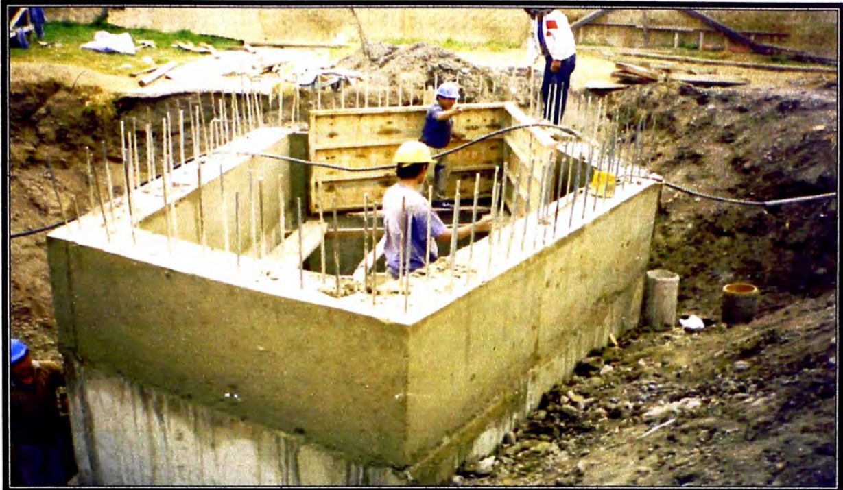
Foto 21 (arriba): Terminando de construir los muros de la cámara de reunión final C.R.2.
