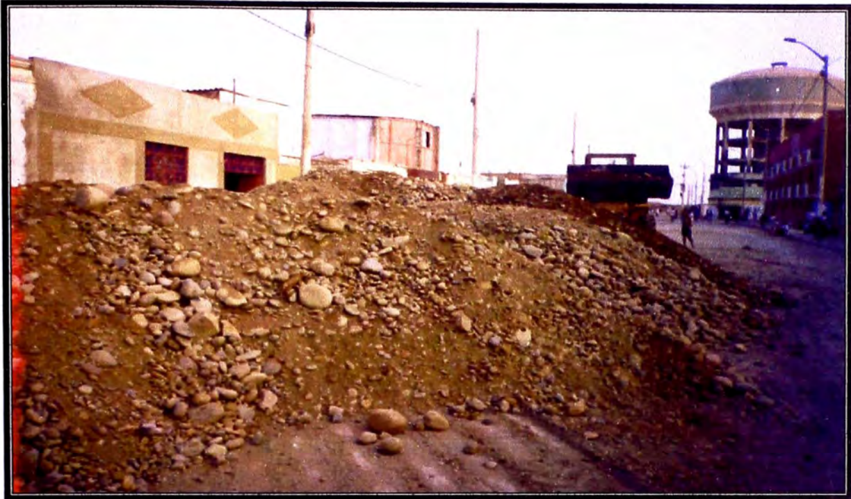
Foto 03 (arriba): Material de Préstamo transportado para el relleno de zanjas, ante presencia de suelos orgánicos.
