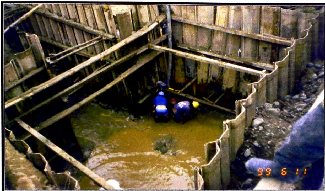
Foto 11 (arriba): Tablestacado continuo alrededor de la ubicación de la cámara de Reunión de Buenos Aires (C.R.1), nótese la tubería de 40” .
