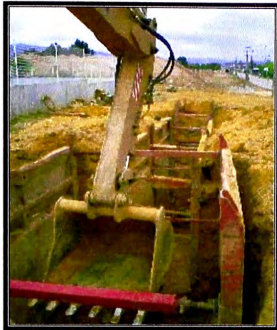
Foto 39 (arriba – izq): Panel GiP totalmente armado.
