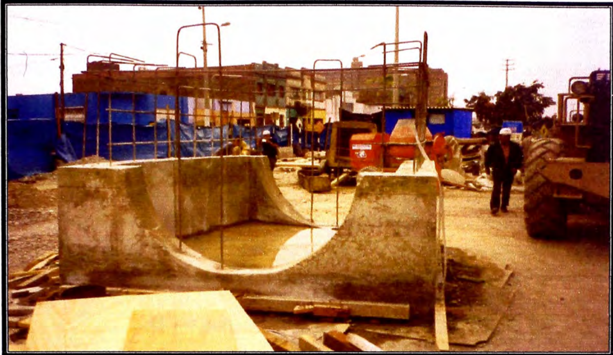
Foto 17 (arriba): Base de buzón prefabricado, junto a su futura ubicación.
