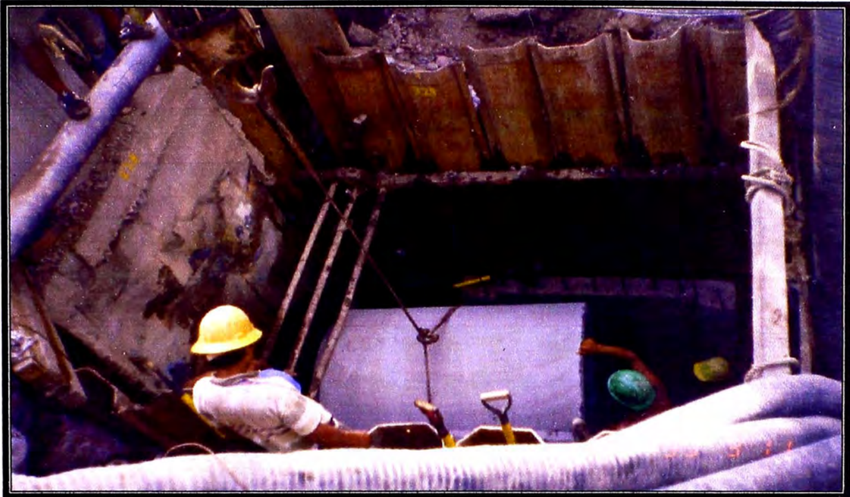
Foto 27 (arriba): Maniobra de bajada de un tubo. En este caso se estaba conectando el Buzón 19 con una caja ciega para bombeo que se explica más adelante.
