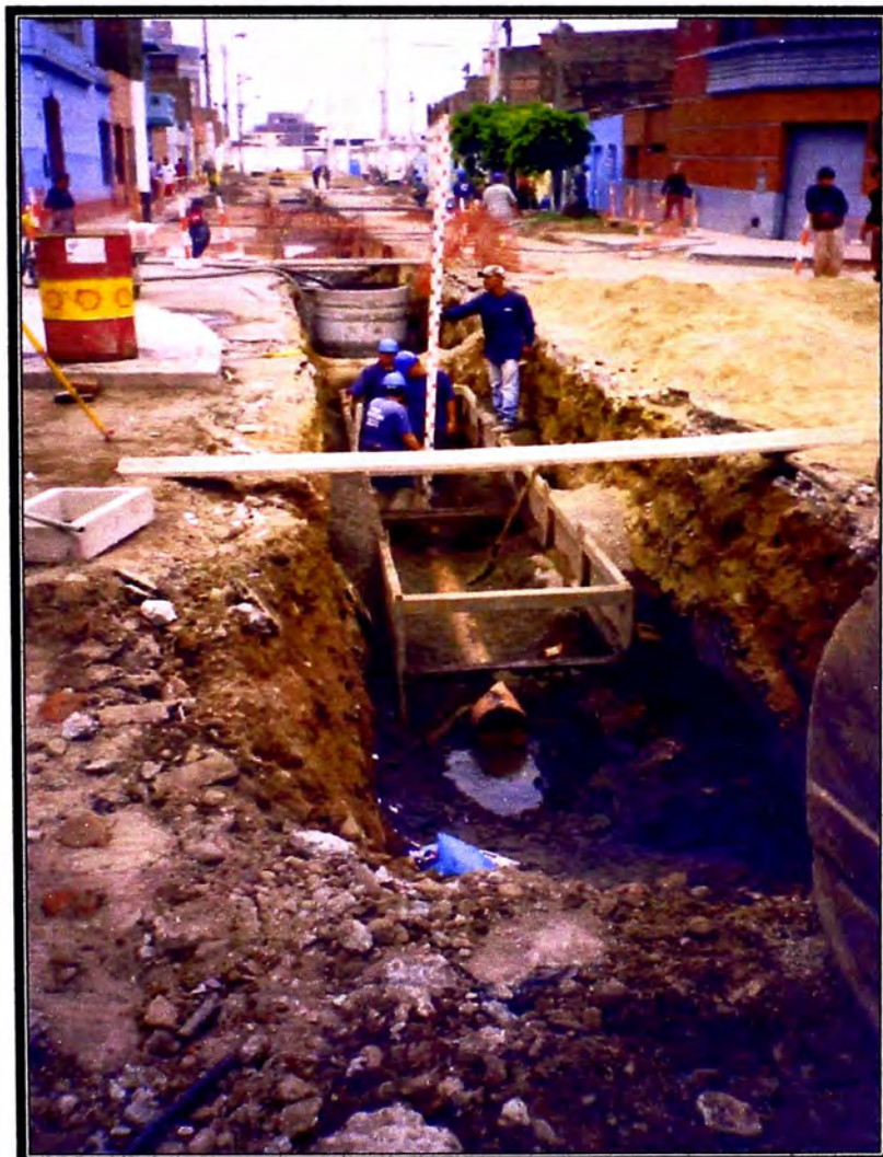
Foto 35 (arriba): Cajón metálico antes de ser bajado a la zanja.
