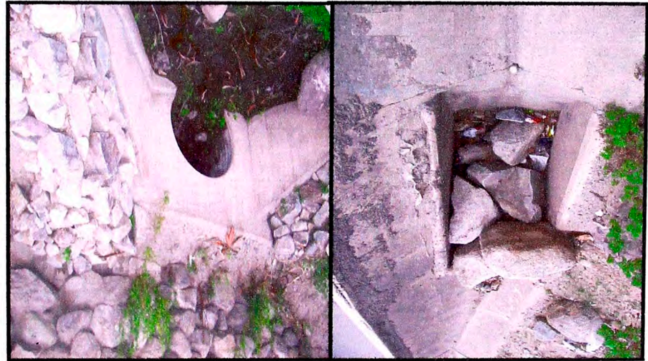
Foto B.2: Alcantarilla 61+180
