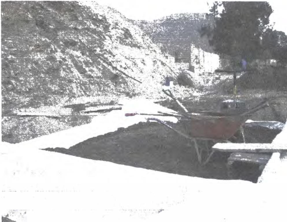
**Fotografía 5:** Primera capa de muro con geotextil
