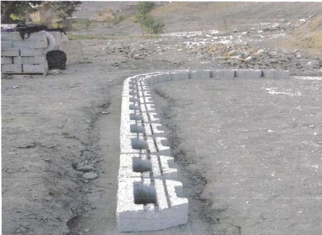
**Fotografía 3:** Primera hilada de bloques de concreto
