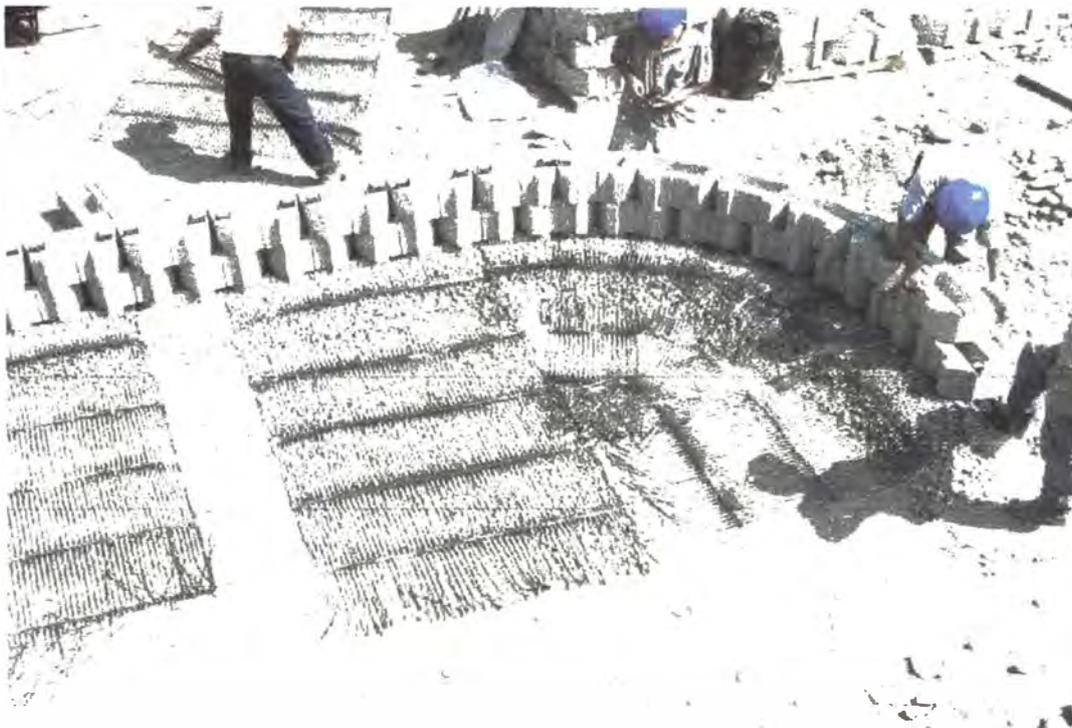
**Fotografía 4:** Colocación de bloques de concreto y geomallas
