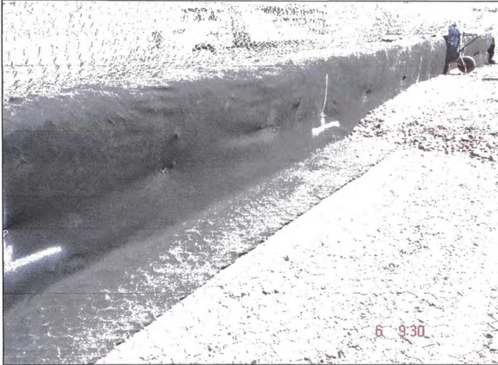
**Fotografía 7: Geotextil en muro con terramesh**
