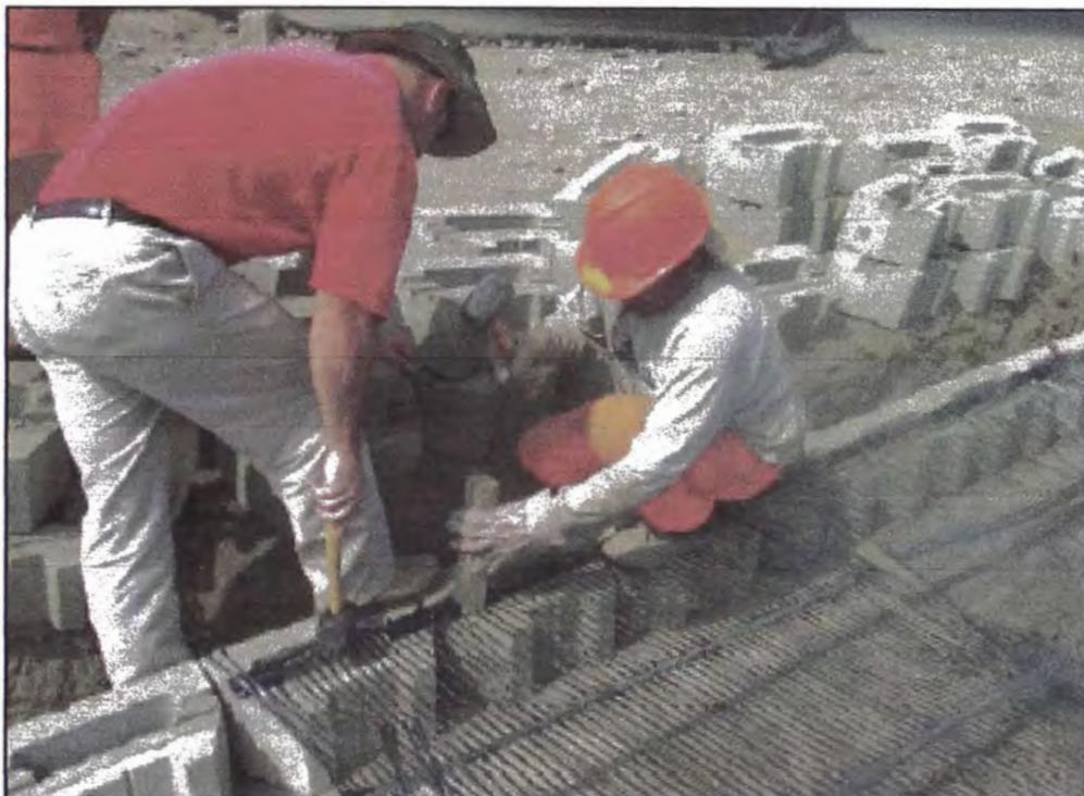
Fotografía 3: Colocación de la geomalla en los bloques MESA
