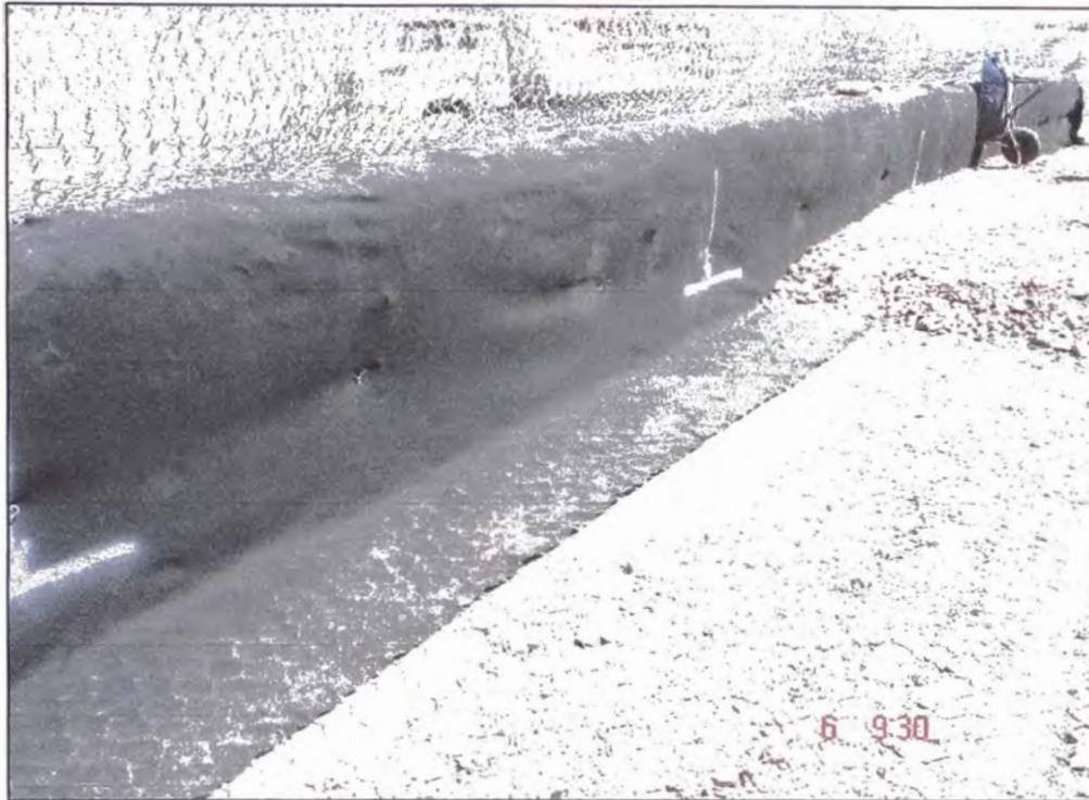
Fotografía 10: Colocación del geotextil, Sistema Terramesh
