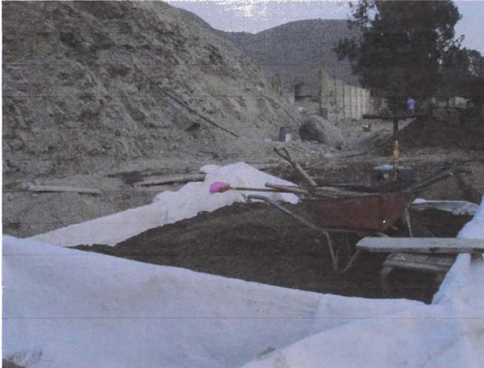
Fotografía 7: Llenado de geotextiles con material de relleno
