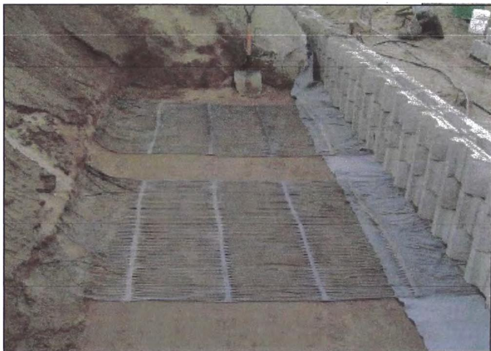
Fotografía 5: Sistema constructivo del muro con Geomallas
