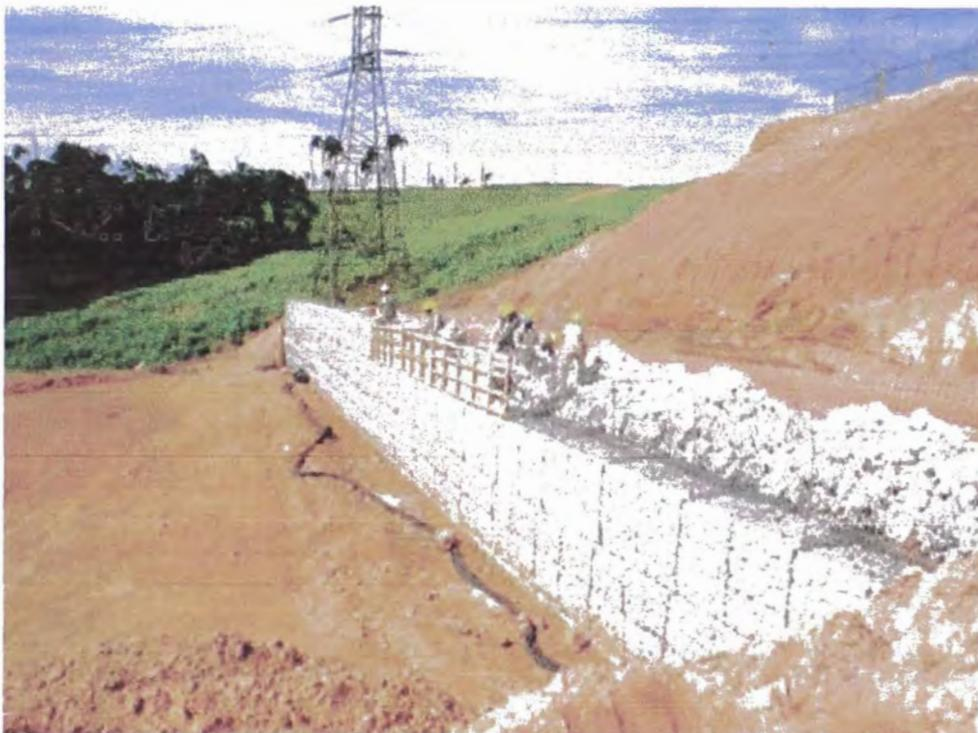
Fotografía 9: Encofrado de muro en Sistema Terramesh
