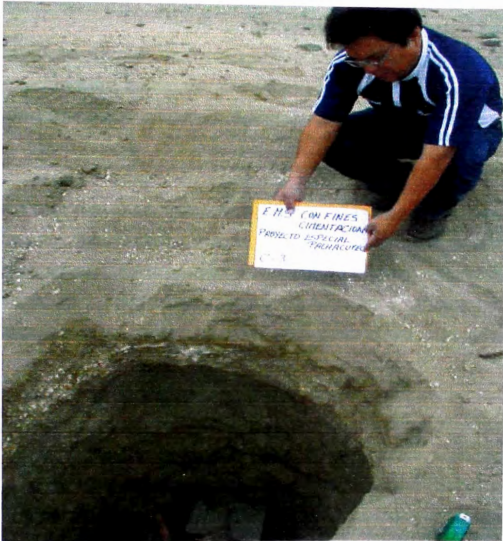
FOTO 3 perfil estratigráfico de la calicata C-3, a -1.00 m se tiene un suelo de características arena limosa en estado seco, no plástico, de baja compacidad.
