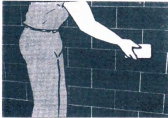
Figura 33. Limpieza mediante un trozo de bloque
