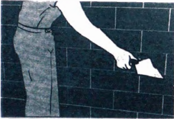
Figura 31. Limpieza de derrames de mortero
