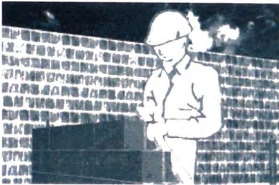
Figura 15. Verificación de planitud
