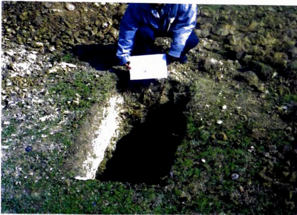
Foto 5 Vista de Calicata C-3
