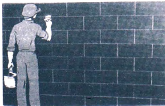
Figura 48. Curado de las juntas de mampostería con brocha
