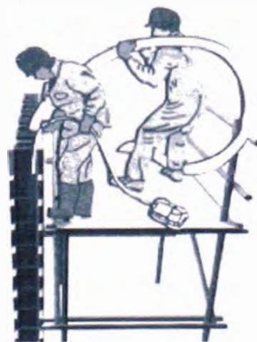
Figura 45. Inyección de las celdas con bomba
