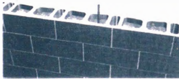
Figura 46. Nivel final de la inyección en el enrase
