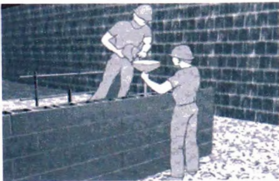
Figura 44. Inyección de celdas con embudo
