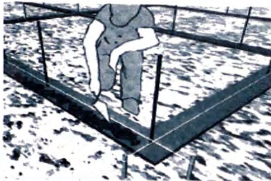
Figura 7. Colocación del mortero sobre el cimient
