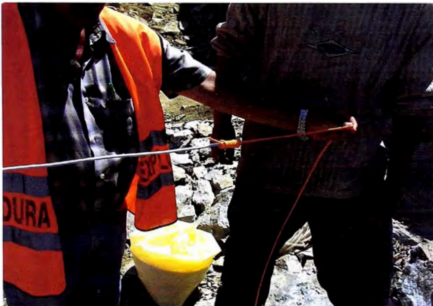
Foto N° 16.- Iniciador de la malla con mecha lenta, se muestra la manera de unirlos
