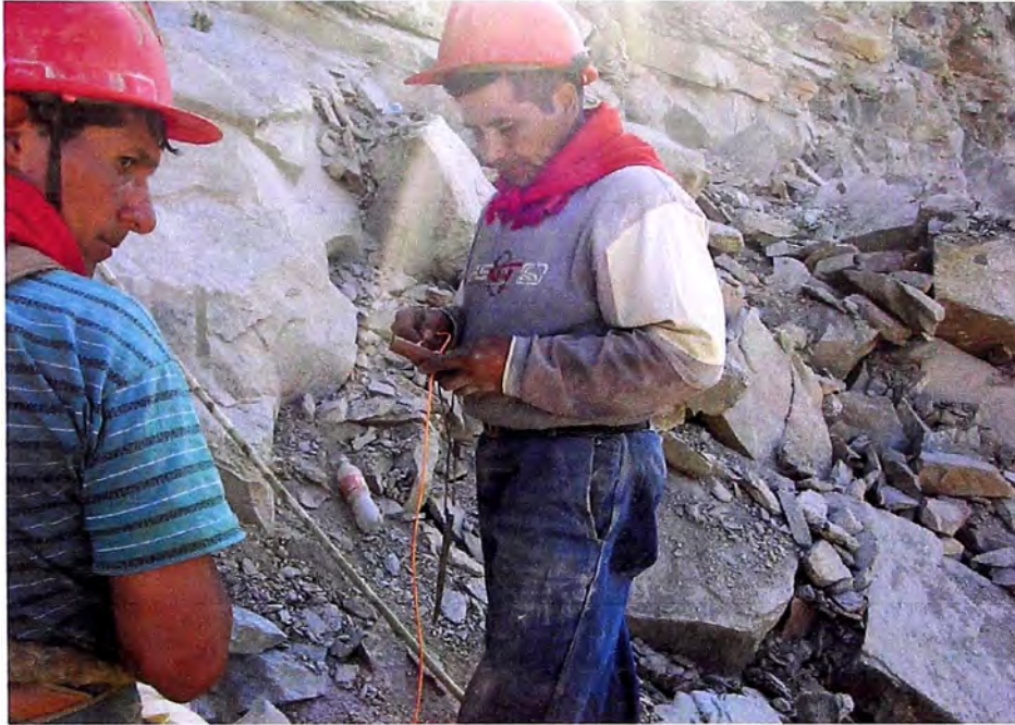
Foto N° 13.- Conexión del cordón Detonante con la dinamita para activar la carga de fondo del barreno.
