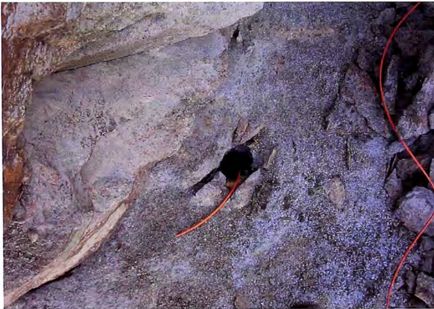
Foto N° 14.- Vista en Planta de un barreno.
