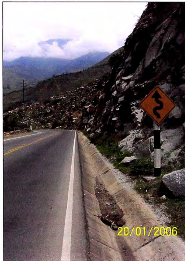
Foto N° 1.- Inicio del Nuevo tramo 3: km 63+452.23 al 64+015.21, se puede evidenciar la mejora Geométrica que se quiere realizar.
