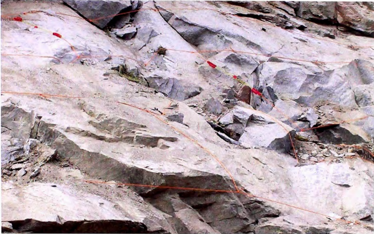
Foto N° 15.- Malla iniciación de la Voladura, con retardos.
