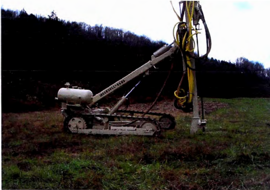
Foto N° 7.- Track Drill ECM 350b
