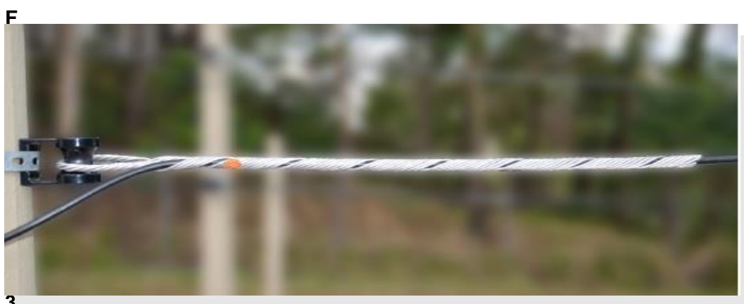
Fig. 2.16 Forma de instalar una retención
