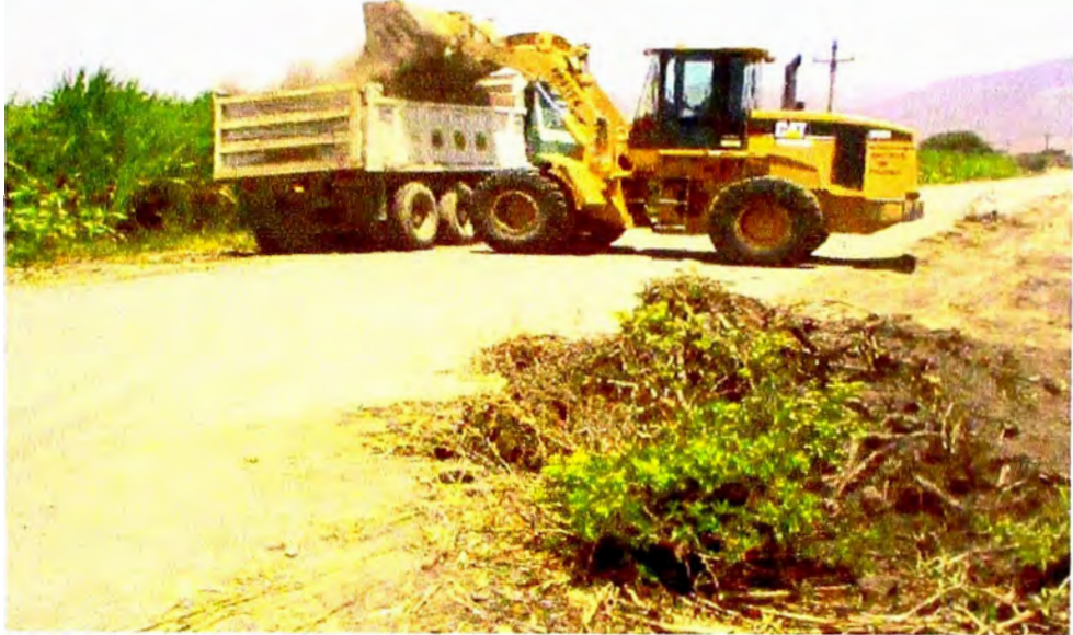
FOTO N° 03 TRABAJOS DE ROCE Y LIMPIEZA
