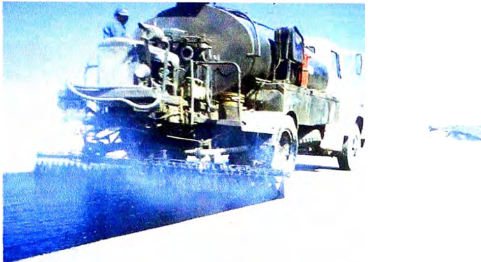
FOTO N° 12 IMPRIMACION ASFALTICA
