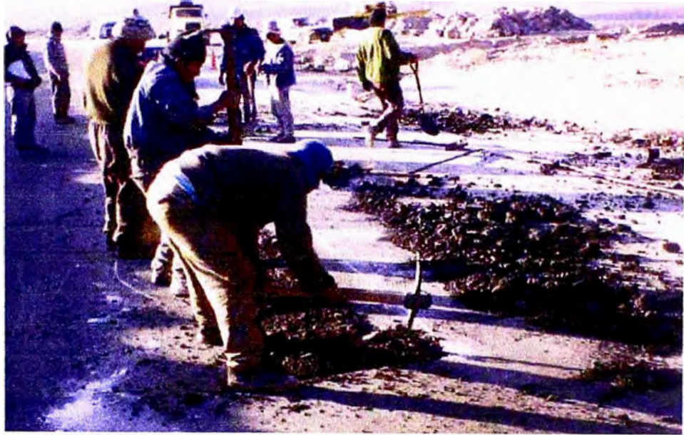
FOTO N° 08 REMOCION DE CARPETA ASFALTICA EXISTENTE
