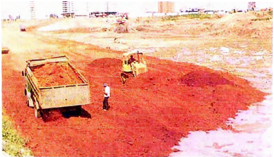
FOTO N° 09 RELLENO COMPACTADO CON MATERIAL DE PRESTAMO
