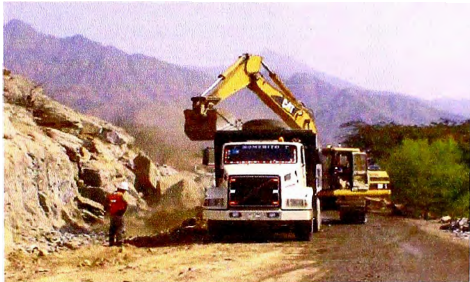
FOTO N° 06 REMOCION DE DERRUMBES
