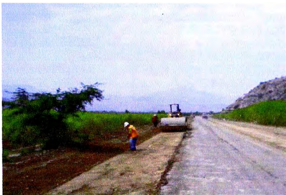
FOTO N° 10 COMPACTACION DE TERRENO EN ZONAS DE CORTE
