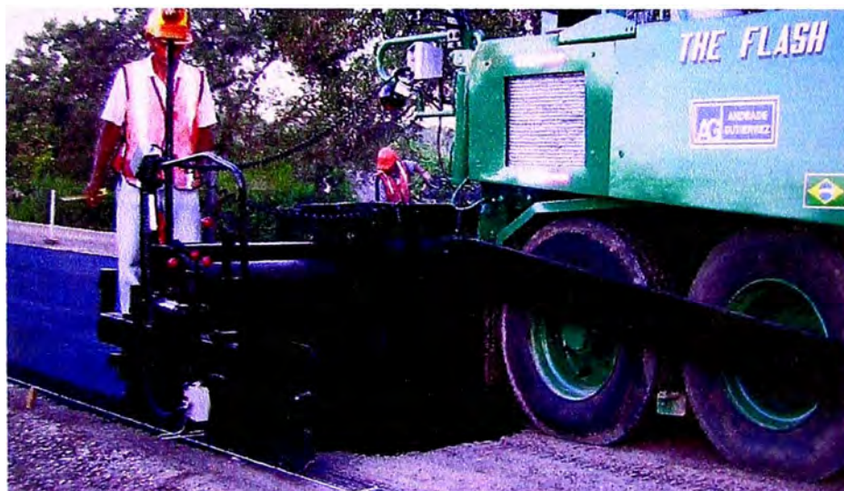
FOTO N° 13 PAVIMENTADORA DE CONCRETO ASFALTICO
