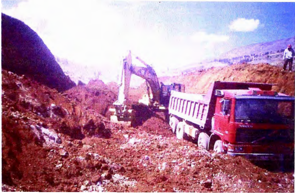
FOTO N° 05 EXCAVACION NO CLASIFICADA PARA EXPLANACIONES
