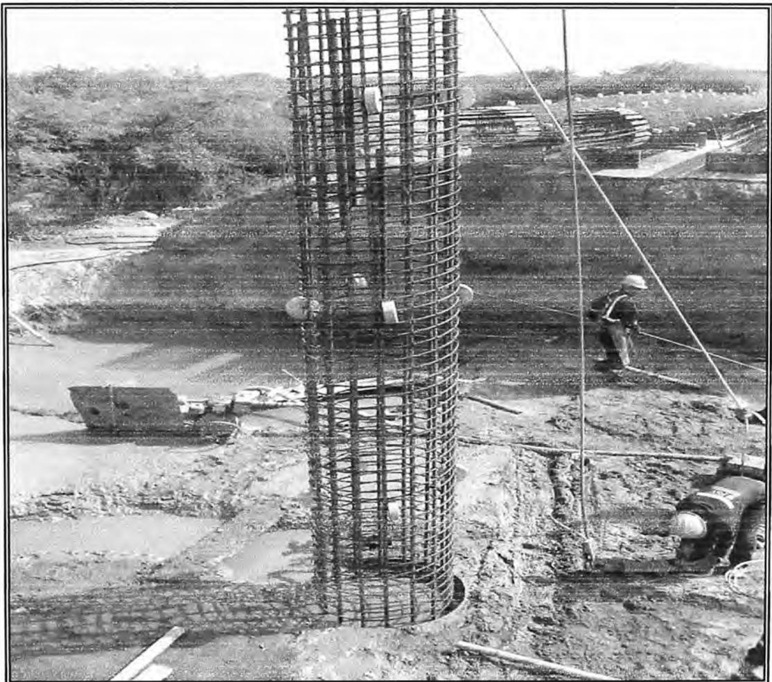
Figura 9. Colocado de la armadura del pilote.
