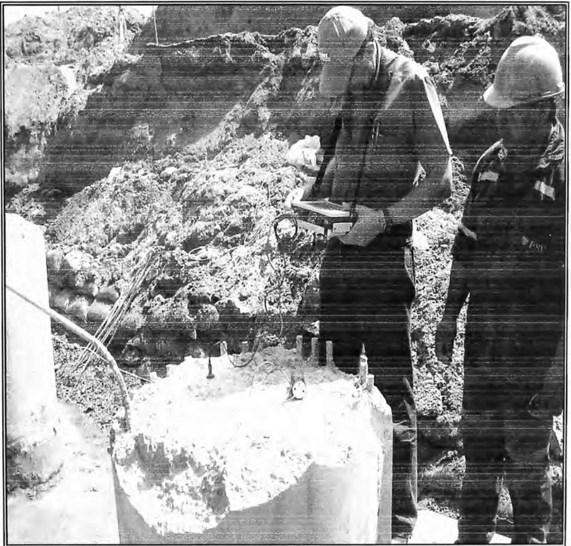
Figura 3. Prueba de integridad de los pilotes.
