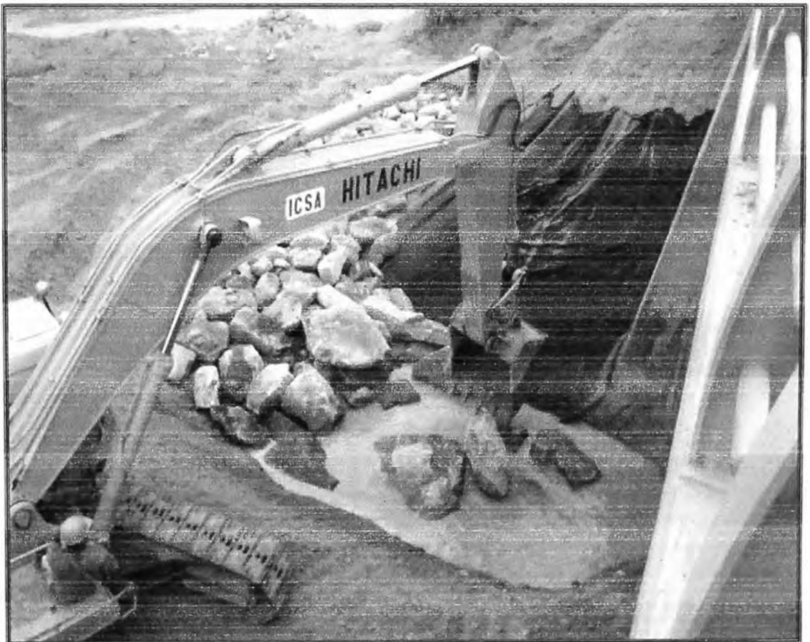
Figura 14. Colocado del geotextil.
