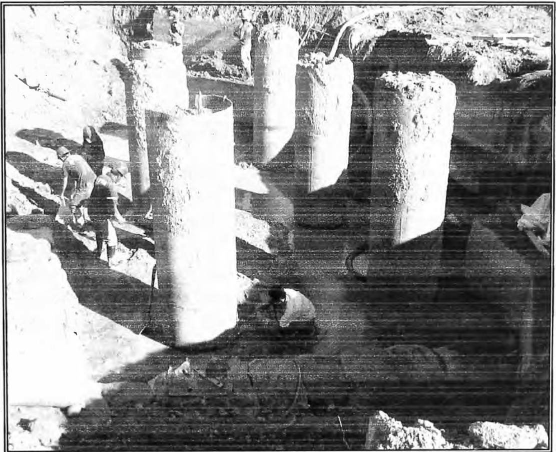
Figura 15. Cimentación del pilar central del puente Independencia.
