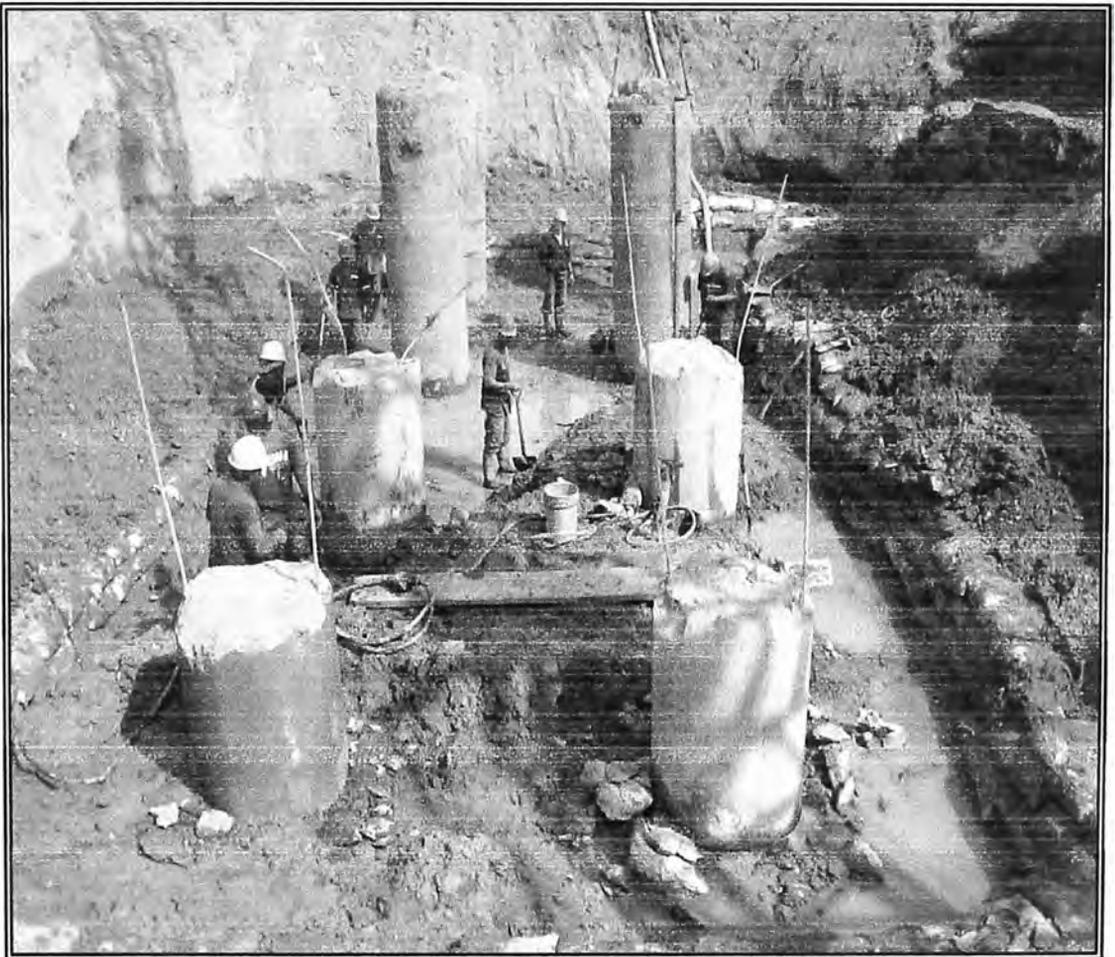
Figura 12. Descabezado de pilotes.
