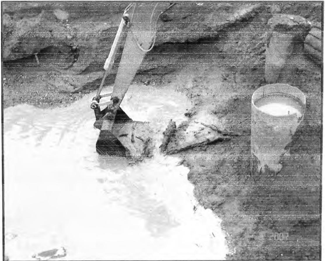
Figura 20. Lodos de arcillas tixotrópicas( bentonita).
