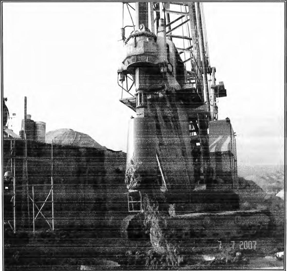
Figura 22: Método para romper las capas duras.
