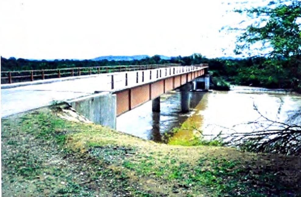
También se ha considerado otros trabajos como la demolición y acondicionamiento del Estribo derecho existente para transformarlo en Pilar, y el reforzamiento de la cimentación existente para proporcionarle estabilidad y prevenir cualquier asentamiento debido a fenómenos erosivos por incremento de caudales y/o avenidas máximas.
