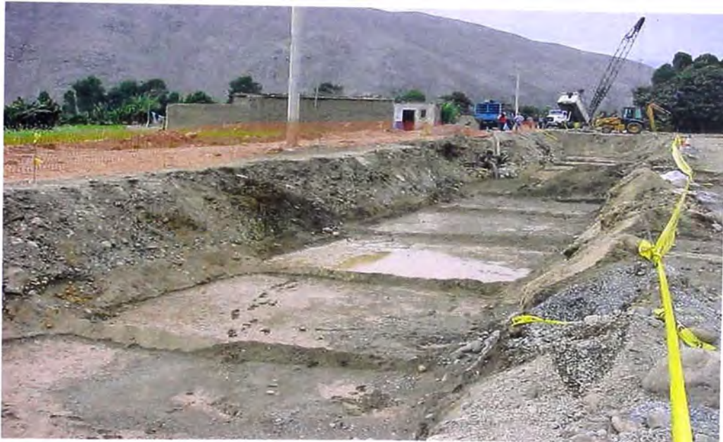
FOTO 89.- Seguridad , donde se ha colocado señales de cintas de seguridad, asimismo se observa el relleno de la zanja con material seleccionado y el riego de agua para su compactación respectiva.
