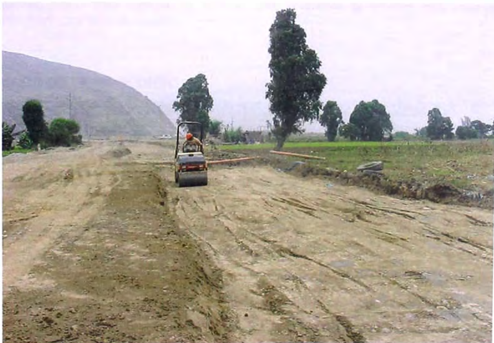
FOTO 93.- Tubería de conducción; de la línea desde la obra de captación a la Planta de Tratamiento, se observa la etapa final de los trabajos con la compactación con un rodillo liso autopropulsado.
