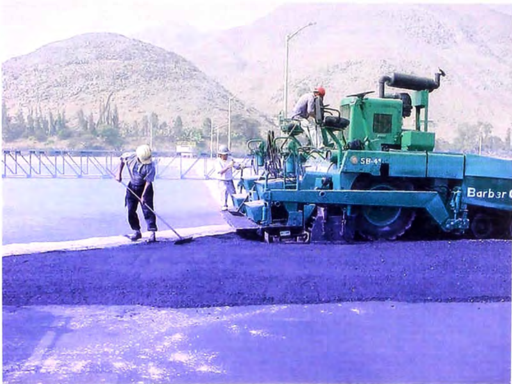
FOTO N° 201.- Asphaltado, se observa a una máquina asfaltadora Barber Greene en pleno trabajo de colocación del asfalto en caliente en la plataforma de la coronación del reservorio de compensación y ayudantes en pleno extendido.
