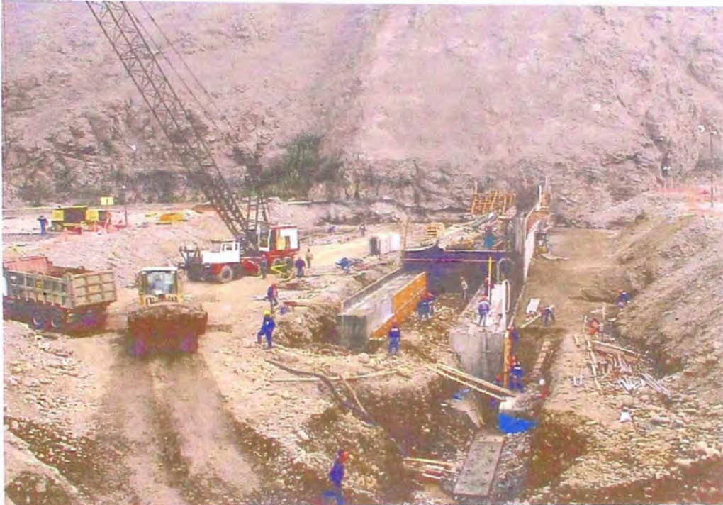
FOTO 43.- Movlización de equipo mecánico, donde se observa la excavación masiva realizada con equipo mecánico: tractor sobre oruga, retro excavadora, cargador frontal, camiones volquetes, y una pluma móvil autopropulsado, para la construcción del barraje.
