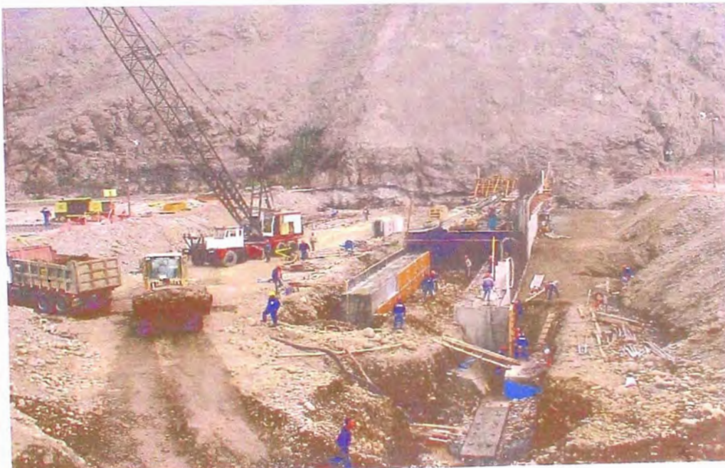
FOTO 59.- Cimientos por etapas, en la construcción del barraje, se observa como se ha colocado piedras sobresalidas después de vaciado el concreto ciclópeo, para mejorar la adherencia con el siguiente vaciado.
