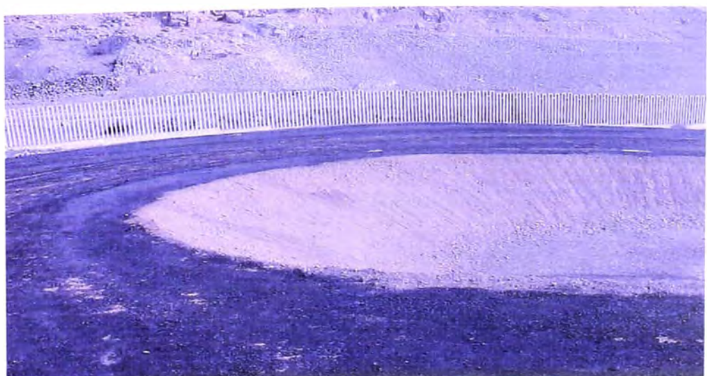
FOTO N° 192.- Imprimación del acceso lateral, al inicio de la plataforma del dique perimetral del reservorio de compensación.
