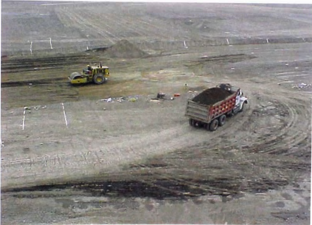
FOTO N° 1127.- Transporte del material mezclado; se observa a un camión volquete, en pleno transporte del material mejorado para la conformación del dique perimetral del reservorio de compensación.
