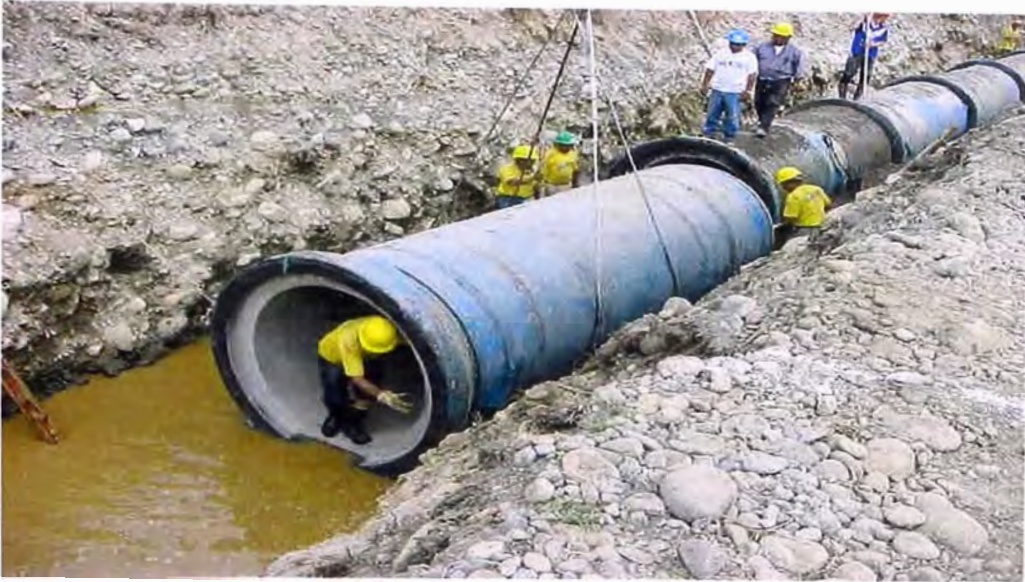
FOTO 82.- Línea de conducción; donde se aprecia la zanja abierta con inundación de agua obstaculizando el proceso normal del avance de obra para el tendido de tuberías.
