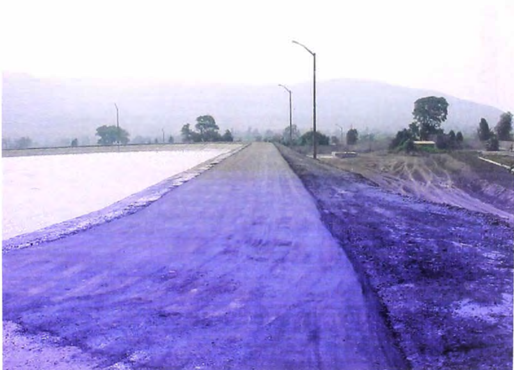
FOTO N° 198.- Imprimación , de la coronación del dique perimetral del reservorio de compensación.
