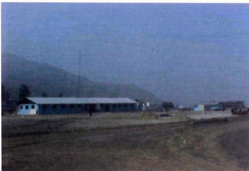
FOTO N° 106.- Campamento central , ubicado en los terrenos de la sede, para la ejecución de los trabajos del proyecto, como el reservorio de compensación, la planta de tratamiento, entre otros.
