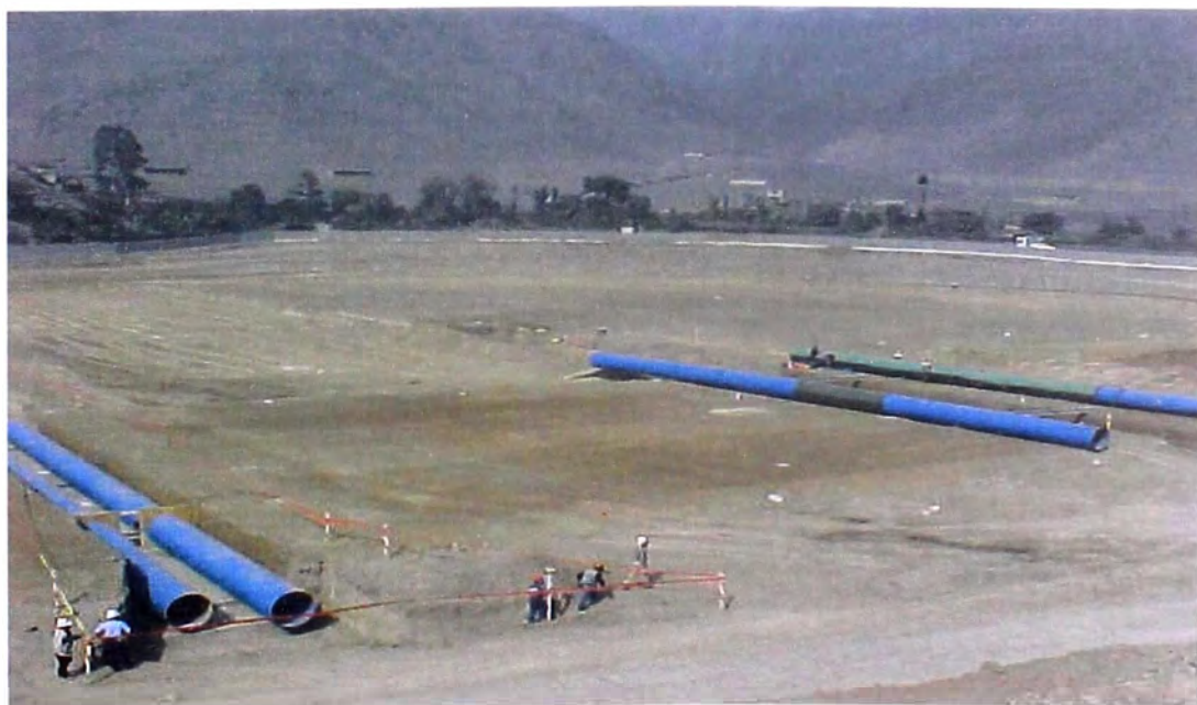
FOTO N° 153.- Estructura de salida del reservorio de compensación, se observa las tuberías metálicas para el rebose y drenaje de c/u de los estanques, ejecutadas en forma paralela a los trabajos de explanaciones de la cimentación de la plataforma del dique perimetral del reservorio de compensación.
