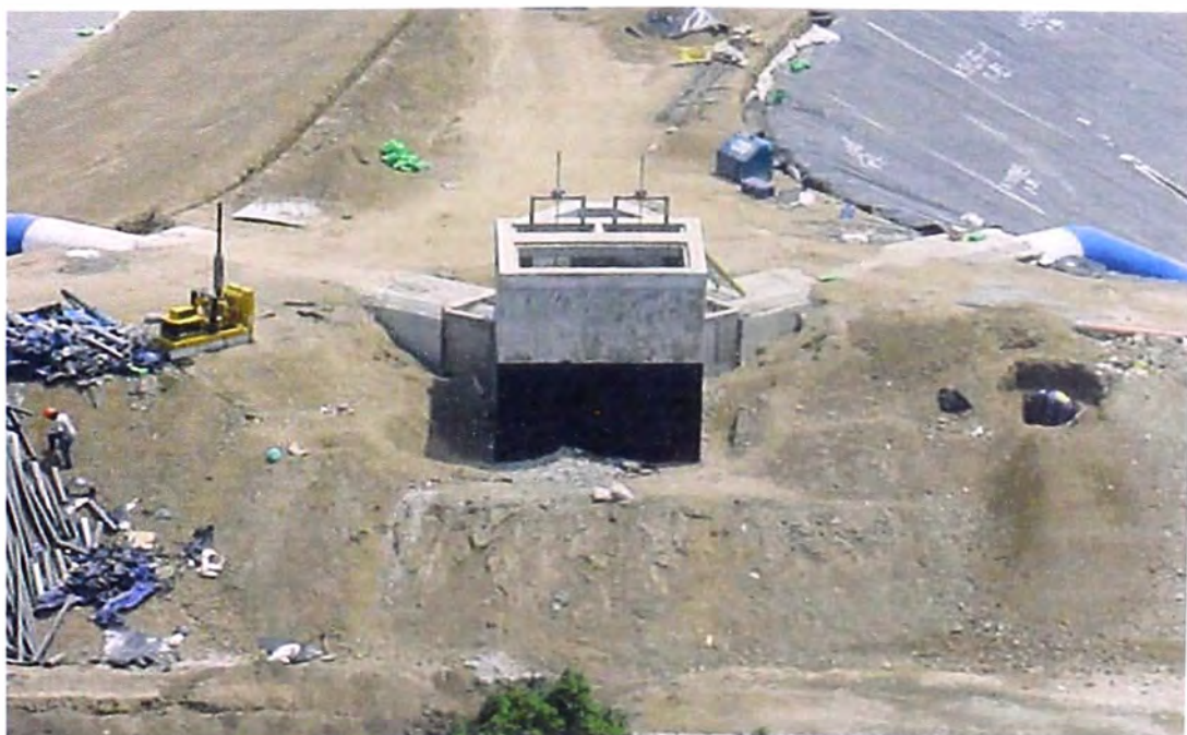
FOTO N° 149.- Estructura de entrada del reservorio de compensación exterior , se observa desde una vista exterior y/o posterior del estanque, las tuberías de distribución metálica de 1,200 mm de diámetro empalmadas, para c/u de los estanques del reservorio de compensación, asimismo la cámara de repartición de concreto armado en la parte inferior.
