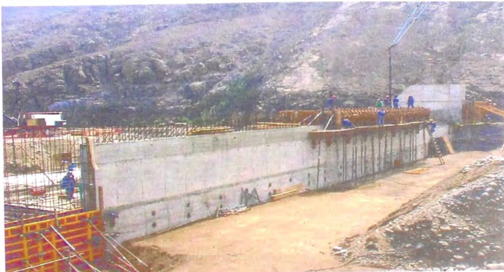
FOTO 50.- Construcción del barraje, donde se observa el relleno con material de préstamo y su compactación ejecutada del tramo aguas arriba de la pantalla.
