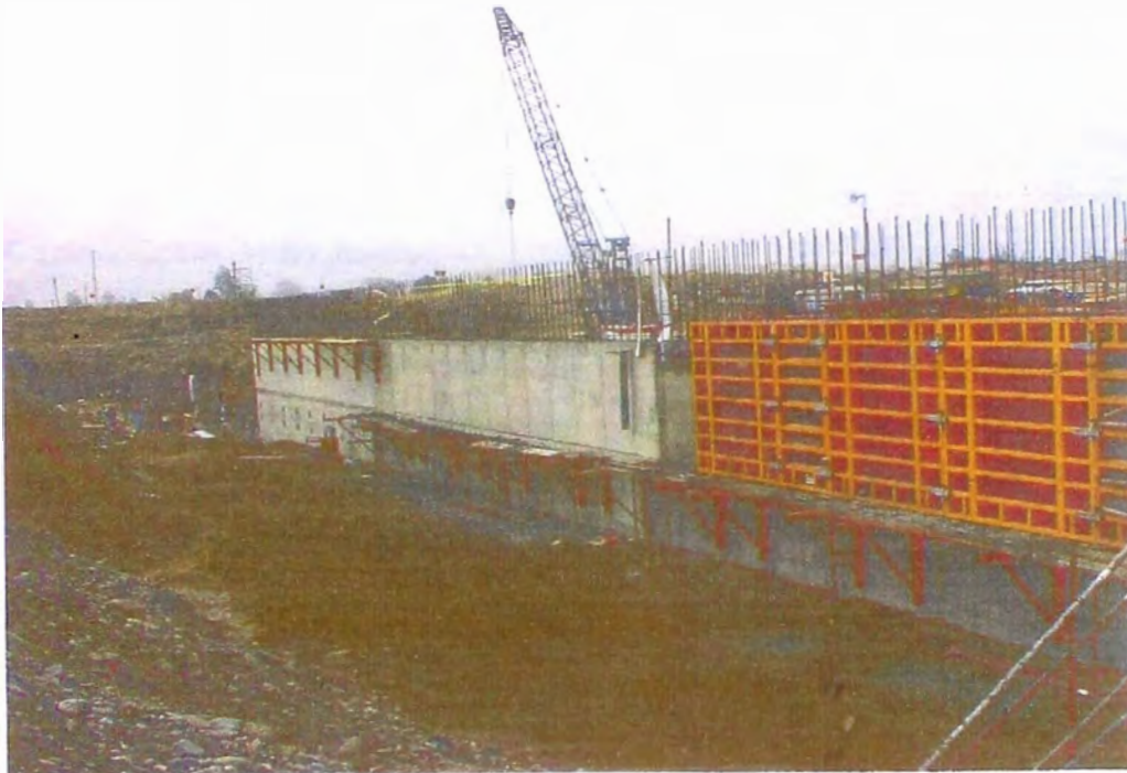
FOTO 68.- Construcción del barraje, donde se observa el encofrado y desencofrado de la pantalla del barraje. Asimismo la armadura correspondiente a la cresta.
