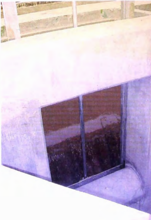
FOTOS N° 163 y 164.- Estructura de entrada, compuertas plana accionamiento manual son observados desde diferentes ángulos.
