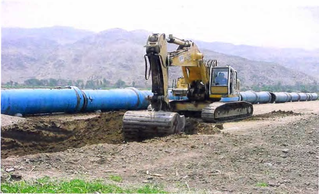
FOTO 79.- Línea de conducción; se nota el emplazamiento de las tuberías de concreto reforzado - CAP de 1400 mm de diámetro para su posterior tendido y el inicio de la ejecución de la excavación con una retroexcavadora.
