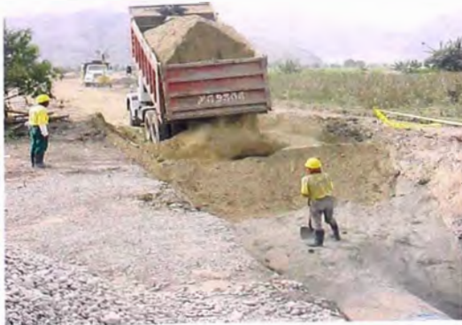
FOTO 91.- Tubería de conducción; de la línea desde la obra de captación a la Planta de Tratamiento, se observa
