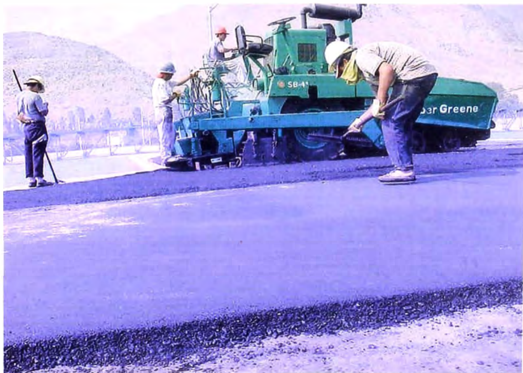
FOTO N° 202.- Asphaltado, se observa completando la colocación de la carpeta asfáltica en la franja lateral de la plataforma de la corona del reservorio de compensación.
