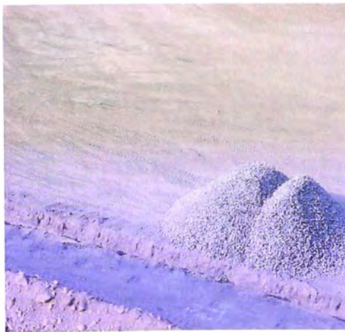
FOTOS N° 173 y 174.- Drenaje , en las dos vistas precedentes se observan la excavación, donde se colocará el material gravoso acumulado, que servirá de dren al reservorio de compensación.
