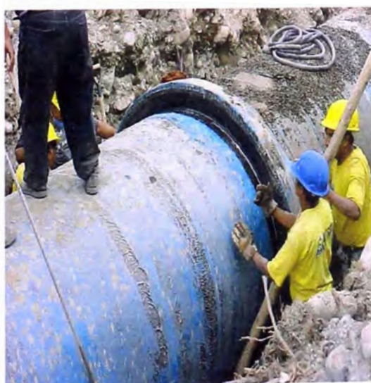
FOTO 100.- A la izquierda, embone con anillo flexible de jebes en los trabajos de la línea de conducción; desde la obra de captación a la Planta de Tratamiento.
