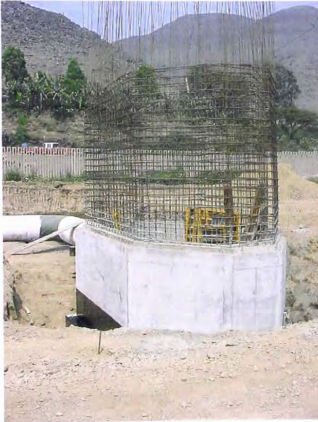
FOTO N° 139.- Cámara de estructura de entrada, en proceso de construcción de concreto armado, donde se observa la llegada de la tubería CAP de 1,400 mm de diámetro.
