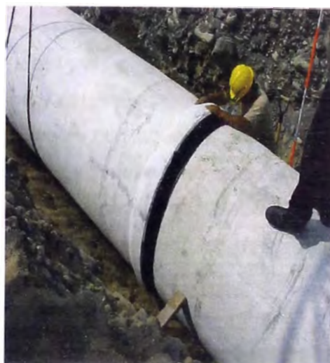
FOTO 99.- A la derecha, acoplamiento de las tuberías, durante trabajos de ejecución de la línea de conducción.
