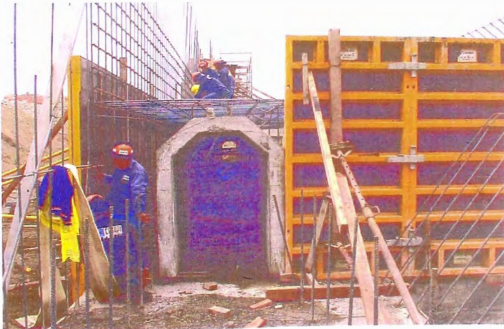
FOTO 69.- Construcción del barraje, donde se observa la colocación de la armadura de la losa del techo de la galería de drenaje.
