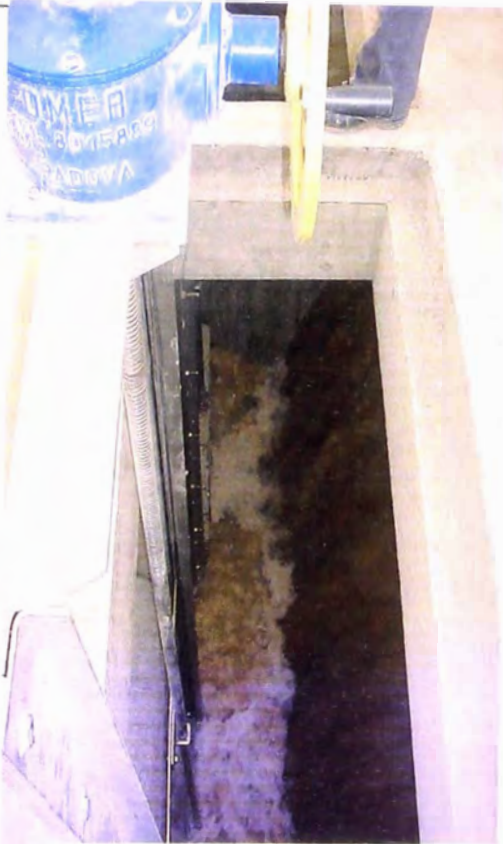
FOTO N° 165.- Estructura de entrada, compuerta plana accionamiento manual
