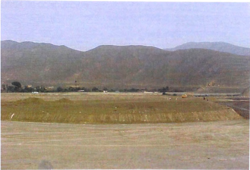
FOTO N° 121.- Excavación en material suelto; en la vista se observa panorámicamente el estado del corte efectuado del terreno, preparado para recibir a la cimentación del dique perimetral del reservorio de compensación.
