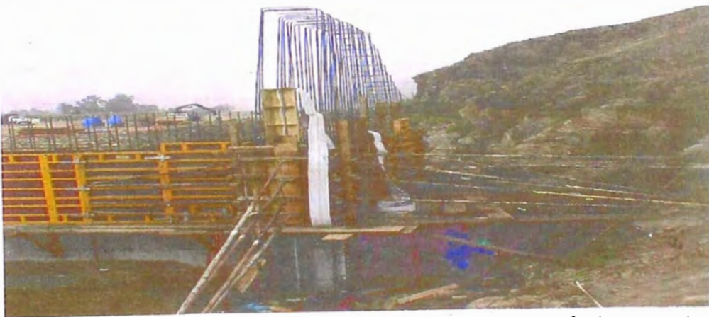
FOTO 66.- Construcción del barraje, donde se observa el encofrado y armadura de la pantalla del barraje y del muro de sostenimiento lateral derecho establecido sobre una base rocosa.
