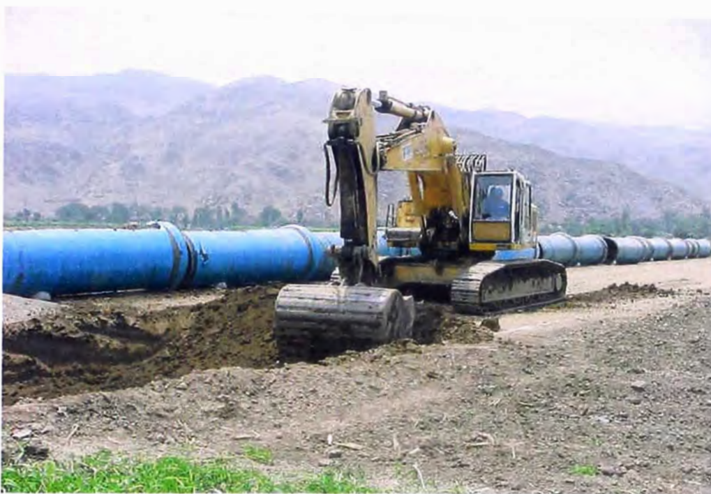
FOTO 123.- Construcción del Reservorio de Compensación, donde se observa trabajos de excavación de una retroexcavadora, para el colocado de las tuberías desde la bocatoma al reservorio.
