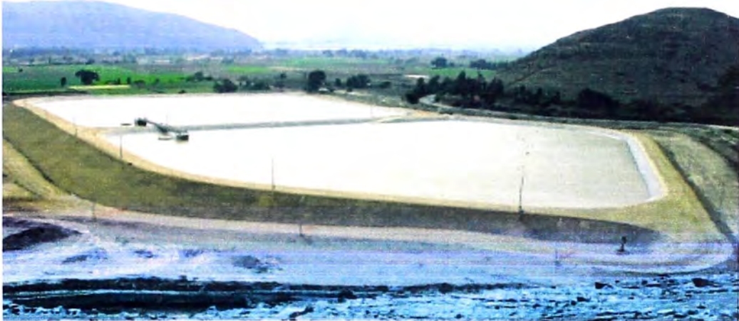
FOTO 04.- El Reservorio de Compensación , cumple los siguientes objetivos: almacenamiento de agua cruda, sedimentación de arena y finos, reducción de carga bacteriana y aplicación de polielectrolito.
