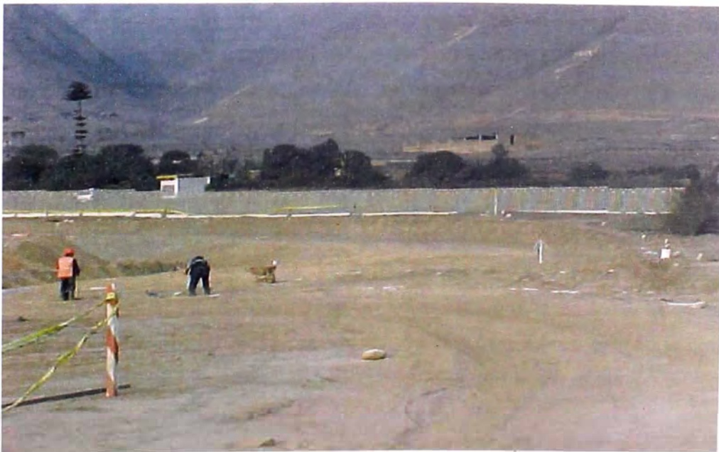
FOTO N° 115.- Seguridad para la obra , en la vista se observa el cerco perimetral tipo UNI de la Planta de Tratamiento donde se encuentra el reservorio de compensación en plena ejecución con los trabajos de topografía, como seguridad externa; y, las cintas señalizadoras como seguridad interna contra los mismos trabajadores.
