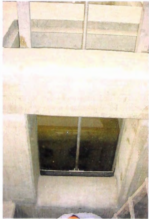
FOTOS N° 160 y 161.- Estructura de entrada, se observa las compuerta plana accionamiento manual
