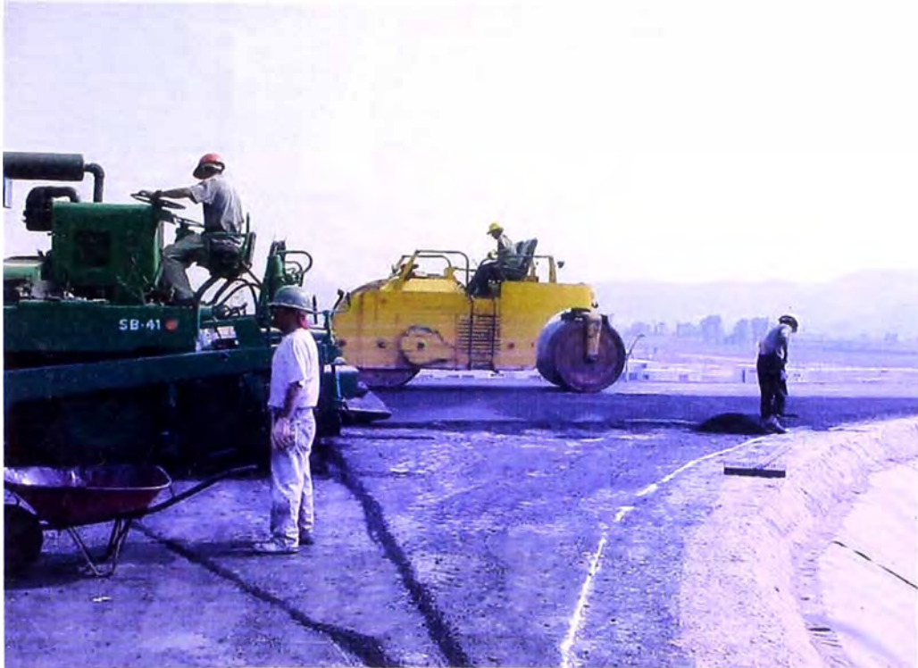
FOTO N° 197.- Asfaltado , se observa a una máquina asfaltadora y a un rodillo liso autopropulsado en pleno trabajo de asfaltado y compactación respectivamente, en la plataforma de la corona del reservorio de compensación..
