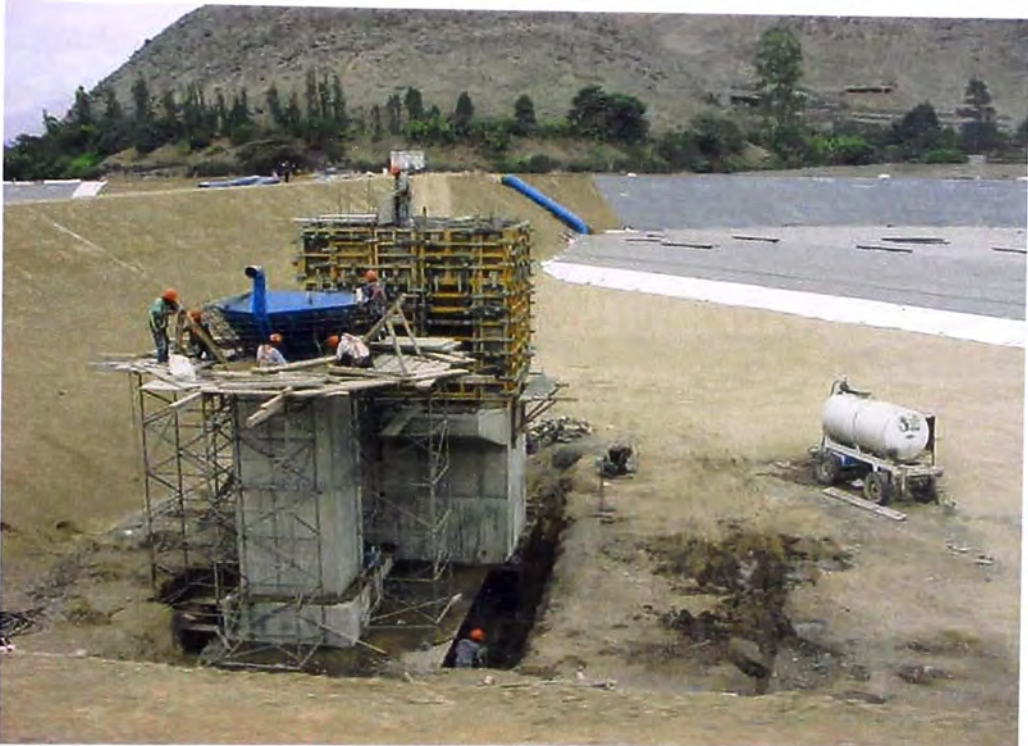
FOTO N° 116.- Seguridad para el personal, en la vista se observa a los trabajadores en la torre de estructura a 5.50 m de altura en los trabajos de encofrado con sus implementos de seguridad, como: casco, guantes, botas y cinturones de seguridad.
