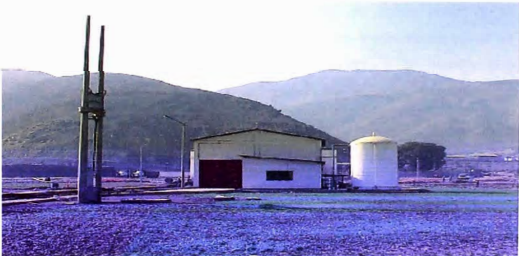
FOTO 11.- Edificio de cloración, donde se observa la caseta, almacén del cloro.
