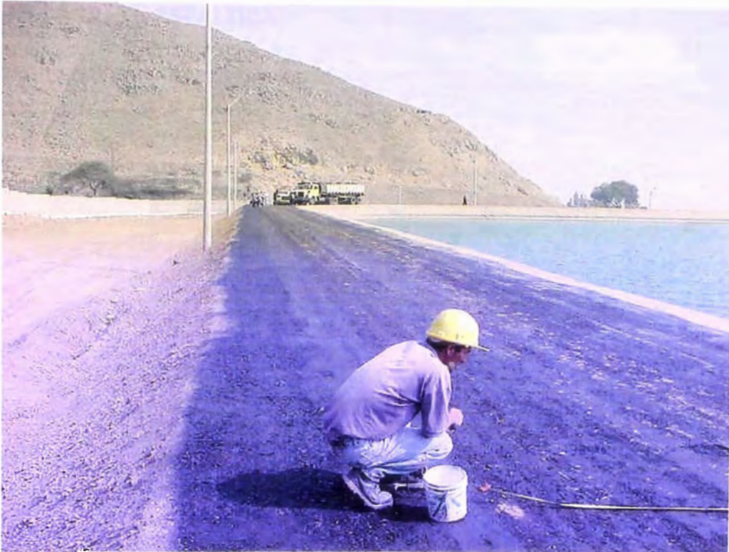
FOTO N° 193.- Imprimación, de la plataforma del dique perimetral del reservorio de compensación.
