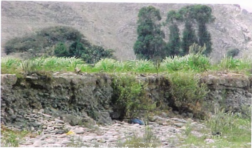
FOTO N° 42.- Eliminación de obstrucciones , ejecutado en el cauce del río con la tala de árboles y otros arbustos, para realizar las labores topográficas sobre el trazado de las obras de la bocatoma
