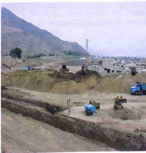
OTFOTOS N°s 118 y 119.- Acumulación de material mejorado , en las dos vistas adjuntas, se observa después de la mezcla, a dos tractores sobre oruga en el acomodo y batido del material afirmado propio del tipo detrito, para el relleno del reservorio de compensación.
