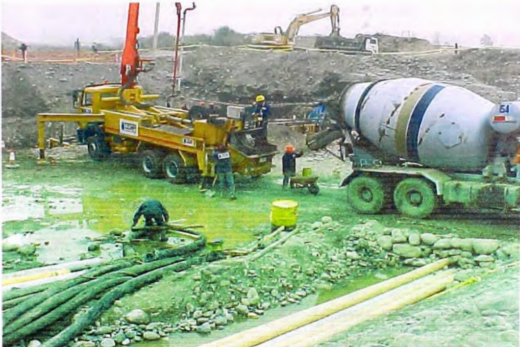
FOTO 24.- Concreto pre mezclado, se observa el camión concretero y el camión porta bomba para el transporte por tuberías del concreto, para la diferentes estructuras de la obra de captación y otros.
