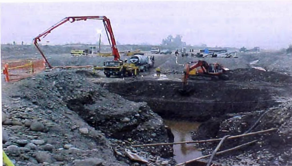
FOTO 48.- Construcción del barraje , donde se observa la excavación masiva y el problema de filtración de agua para la cimentación.
