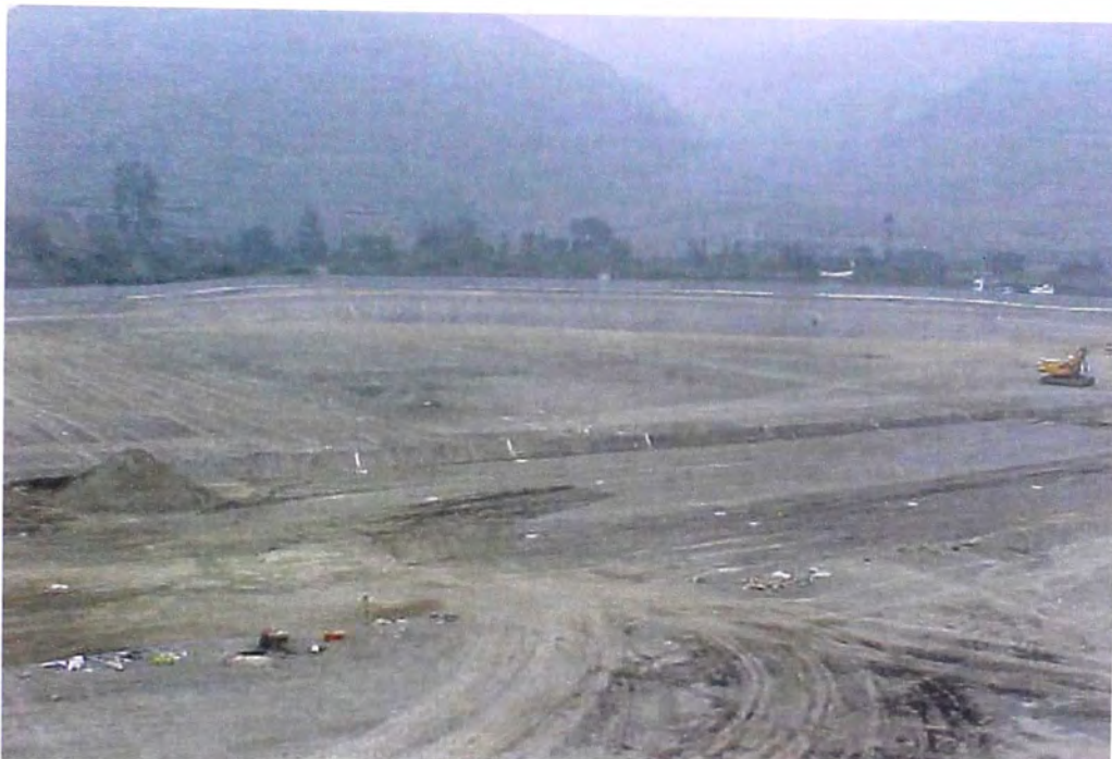
FOTO N° 114.- Trazado y nivelación topográfica , en el proceso de ejecución de obra del reservorio de compensación, se nota el tizado respectivo que indican los alineamientos y cotas correspondientes al dique.
