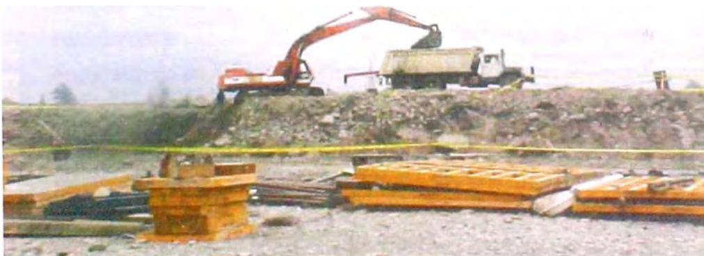
FOTO 23.- Madera , se observa preparado para su ejecución en el montaje del encofrado en la estructura de las pantallas de los lechos de filtración.
