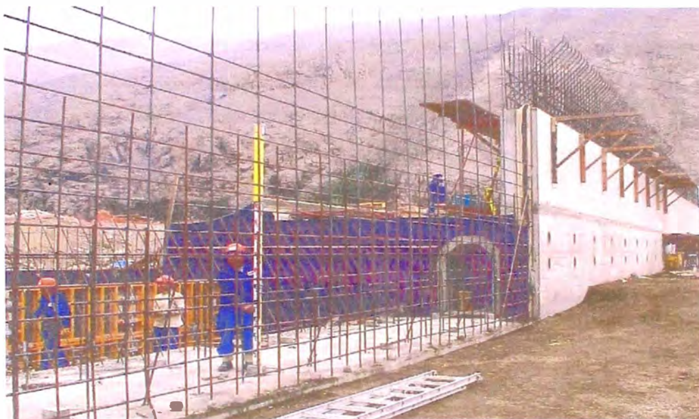
FOTO 46.- Nivelación topográfica , en la construcción de la cimentación del barraje, se nota la galería de drenaje y de los orificios en la pantalla para el drenaje respectivo, debido a las subpresiones de aguas arriba, y asimismo se observa la nivelación topográfica permanentemente realizada en obra.
