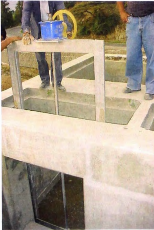
FOTOS N° 160 y 161.- Estructura de entrada, se observa las compuerta plana accionamiento manual
