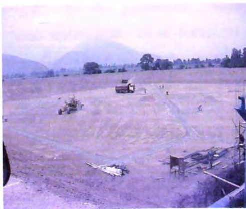
FOTOS N°. 175 y 176.- Drenaje , se observan en las vistan anteriores, el material de grava colocado sobre una base de geotextil, en la excavación previamente ejecutadas, que servirá de drenaje al exterior del reservorio de compensación.
