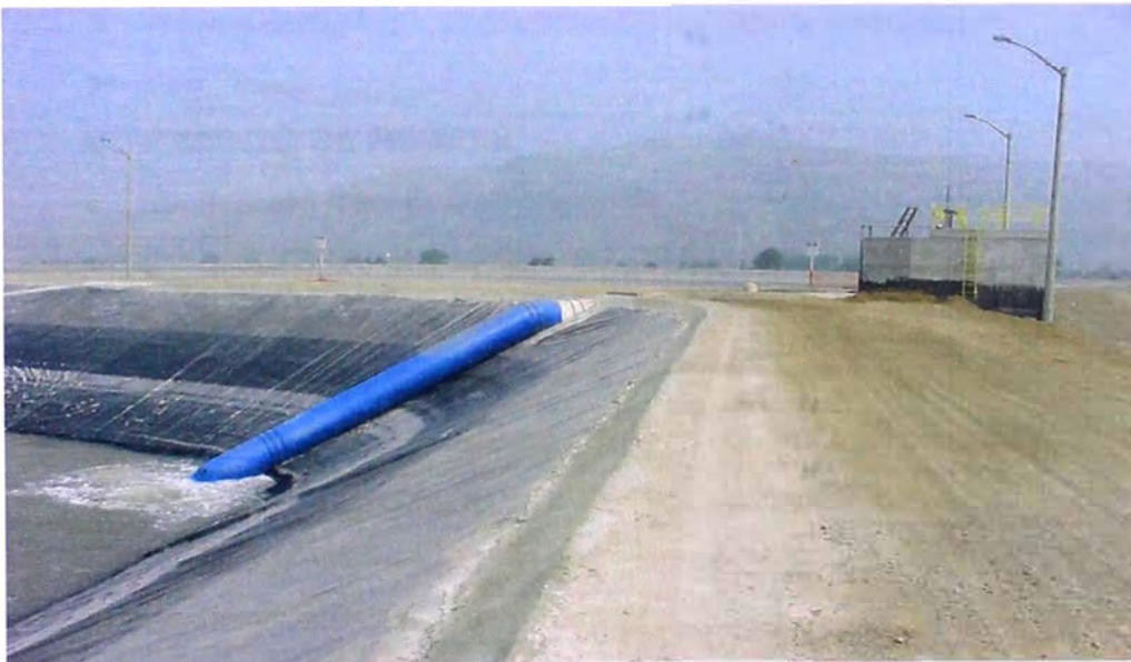
FOTO N° 104.- Estructuras de Entrada del Reservoirio de Compensación, en la que se observa culminado, con la prueba a su embalsamiento.
