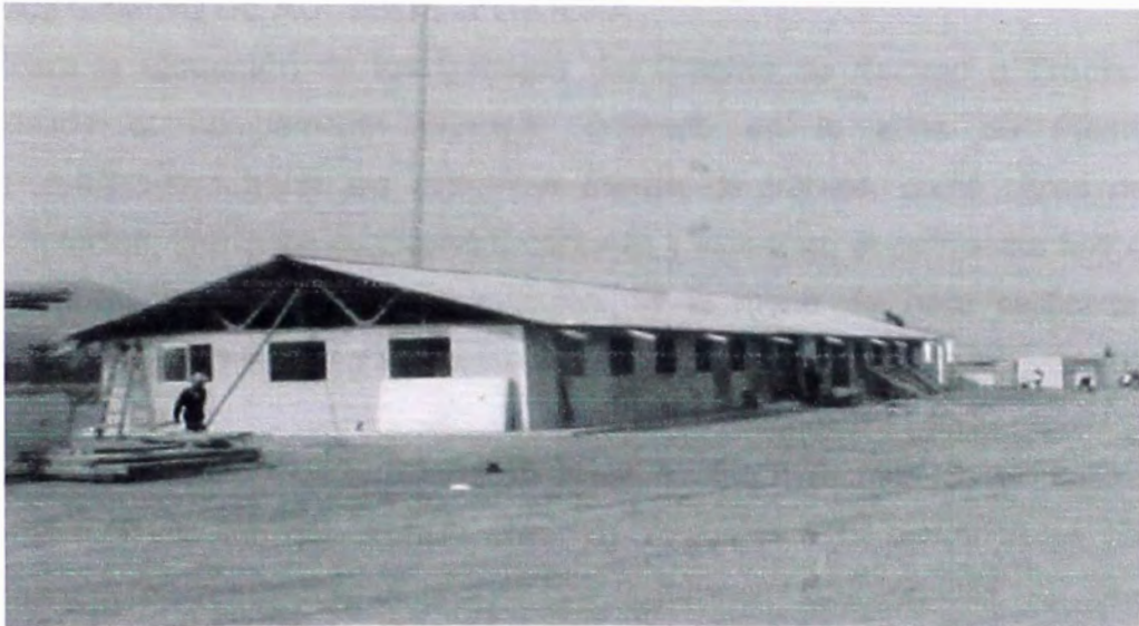
FOTO 38.- Campamento principal, frente a la planta de tratamiento y reservorio de compensación, donde se ubicó el personal, materiales, herramientas y/o equipos necesarios para la ejecución de la obra.
