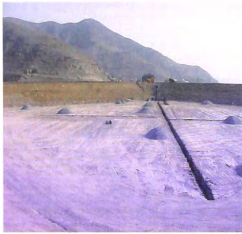
FOTOS N° 173 y 174.- Drenaje , en las dos vistas precedentes se observan la excavación, donde se colocará el material gravoso acumulado, que servirá de dren al reservorio de compensación.
