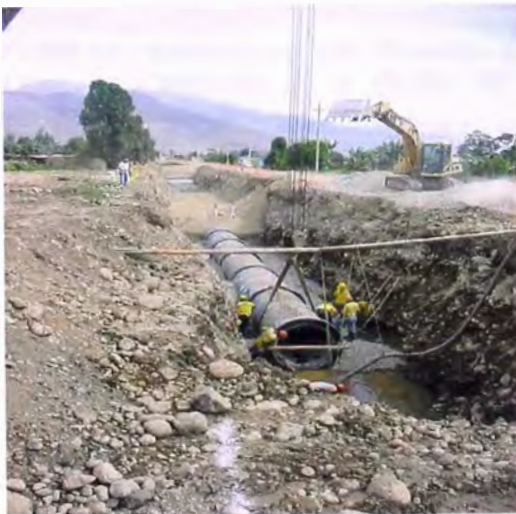
FOTO 83.- Tubería en cruce de cables eléctricos; en la zanja excavada se nota la dificultad para el tendido de la red de tubería.
