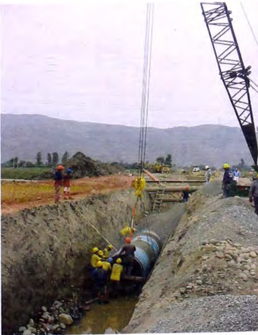
FOTO 85.- Tubería de conducción; de la línea desde la Obra de Captación a la Planta de Tratamiento, se observa el izaje de la tubería con pluma, para el tendido respectivo, con la dificultad del agua inundada.
