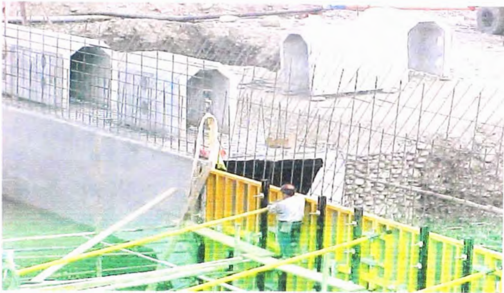
FOTO 35.- Elementos pre fabricados de concreto, para la estructura que comprende la galería de drenaje del barrage, colocado aguas arriba.
