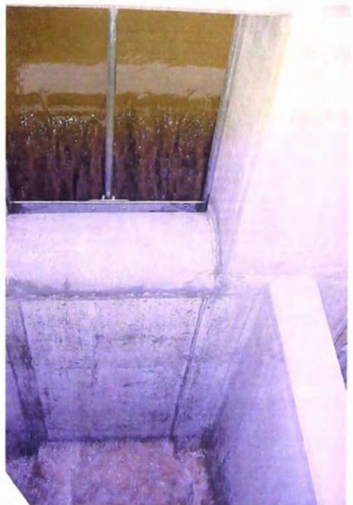
FOTOS N° 163 y 164.- Estructura de entrada, compuertas plana accionamiento manual son observados desde diferentes ángulos.
