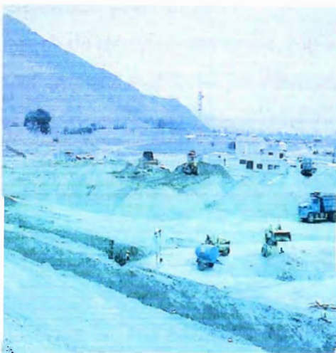
FOTOS 31 y 32.- Acumulación de material propio, en las dos vistas adjuntas, se observa a dos tractores sobre oruga en el acomodo y batido del material propio del tipo detrito, para el relleno del reservorio de compensación.
