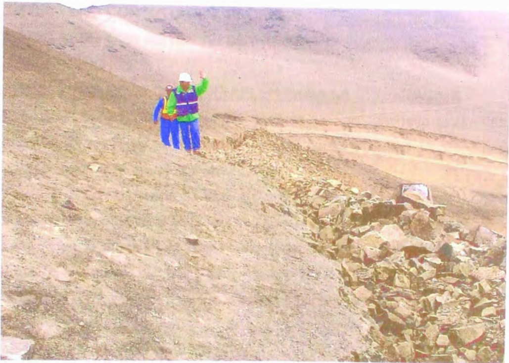
FOTO 125.- Construcción del Reservorio de Compensación. donde se observa acumulación de roca suelta después del corte con explosivos, para su extracción.
