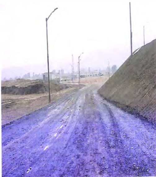
FOTOS N°s 190 y 191.- Imprimación del acceso lateral, subiendo a la plataforma del reservorio de compensación.
