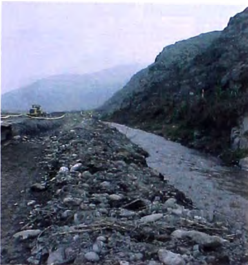
FOTO 44.- Desvío del río, en la construcción de la cimentación del barrage por etapas, se observa el desvío lado derecho del cauce del río Chillón.
