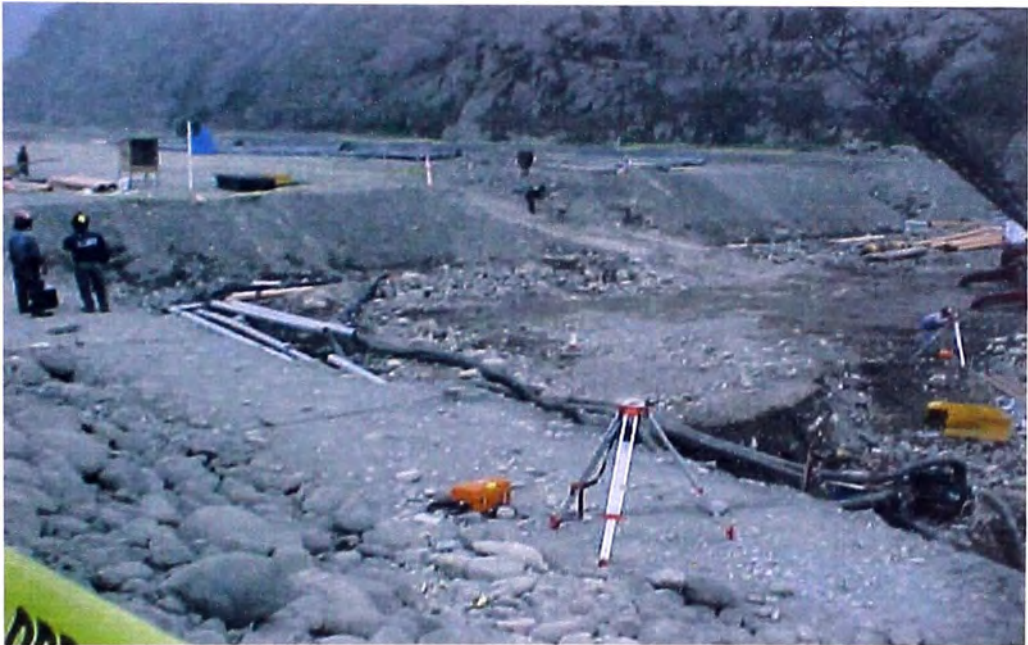
FOTO 45.- Trazo y nivelación topográfica, en la construcción de la nivelación del barraje, se observa personal laborando en el trazado y nivelación de la cimentación.
