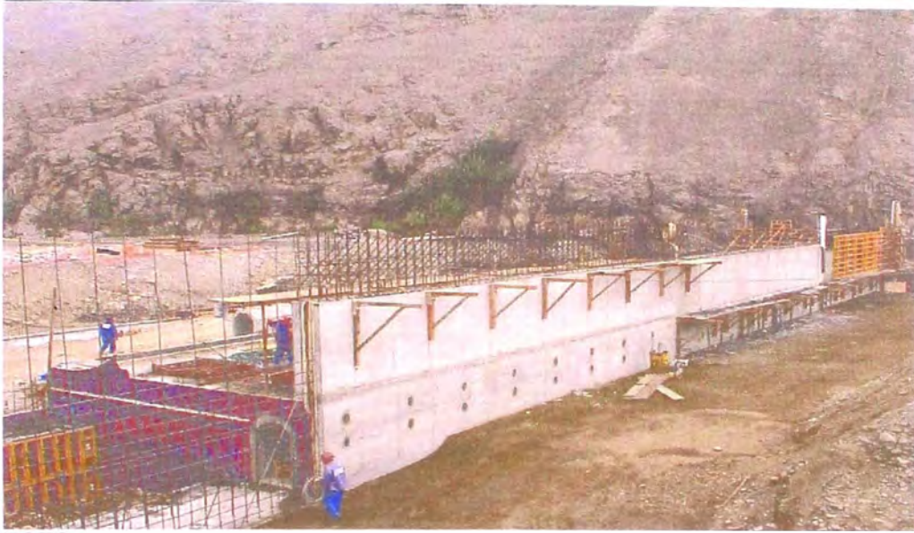
FOTO 62.- Instalación de elementos prefabricados, en la construcción del barraje, se observa lo instalado de dichos elementos prefabricados de la galería de drenaje, aguas arriba.
