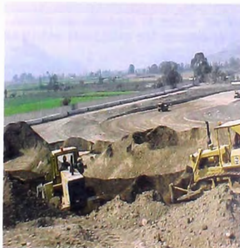
OTFOTOS N°s 118 y 119.- Acumulación de material mejorado , en las dos vistas adjuntas, se observa después de la mezcla, a dos tractores sobre oruga en el acomodo y batido del material afirmado propio del tipo detrito, para el relleno del reservorio de compensación.
