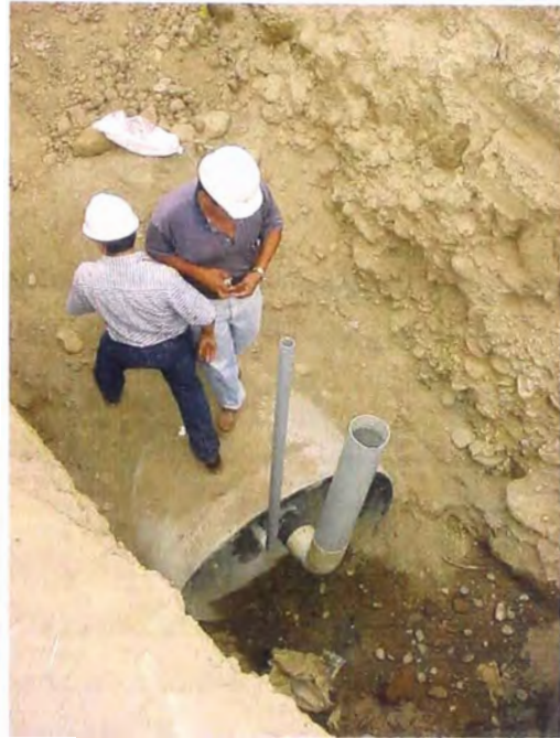
FOTOS 101 y 102.- A la derecha, acoplamiento de las tuberías, durante trabajos de ejecución de la línea de conducción
