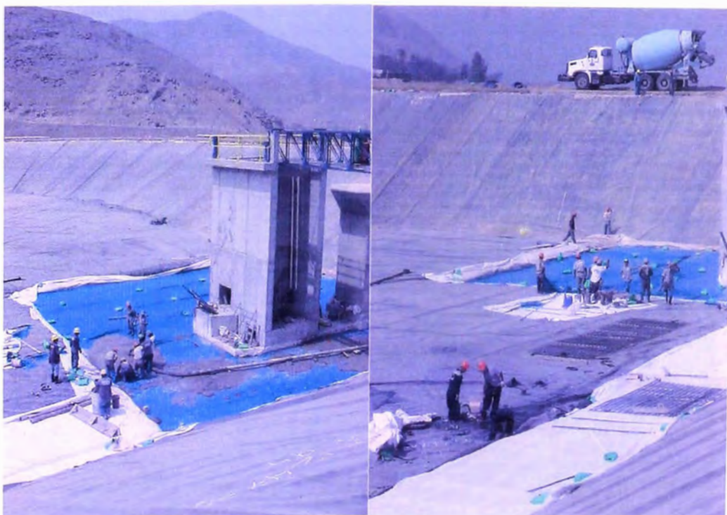
FOTOS N° 185 y 186.- Geomembrana, se observa en las dos vistas, la colocación del concreto pre mezclado sobre el geotextil protector ya instalado, para la losa cementada adyacente de la estructura de salida del reservorio de compensación, a donde llegará el camino de acceso a la base del estanque.
