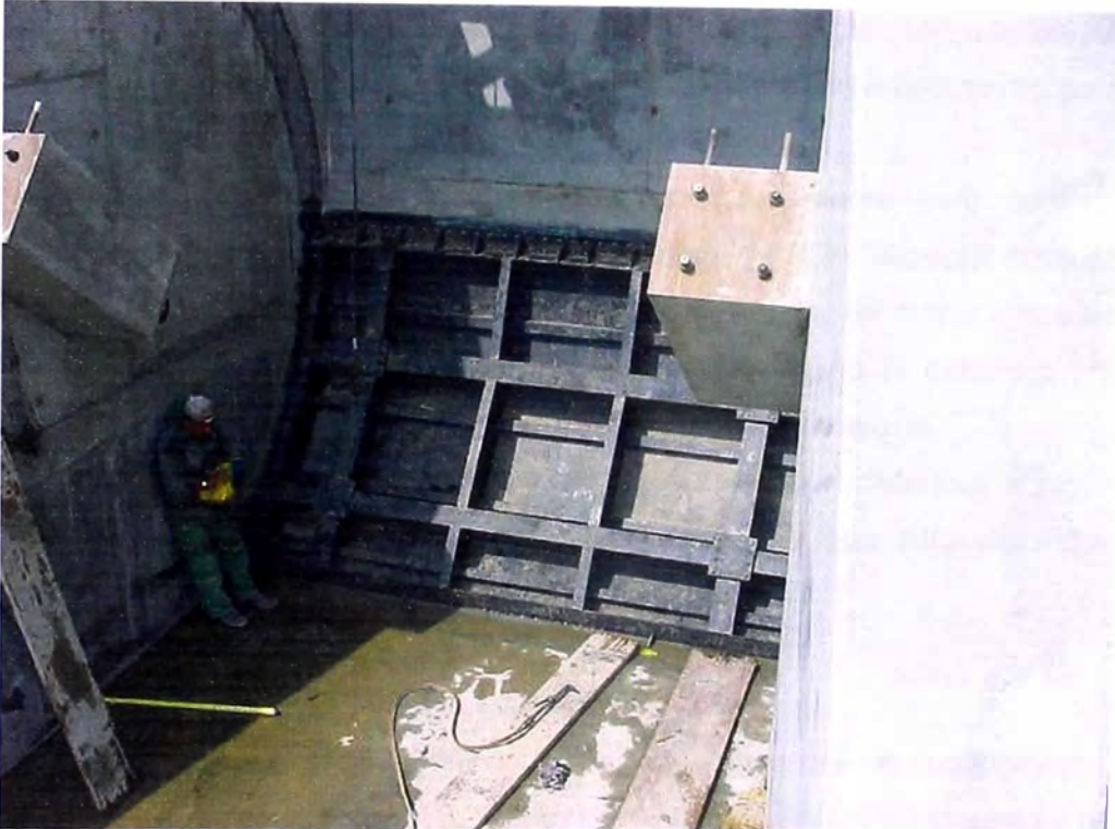
FOTO 71.- Compuerta radial motorizada , se observa la parte interior de la compuerta en uno de los canales de limpia, de la obra de captación, como los dos dados de concreto empotrados en los muros que sirven de apoyo a los tirantes del control de la compuerta.
