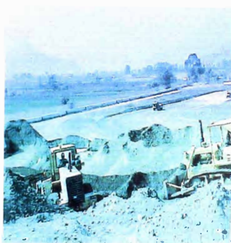
FOTOS 31 y 32.- Acumulación de material propio, en las dos vistas adjuntas, se observa a dos tractores sobre oruga en el acomodo y batido del material propio del tipo detrito, para el relleno del reservorio de compensación.
