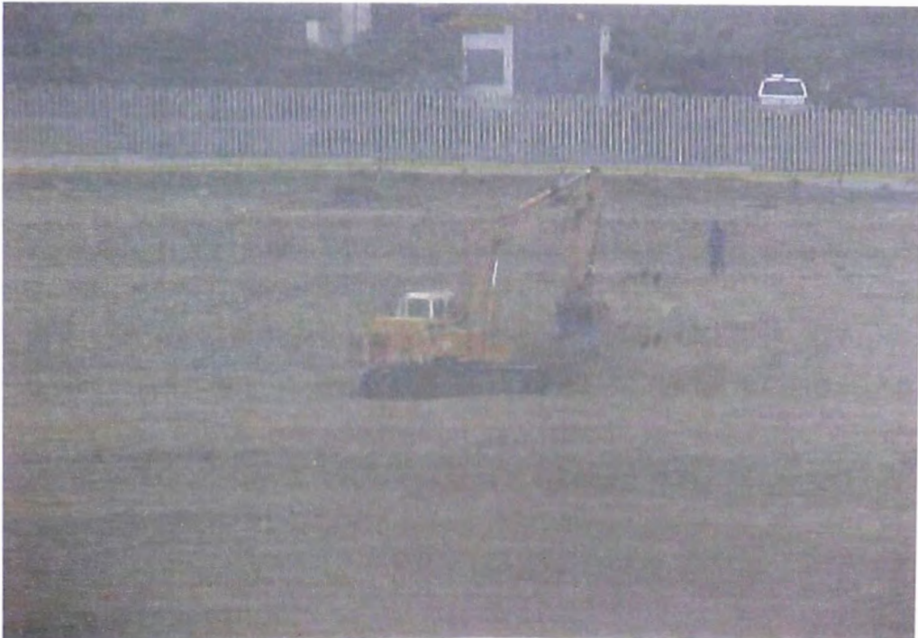
FOTO N° 120.- Excavación en material suelto; se observa el inicio de los trabajos de excavación para la ejecución de los estanques del reservorio de compensación.
