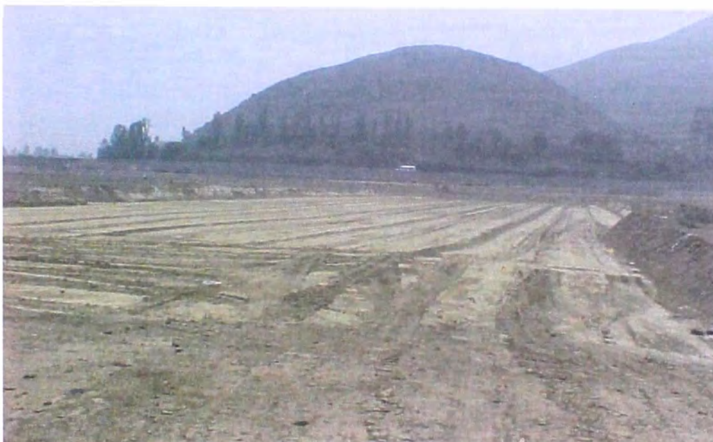
FOTO N° 110.- Limpieza de terreno, eliminación de basura, hierbas y extracción de la tierra de cultivo, donde se ejecutará el reservorio de compensación.
