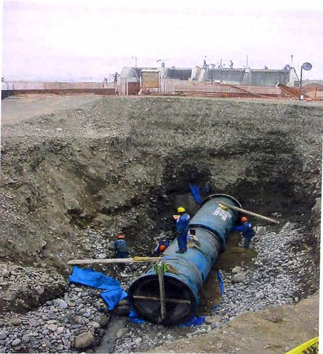
FOTO 80.- Línea de conducción; se capta la tubería de concreto reforzado, emplazada en la base de la excavación, en el inicio de la línea de la Obra de Captación hacia la Planta de Tratamiento, asimismo se nota el material suelto predominante.
