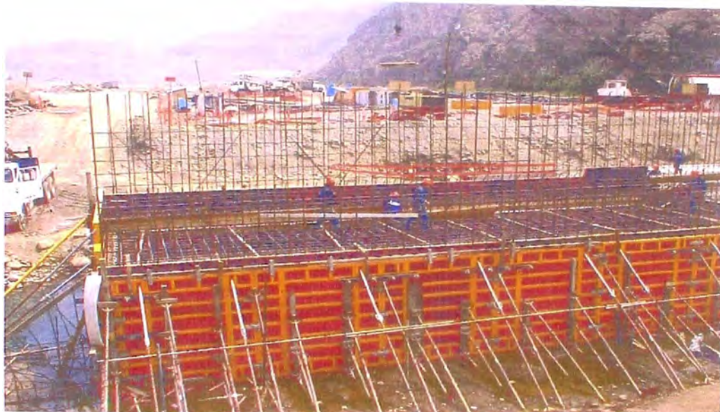
FOTO 61.- Construcción del barraje , donde se observa el apuntalamiento del encofrado de madera de las pantallas y losa del barraje. Se nota asimismo, la junta de construcción con water stop en un borde de las esquinas.
