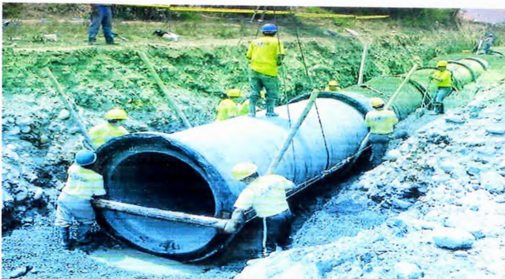
FOTO 28.- Tubería de conducción; de la línea desde la obra de captación a la Planta de Tratamiento, se observa que es de material de concreto armado pretensado – CAP, de 1400 mm de diámetro.
