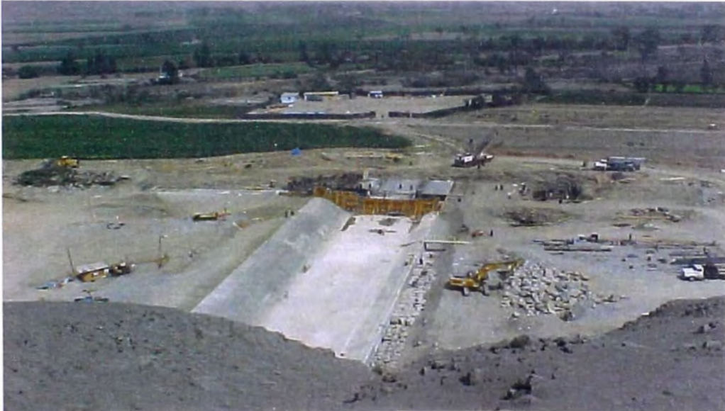
FOTO 72.- Enrocado de piedras, se observa a lo largo de la ribera del margen izquierdo del río aguas arriba y aguas debajo del lugar donde se ejecutó las obras de captación
