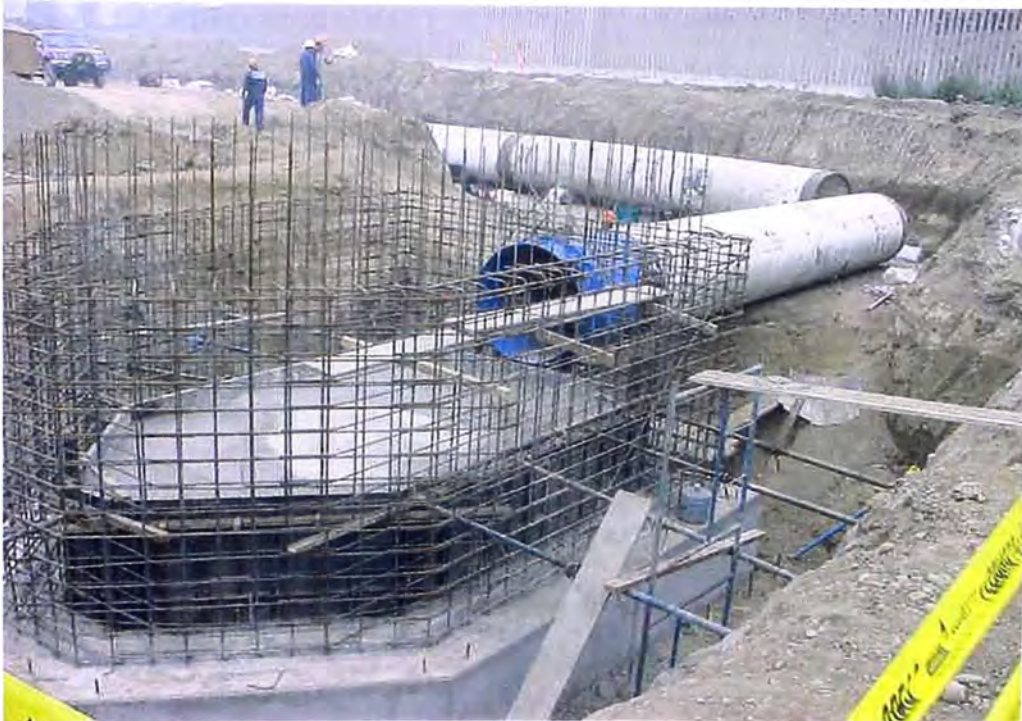
FOTO N° 143.- Concreto simple, en la base de la estructura de entrada del reservorio de compensación, se observa la llegada desde la bocatoma, de la tubería de recolección de CAP de 1,400 mm de diámetro sobre la base de la cámara, asimismo la armadura respectiva de fierro corrugado colocado para los muros.
