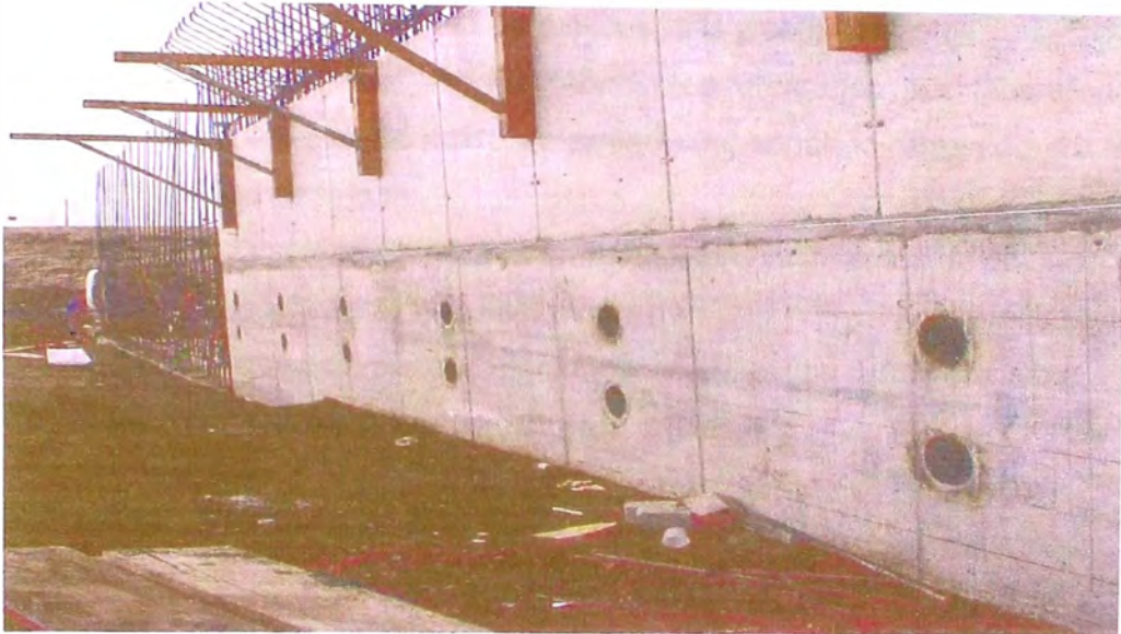
FOTO 67.- Construcción del barraje , se nota el acabado final del concreto armado de la pantalla del barraje, así como los orificios de la galería de drenaje aguas arriba.
