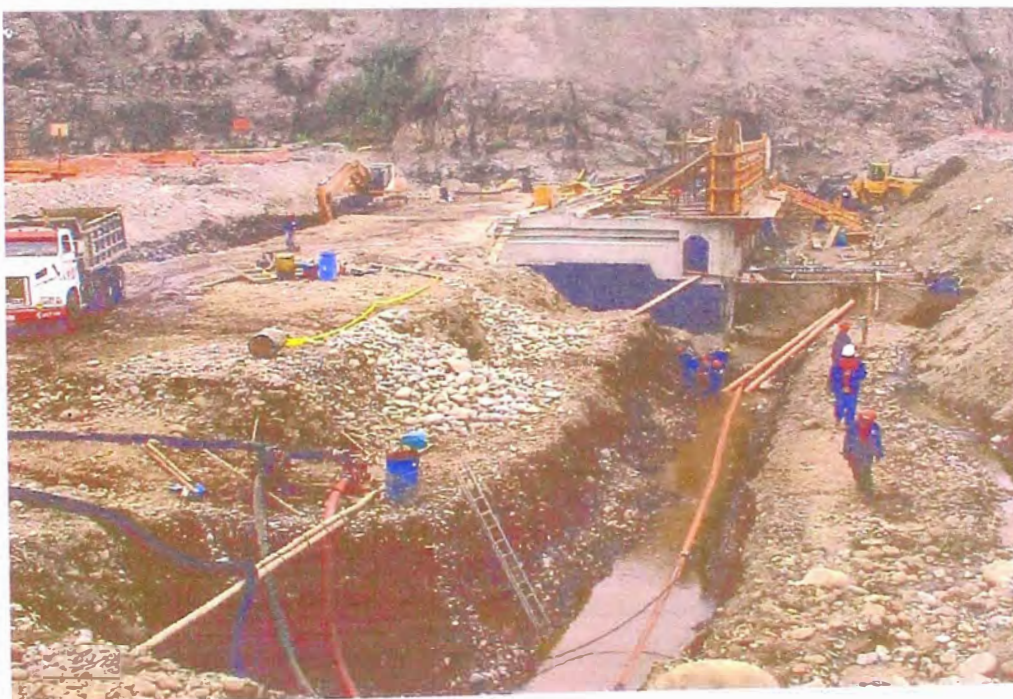
FOTO 49.- Construcción del barraje, donde se observa problema de filtración de agua en la base de cimentación de la pantalla aguas arriba, que con ayuda de dos motobombas se extrae el líquido. Asimismo se observa la excavación con retroexcavadora para la cimentación de la pantalla sumergida aguas abajo.
