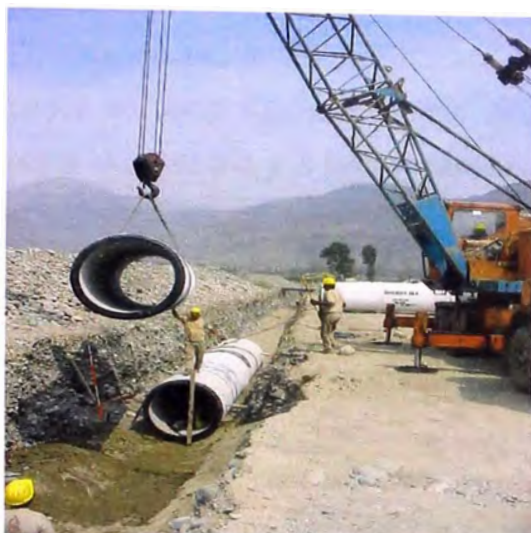
FOTO 98.- A la derecha, acoplamiento de las tuberías, durante trabajos de ejecución de la línea de conducción.
