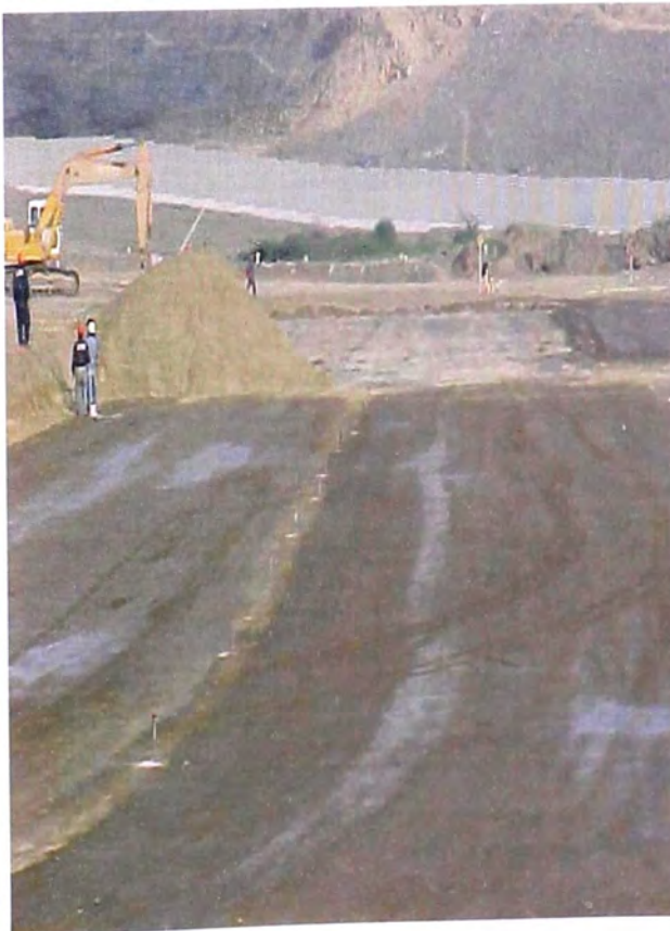
FOTO N° 132.- Se observa ya regado la plataforma del relleno para su compactación, del reservorio de compensación, asimismo a su continuación la acumulación de material afirmado para la conformación del terraplén.
