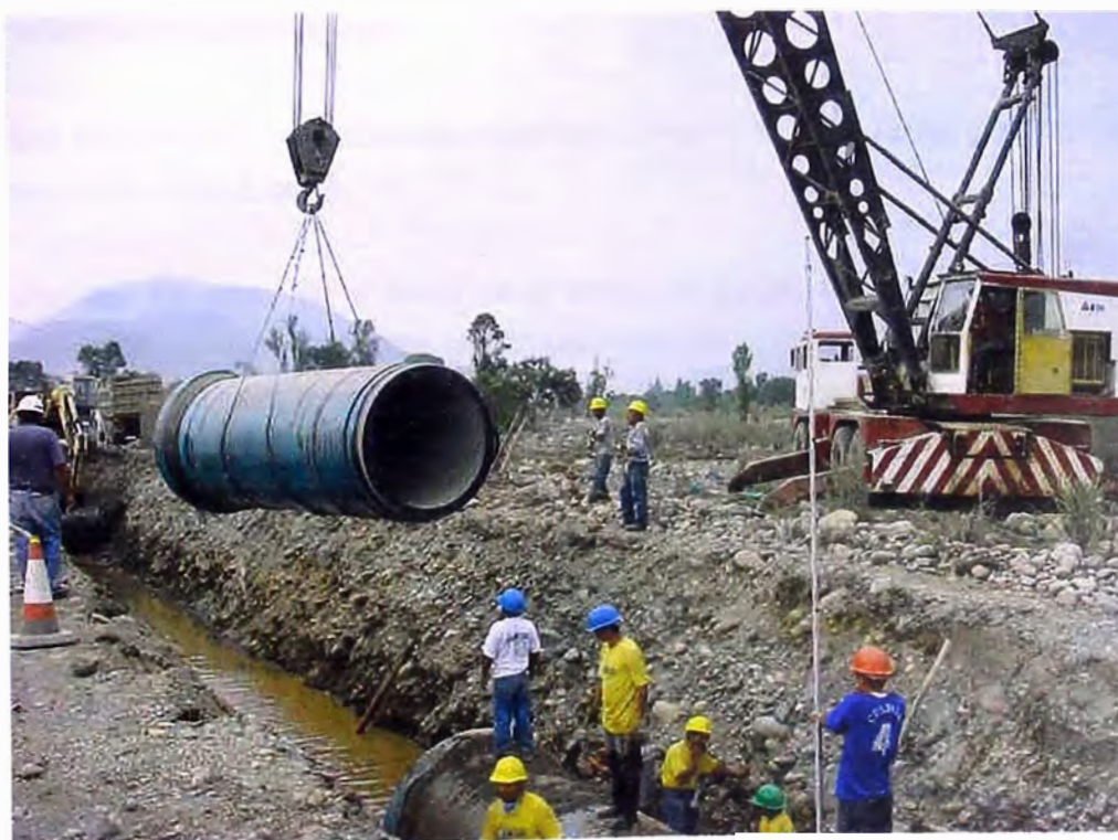
FOTO 97.- Colocación de la tubería; con un apluma autopropulsada sobre llantas, se iza la tubería para ser colocada en la zanja excavada con problemas de inundación.
