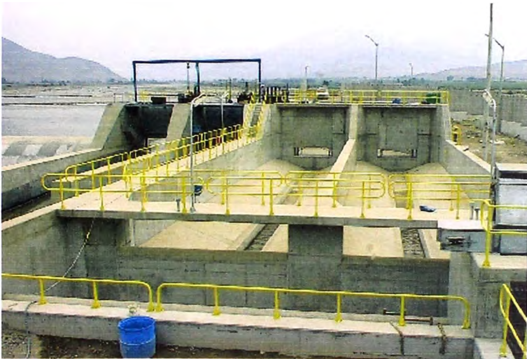
Foto 02.- La función de la Bocatoma es elevar el nivel de las aguas del río, para permitir su captación mediante una obra de toma lateral y luego conducir el agua cruda hacia la Planta de Tratamiento.
