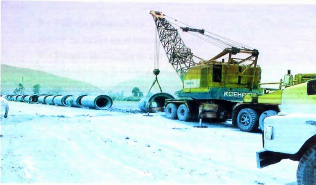
FOTO 29.- Tubería de conducción; en pleno proceso de descarga de las tuberías que se han instalado en el proyecto
