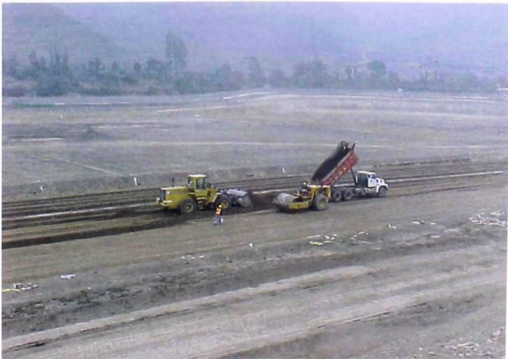
FOTO N° 128.- Descarga del material; se observa a un camión volquete descargando material afirmado mejorado y a un cargador frontal extendiendo el mismo, en la plataforma del dique perimetral del reservorio de compensación.
