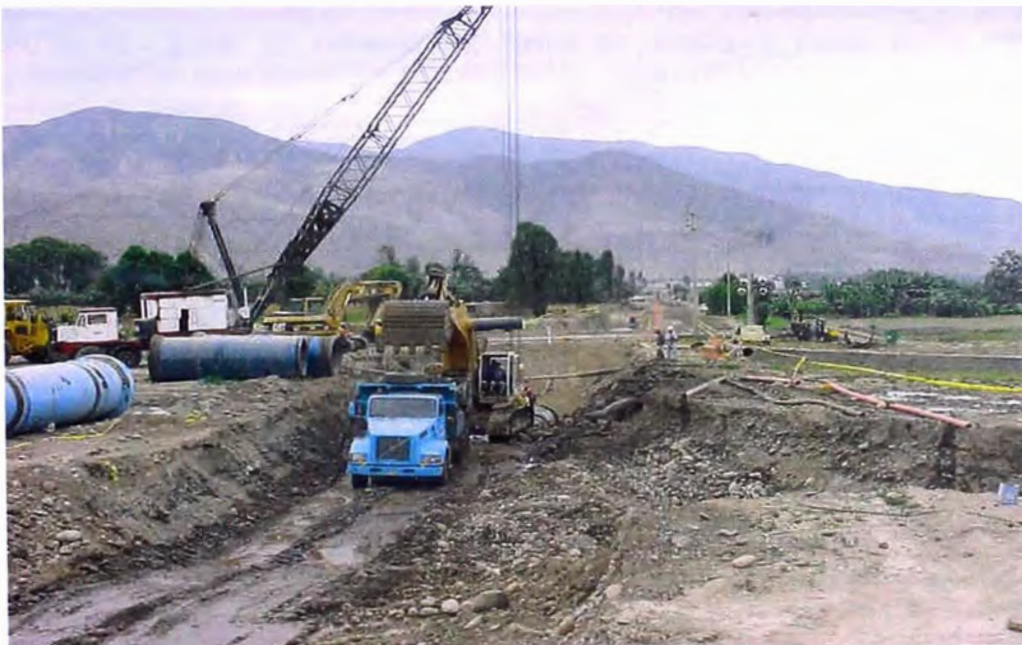
FOTO 81.- Tubería en roca suelta; de la línea de conducción para la obra de captación, se observa las excavaciones donde se encontraron material rocoso
