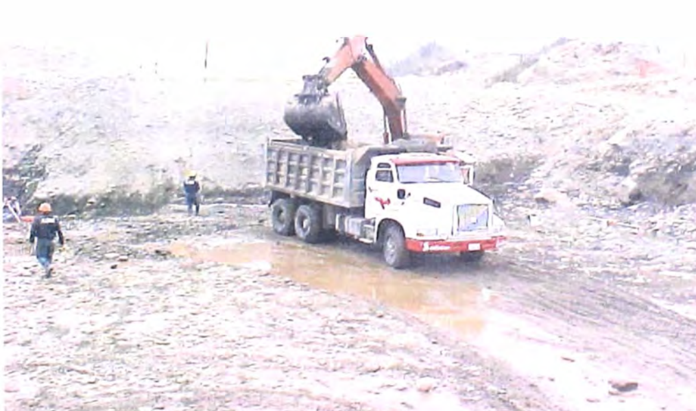
FOTO 55.- Construcción del barrage, donde se observa el carguío de material excedente de la obra de construcción del barrage.
