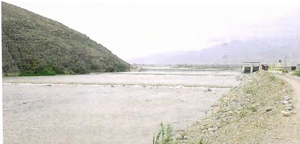
FOTO 17.- Estructuras de Derivación de una bocatoma, para la captación de agua superficial.
