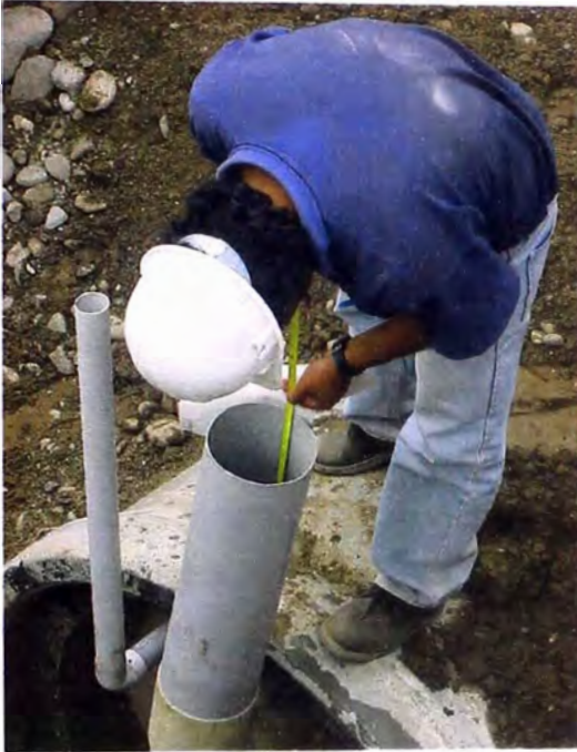
FOTOS 101 y 102.- A la derecha, acoplamiento de las tuberías, durante trabajos de ejecución de la línea de conducción
