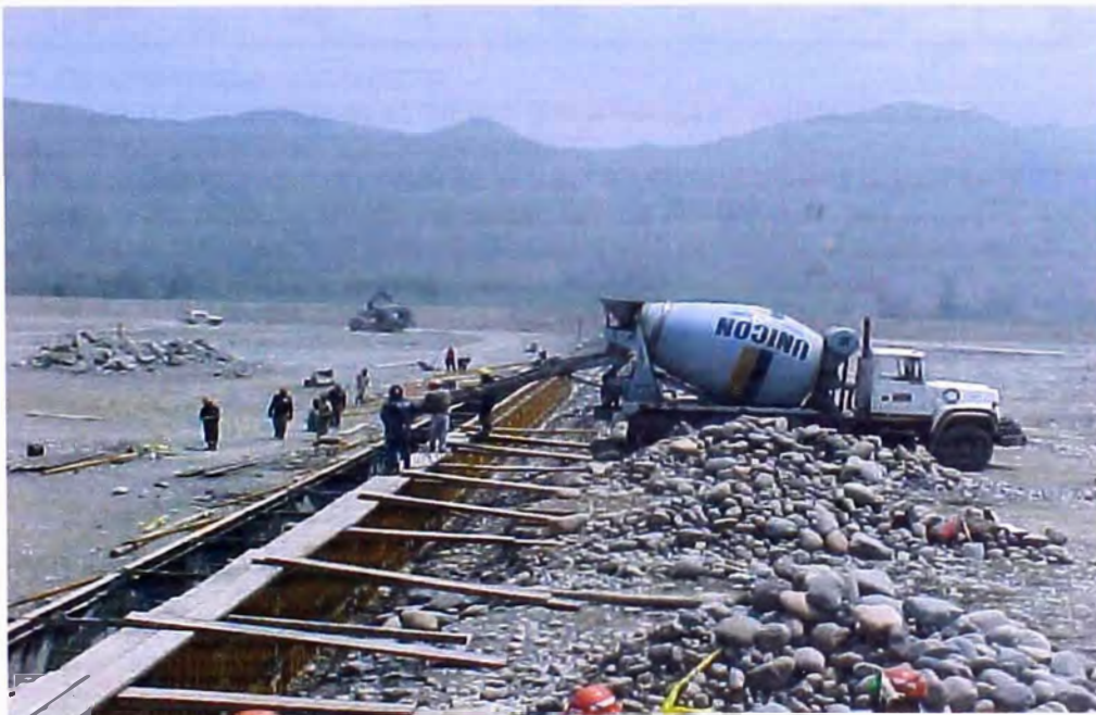
FOTO 60.- Concreto pre mezclado , donde se observa el encofrado de los muros de las pantallas de los lechos de filtración y el colcado del concreto pre mezclado, aguas arriba de la bocatoma.
