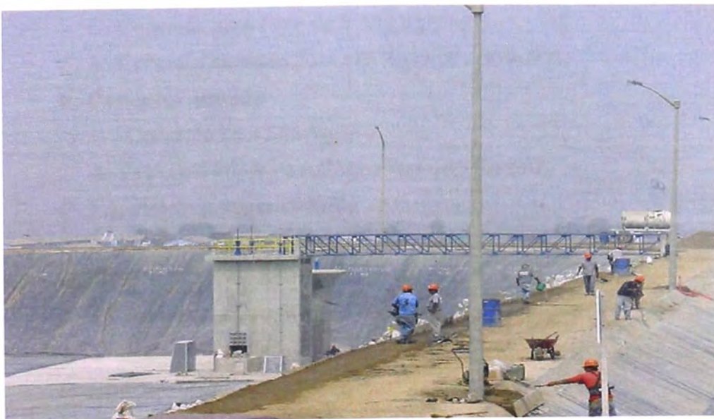
FOTO N° 105.- Estructuras de Salida del Reservoirio de Compensación, en la que se observa culminado y en pleno proceso el montaje de sus compuertas.
