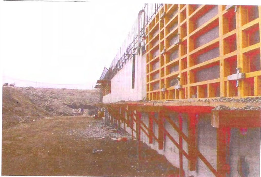
FOTO 70.- Construcción del barrage , donde se observa el inicio de los trabajos de la forma de la armadura de la cresta del barrage en su última etapa.
