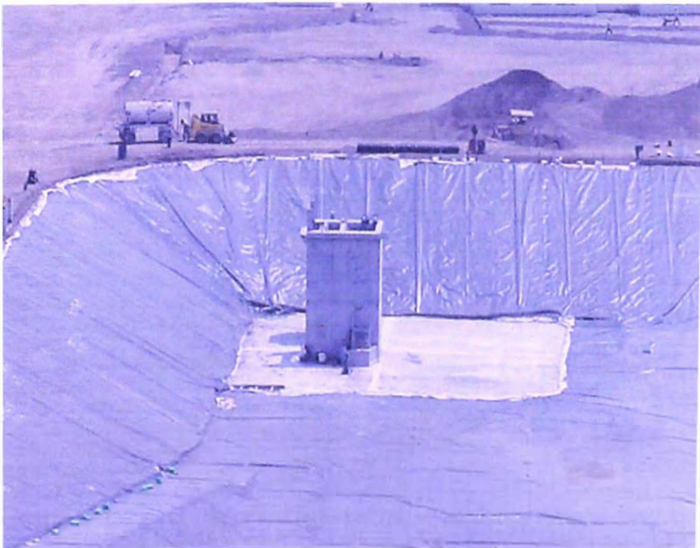
FOTO N° 183.- Geomembrana, se observa colocada la tercera capa correspondiente al geotextil para la impermeabilización, de la estructura de salida, del reservorio de compensación.
