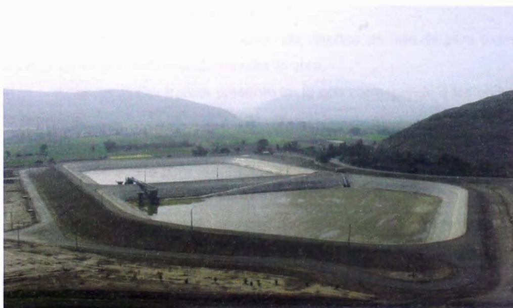
FOTO N° 103.- Reservorio de compensación , en plena operatividad sus estanques y el dique central y perimetral culminado.
