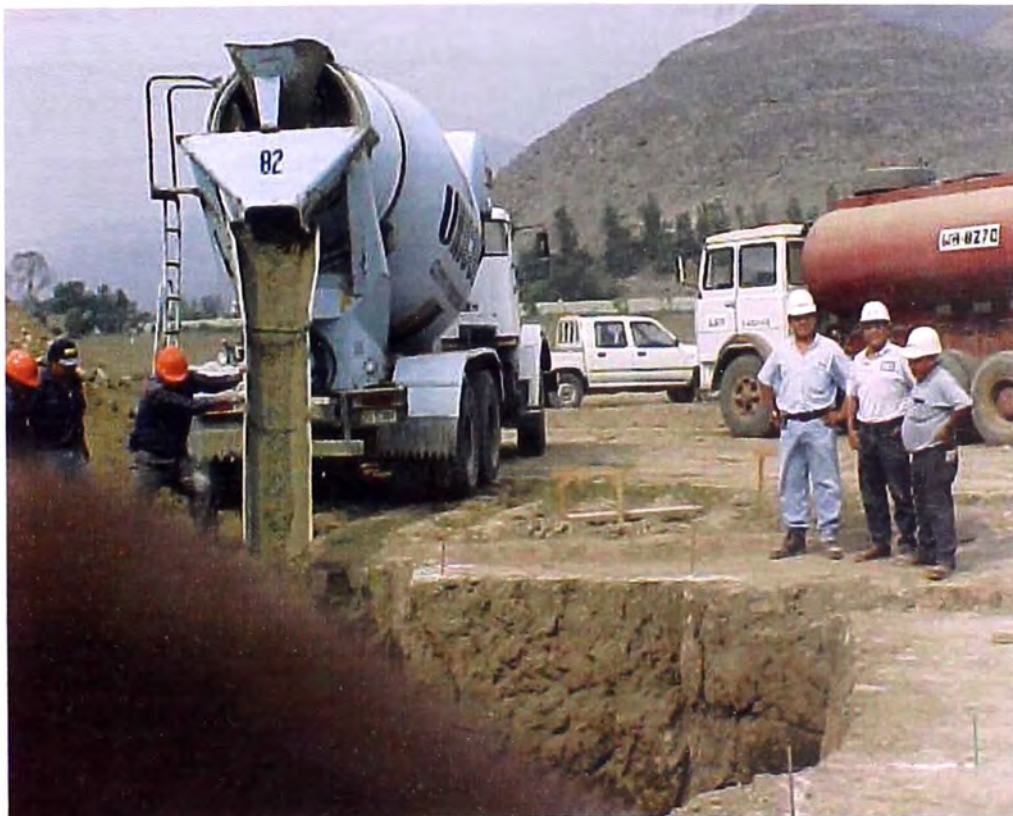
FOTO 145.- Concreto premezclado, en plena colocación del concreto a la cimentación de una de las estructuras del reservorio de compensación, se observa a los ingenieros encargados de la obra en plena inspección.
