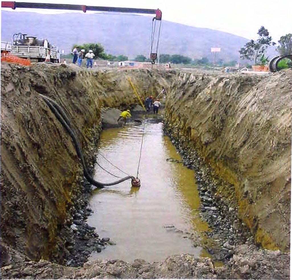
FOTO 84.- Excavación con filtración de agua; de la línea de conducción de la Obra de Captación a la Planta de Tratamiento, se observa motobomba succionando el agua.
