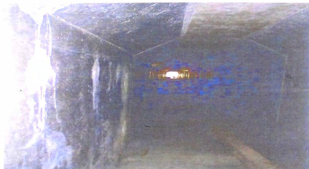
FOTO 63.- En la instalación de elementos prefabricados, de la construcción del barraje, se observa el interior de la galería de drenaje, cajón de concreto prefabricado instalado y cuiminada en todo su longitud de 70 m.
