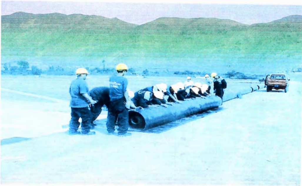
FOTO 33.- Geomembrana, personal en plena colocación de la geomembrana en el reservorio de compensación.
