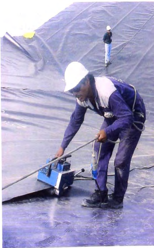
FOTO N° 181.- Geomembrana, se observa al técnico en plena ejecución de soldadura para el empalme de la estructura de impermeabilización de la geomembrana HDPE, colocada como segunda capa de las tres colocadas, después de la primera capa de geotextil, la que se aprecia al fondo extremo izquierdo de color blanco.
