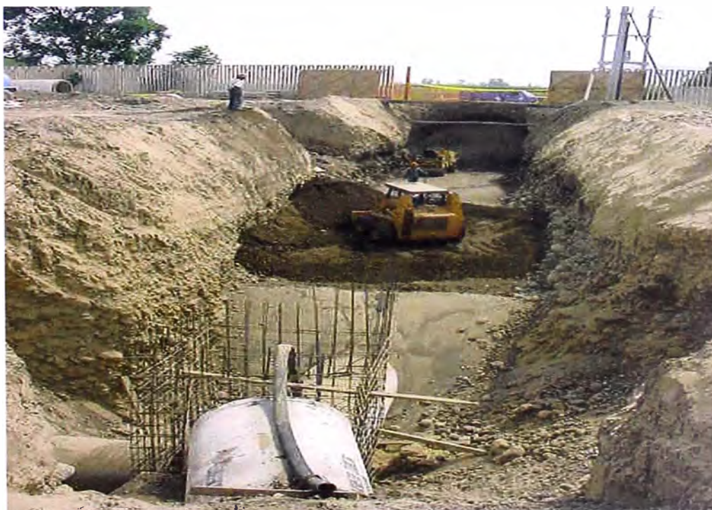
FOTO 77.- Tubería de conducción; llegada de la línea de tubería instalada desde la obra de captación al Reservorio de Compensación y/o Planta de Tratamiento, por la parte posterior de la Sede.
