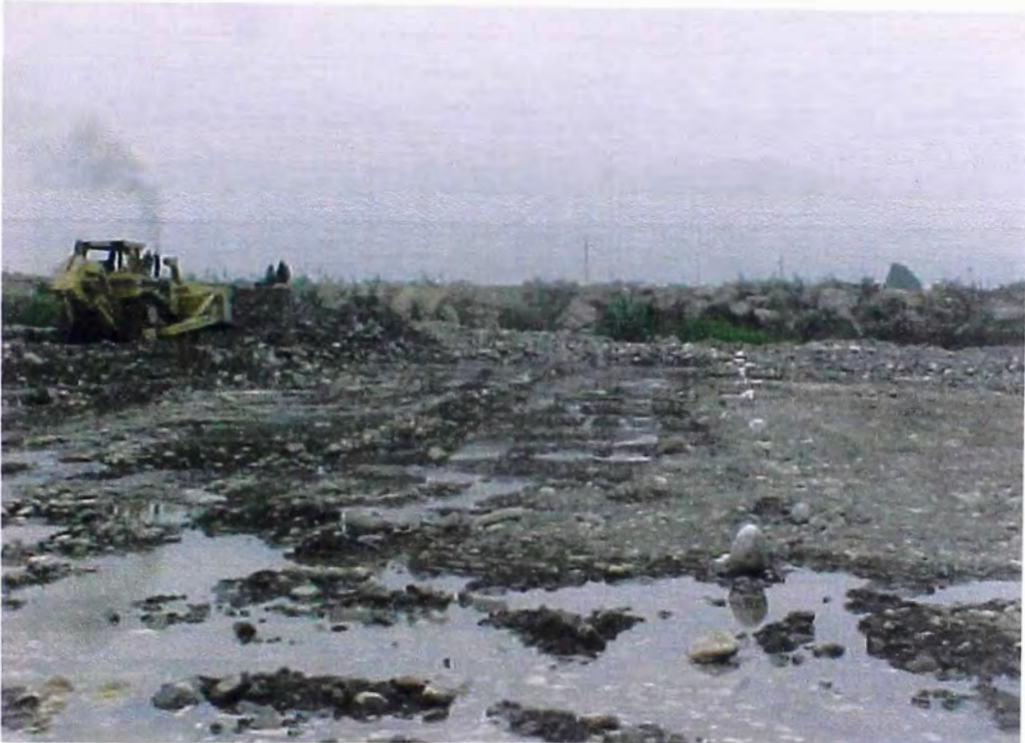
FOTO N° 41.- Limpieza de terreno, ejecutada con maquinaria en el cauce del río, para dar inicio a los trabajos de las obras de captación.
