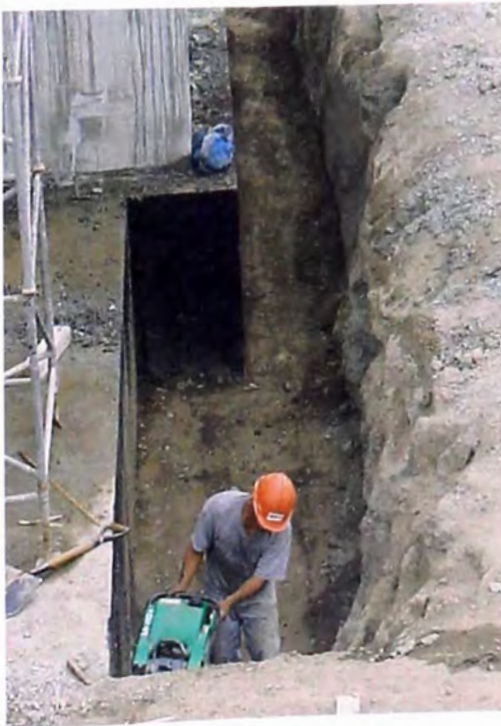
FOTO N° 136.- En la vista se observa a un operador con un compactador portátil, apisonando la base de una estructura de entrada al reservorio de compensación.
