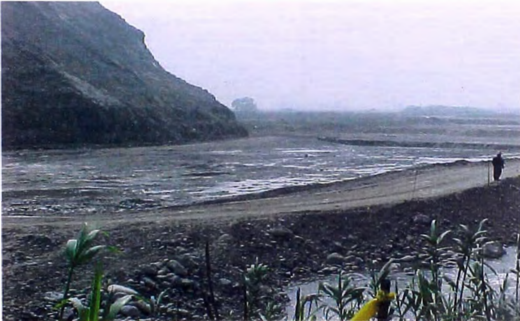
FOTO N° 108.- Camino de acceso a la Cantera; antes de iniciar los trabajos preliminares en las obras de captación y zona de la planta de tratamiento y/o del reservorio de compensación.
