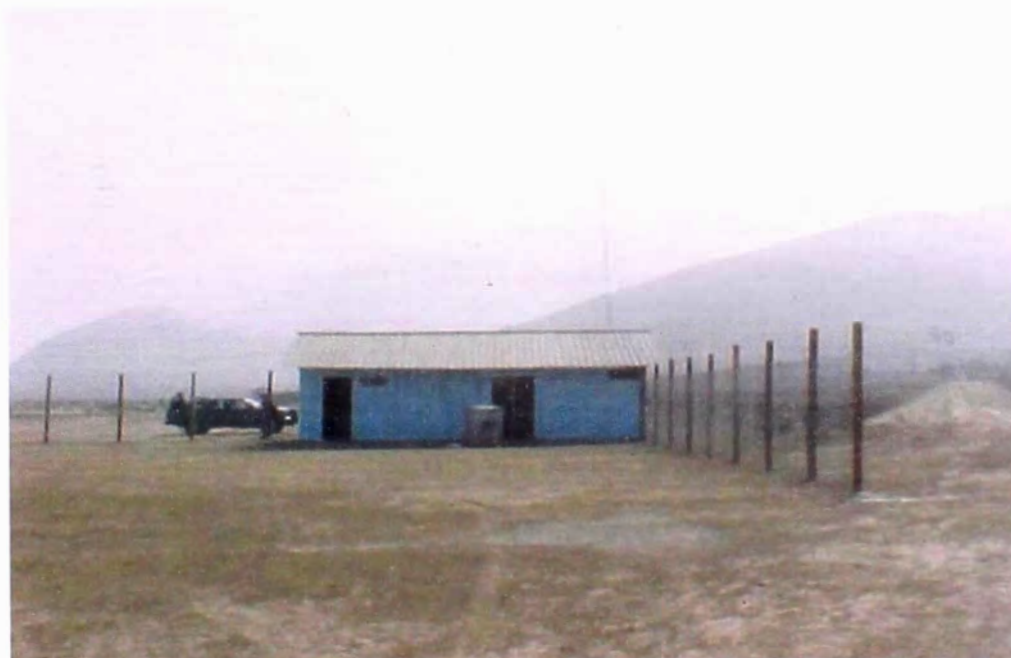
FOTO N° 107.- Campamento secundario , en el frente de trabajo para la ejecución de los trabajos del reservorio de compensación, entre otros.
