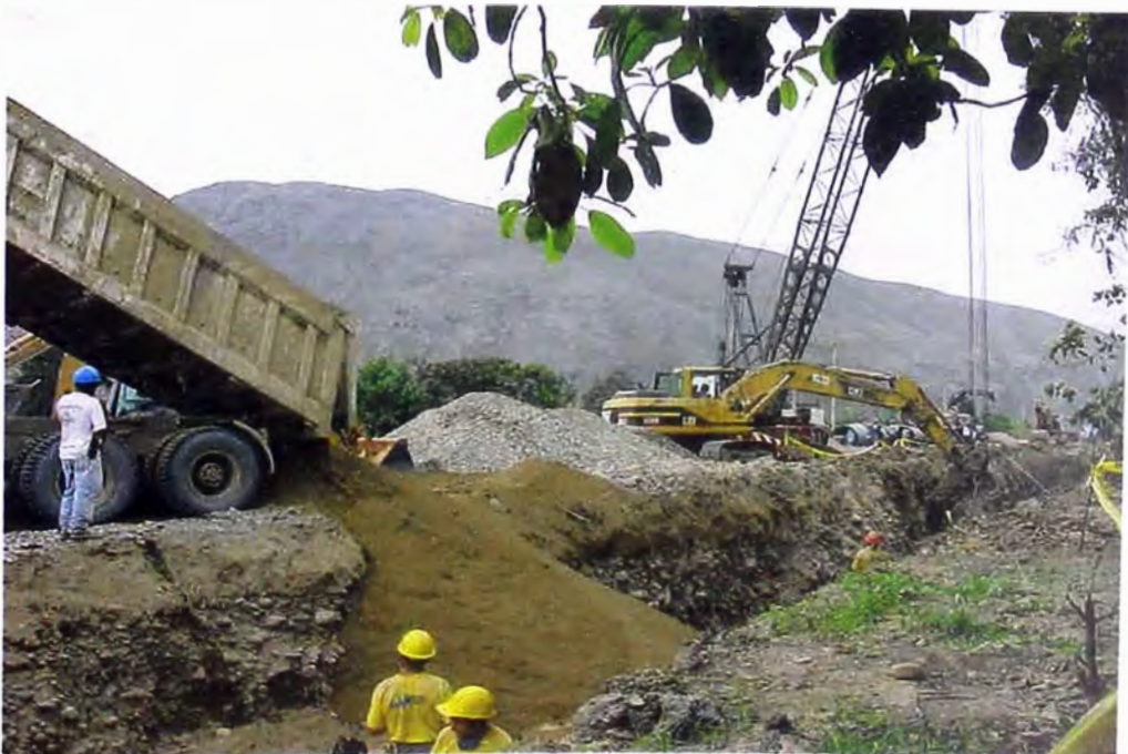
FOTO 126.- Preparación de cama para las tuberías, en la construcción del Reservorio de Compensación en el tramo hacia la Planta de Tratamiento, se observa a un camión volquete descargando arena fina para la cama en la zanja ejecutada.
