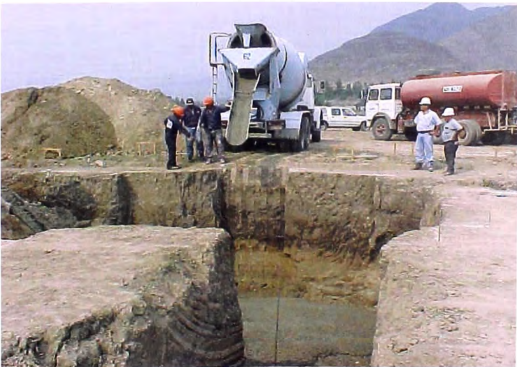
FOTO N° 144.- Concreto ciclópeo, en la cimentación de la estructura de entrada del reservorio de compensación.
