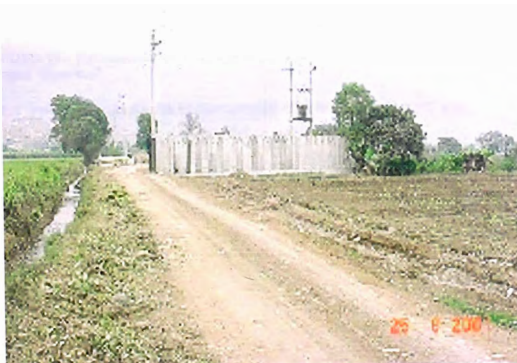
FOTO 16.- Batería de pozos profundos, para la extracción de agua subterránea, y su transformación en agua potable hacia el Cono Norte de Lima.
