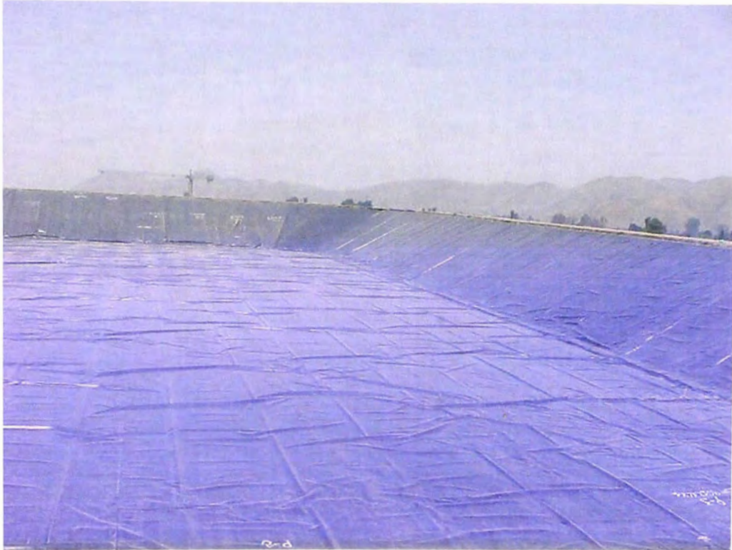
FOTO N° 182.- Geomembrana, se observa instalada totalmente la segunda capa, correspondiente a la impermeabilización con geomembrana HDPE. en uno de los estanques del reservorio de compensación.
