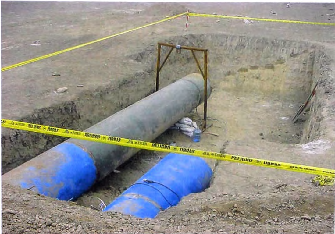
FOTO N° 154.- Estructura de salida del reservorio de compensación, se observa las tuberías metálicas de 1,200 mm de diámetro llegando a la cámara exterior de uno de los estanques.
