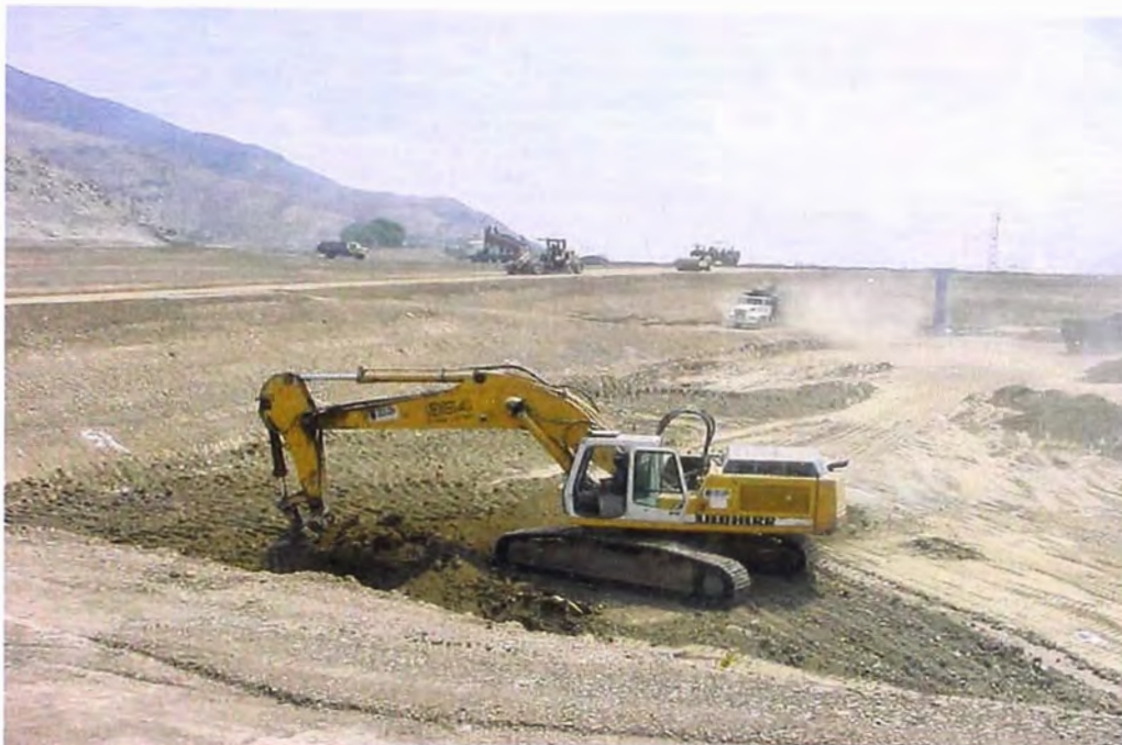
FOTO N° 112.- Movilización de equipo mecánico , tales como: una retroexcavadora sobre oruga, tres camiones volquetes, una motoniveladora, un cargador frontal sobre llantas, un camión cisterna para riego de agua, entre otros, en el frente de trabajo de la ejecución del reservorio de compensación.
