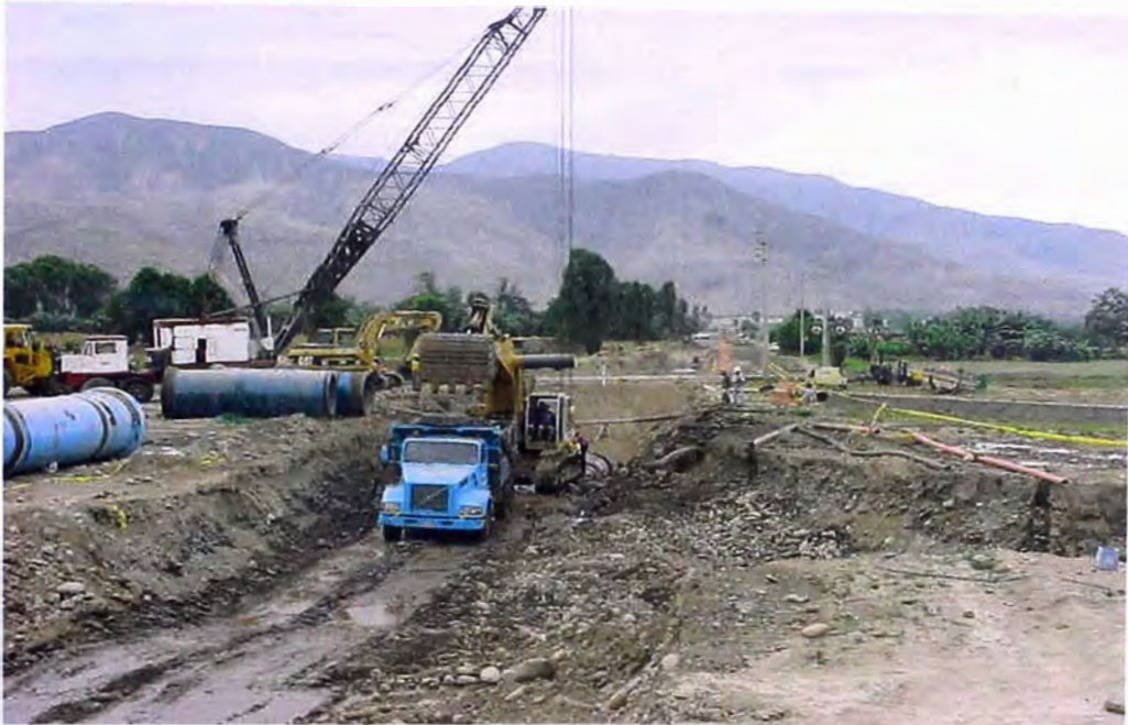
FOTO 88.- Zanja con sobreexcavación; por cuanto en la excavación se ha encontrado material deleznable suelto, para la instalación de la tubería de la línea de conducción de la bocatoma hacia el reservorio de compensación.
