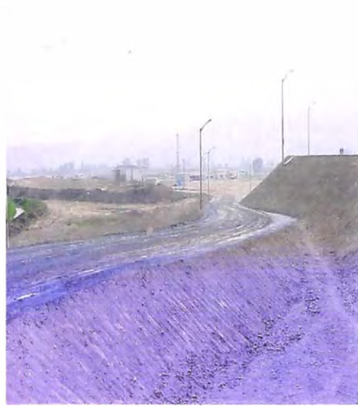
FOTOS N°s 190 y 191.- Imprimación del acceso lateral, subiendo a la plataforma del reservorio de compensación.
