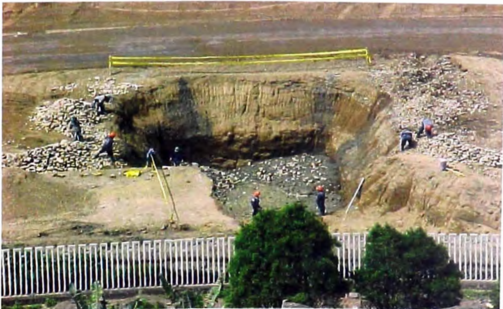
FOTO N° 142.- Concreto ciclópeo, en la cimentación de la estructura de entrada del reservorio de compensación.
