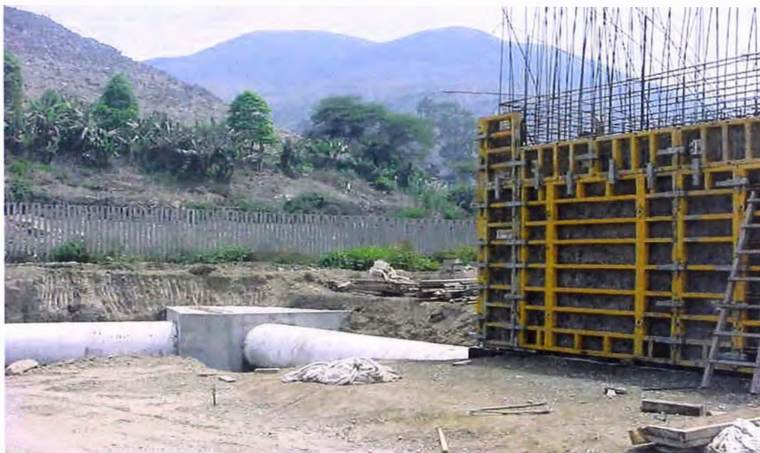
FOTO N° 146.- Encofrado , de la estructura de entrada del reservorio de compensación, se observa la tubería de recolección de CAP de 1,400 mm de diámetro con el dado de concreto en el codo de 90°, a la base de la cámara, asimismo la armadura y el encofrado respectivo para los muros.
