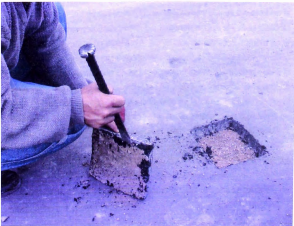
FOTO N° 204.- Control de calidad del asfaltado , técnico de asfalto extrayendo una muestra colocada de la pavimentación en la coronación del reservorio de compensación, para el ensayo respectivo.
