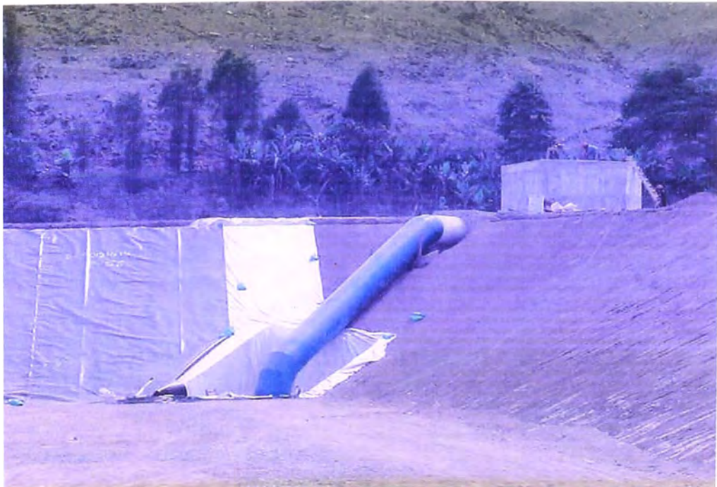
FOTO N° 189.- Geomembrana , se observa su puesta después de la primera capa de geotextil colocado, en la obra de estructura de entrada del reservorio de compensación.
