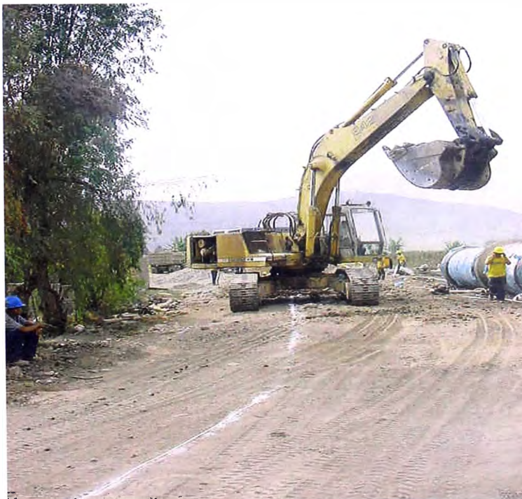
FOTO 75.- Línea de conducción ; se observa el trazado para iniciación de los trabajos de excavación desde la Obra de Captación a la Planta de Tratamiento.
