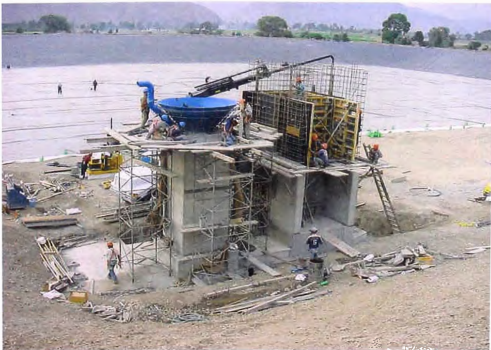
FOTO N° 157.- Se observa la colocación de concreto premezclado de los muros de la estructura de salida de uno de los estanques del reservorio de compensación.
