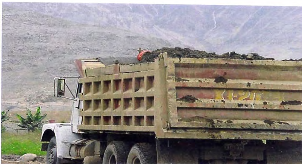
FOTO 94.- Eliminación de material excedente; o por no ser material recomendable para relleno se eliminó con volquetes a lugares definidos o botaderos, por la supervisión.
