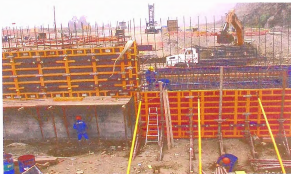
FOTO 65.- Construcción del barraje , donde se observa de aguas arriba la construcción por etapas del encofrado y de la armadura de la pantalla del barraje.
