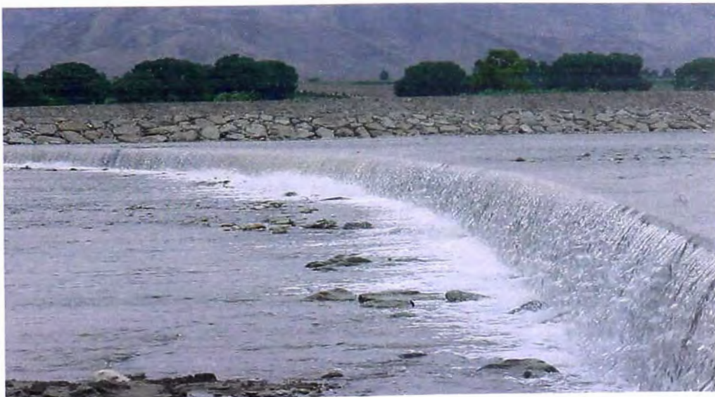
FOTO 73.- Enrocado de piedras, se observa a lo largo de la ribera del margen izquierdo del río aguas arriba y aguas debajo del lugar donde se ejecutó las obras de captación - bocatoma, como parte de la defensa ribereña, para la zona de cultivos de la zona.
