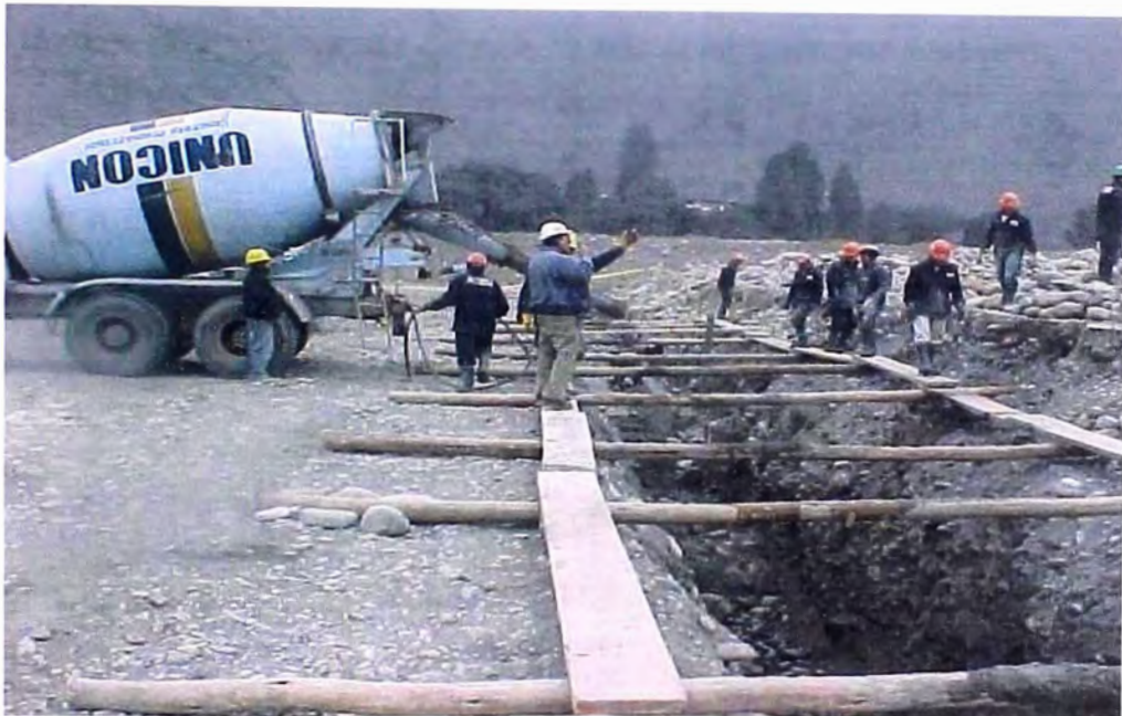
FOTO 58.- Construcción de la pantalla de lechos de filtración, donde se observa el vaciado de concreto simple para el solado de la cimentación, aguas arriba de las obras de captación.
