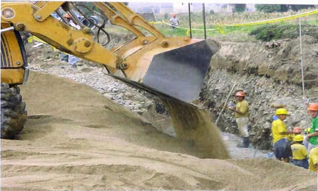
FOTO 96.- Colocación de la cama; para la tubería de la línea de Conducción en el tramo desde la Obra de Captación a la Planta de Tratamiento.
