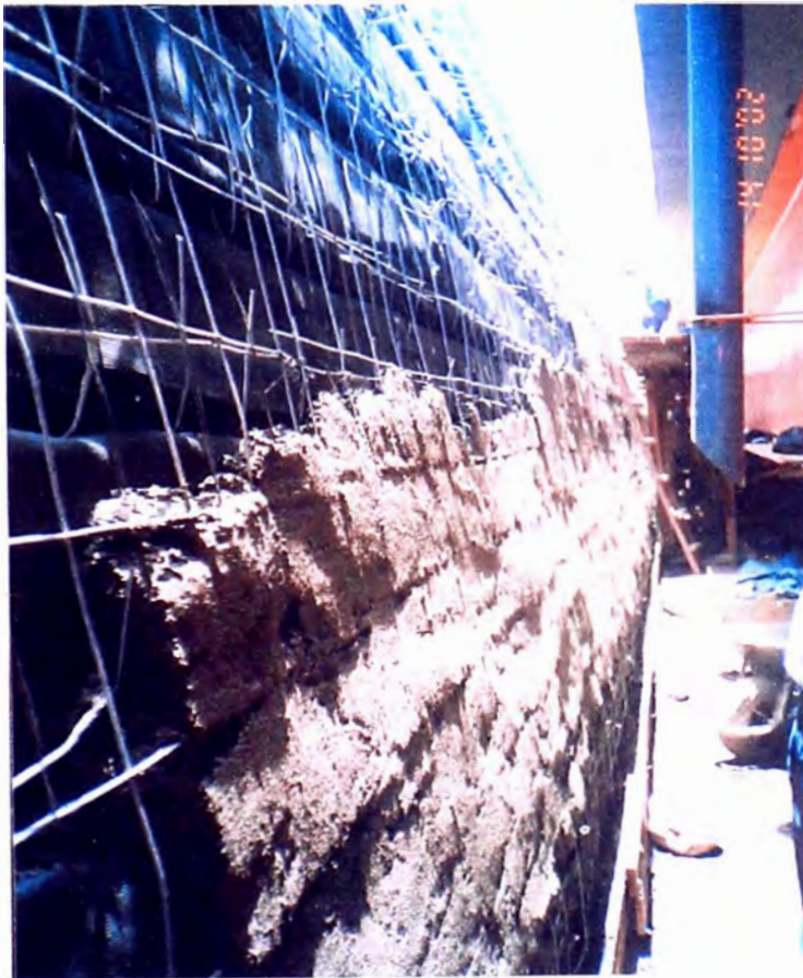
Foto N° 7a. Etapa de Pañeteo
