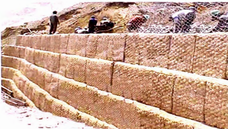
Foto N° 4 Muro Reforzado con Geotextil .ICCGSA Contratistas Generales. Lima 199
