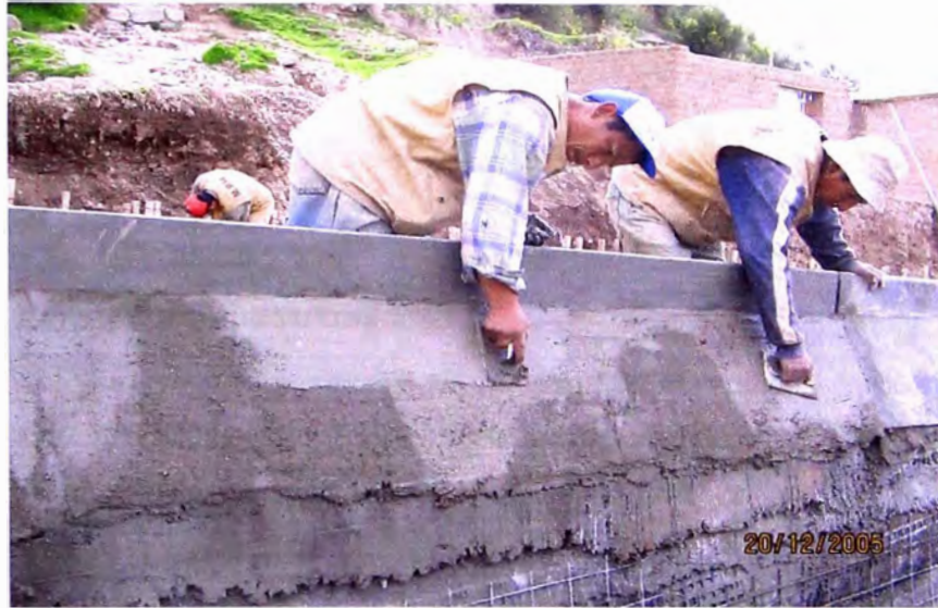
Foto N° 6 Ejemplo de Aplicación de Mortero en Paramento de Muro Reforzado con Geotextil
