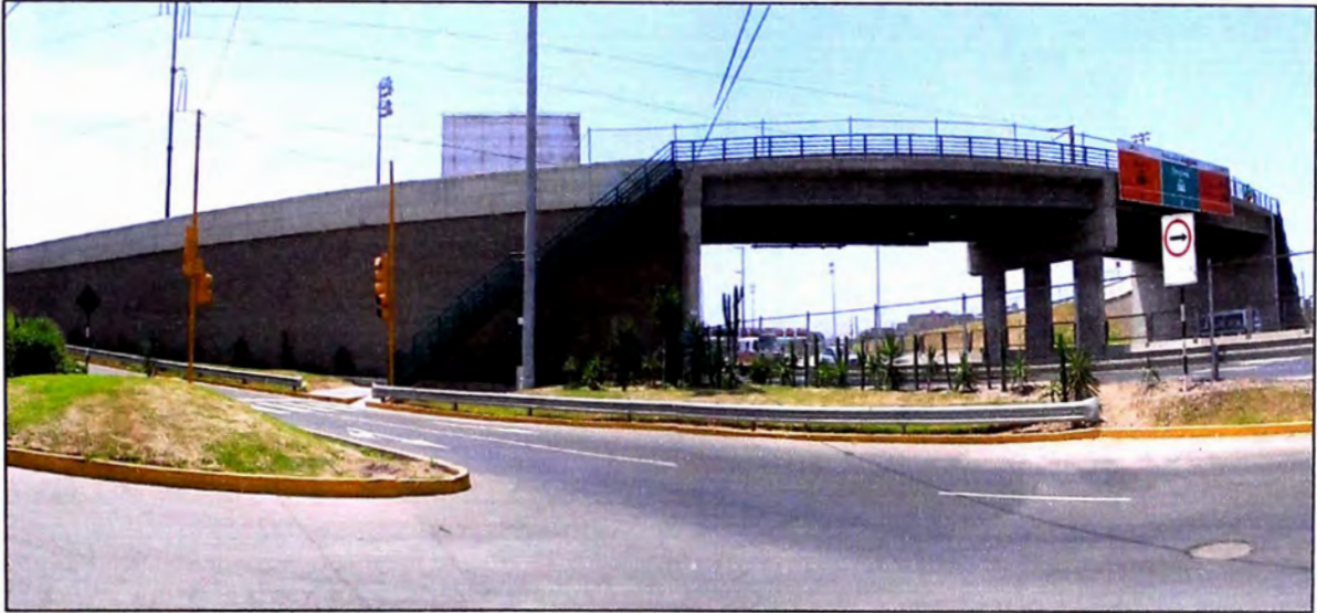
Foto N° 1 Vista Frontal de la Vía Expresa del Callao Paso a desnivel Av. Qui/ca. Lima - Perú 2004
