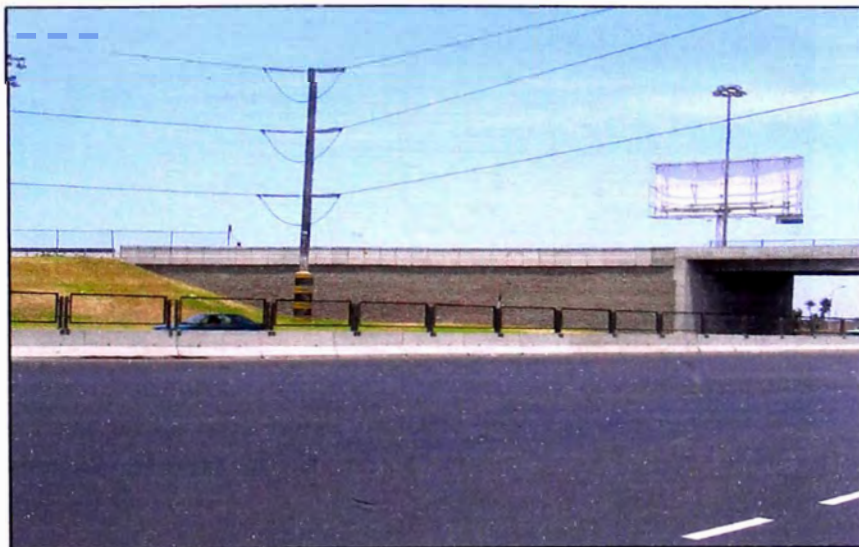
Foto N° 2 Vista Lateral de la Vía Expresa del Callao.
