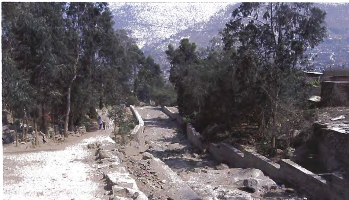
Fig. 10: Imagen donde obras de canalización con mampostería de piedra, en la quebrada Santo Domingo, parte media de la cuenca.
