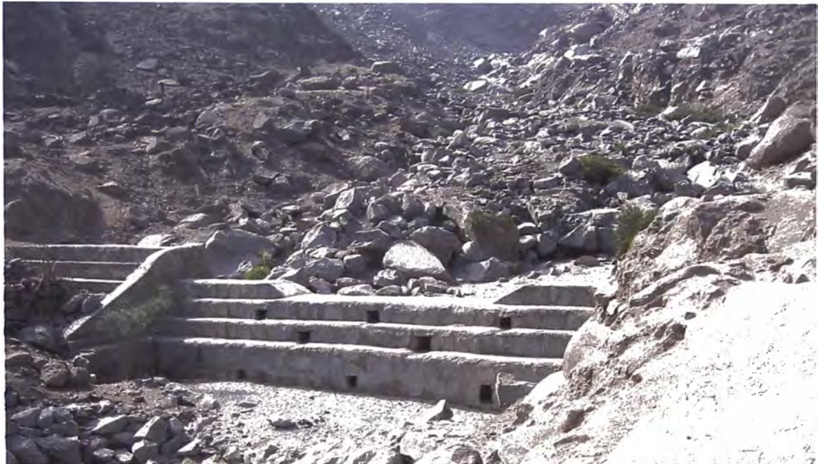
Fig. 09: Imagen de dique de escombros o regulador construido de mampostería de piedra en la quebrada Santo Domingo.
