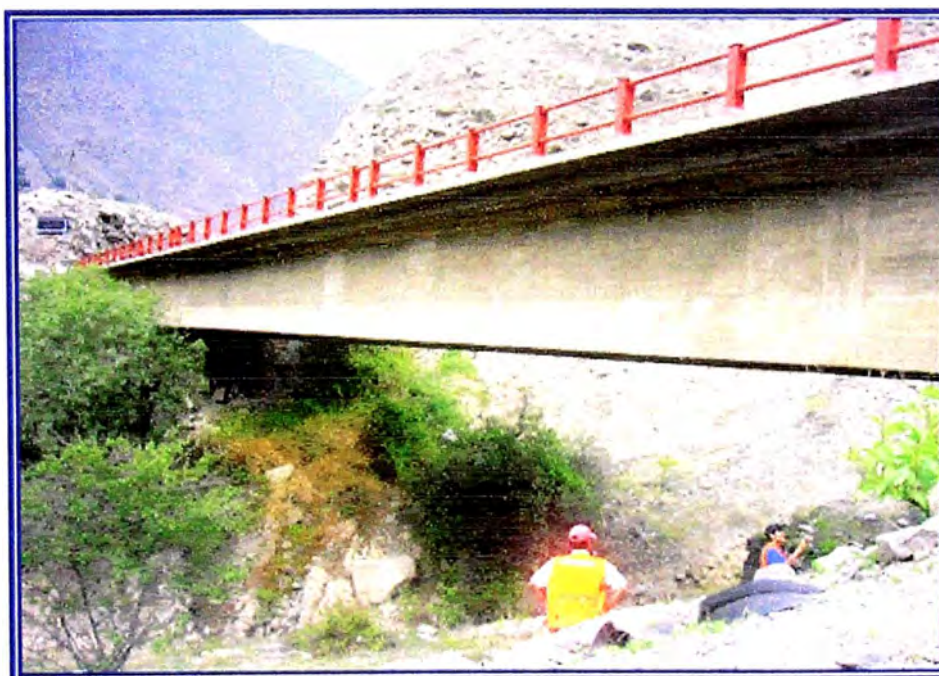
FIG N°15 Puente Cascada (Km. 59+180) de longitud 52 m. ,tablero tipo losa y vigas T.
