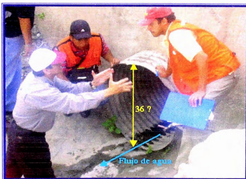
FIG N°12 Salida de la alcantarilla tipo TMC, de 36" de diámetro y 10.6 m de longitud. Se encuentra de regular a buen estado de conservación. Km. 59+810
