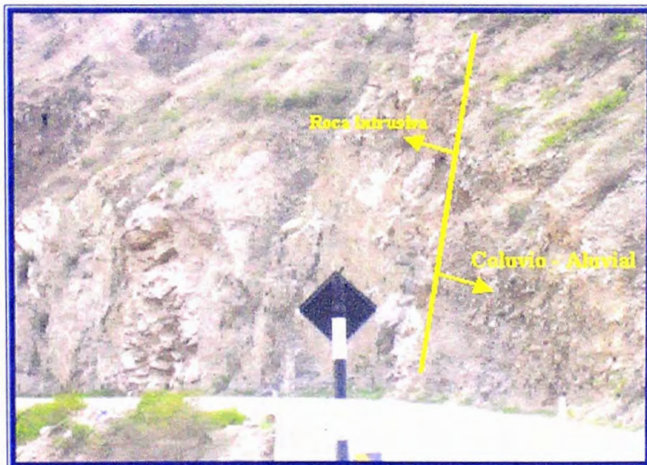
FIG N°1 Progresiva Km. 58+800 , donde ocurre el cambio de litología de depósito coluvio – aluvial a roca intrusiva
