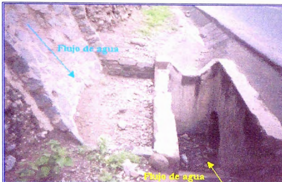
FIG N°11 Cabezal de la alcantarilla en buen estado de conservación. La cual permite la evacuación de las aguas que llegan de la cuneta y del talud superior. (Km. 57+905)
