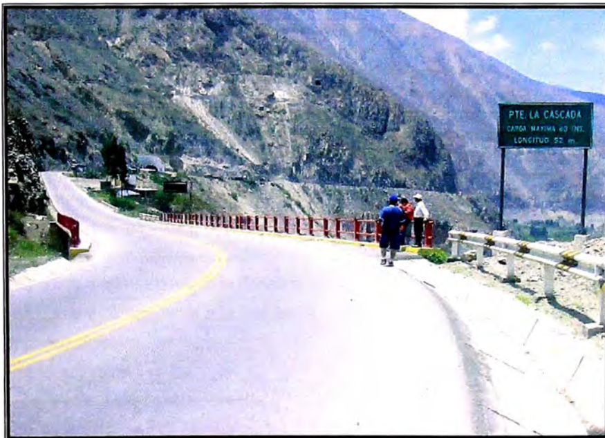
FIG N°26 (I-18) Señal informativa: Puente La Cascada
