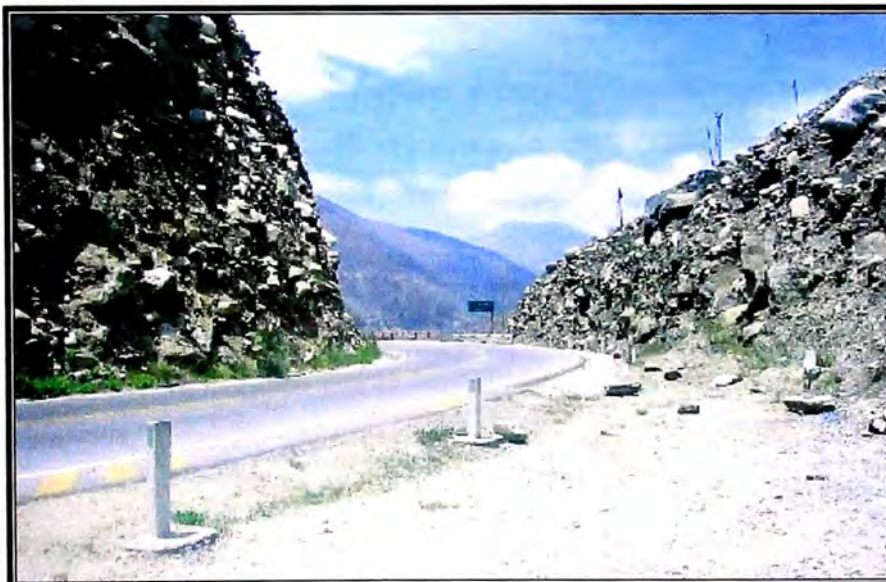
FIG N°32 Postes delineadores KM 59+320
