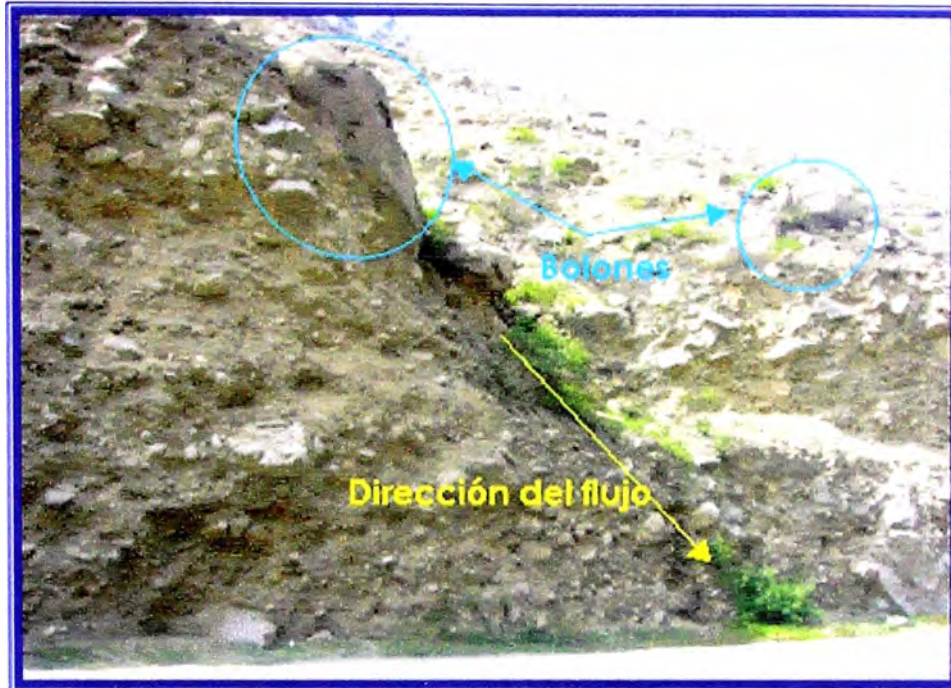
FIG N°4 Depósito coluvio-aluvial, La presencia de las precipitaciones viene generando la formación de cárcavas. Existen bolones los cuales pueden desprenderse ante la presencia de precipitaciones y escorrentía superficial. (Km. 59+850)
