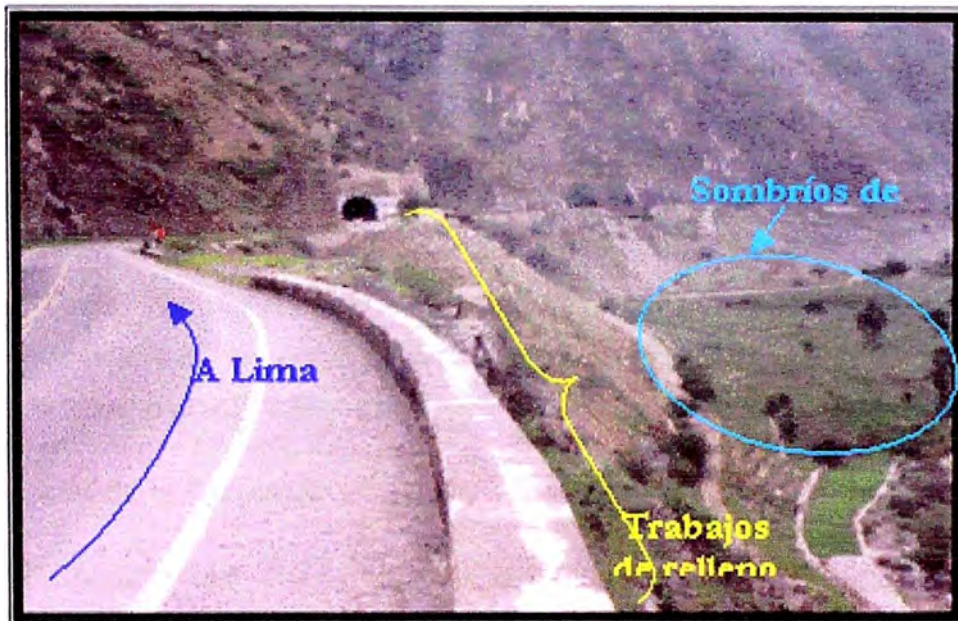
FIG N°21 Vista panorámica del área de influencia en esa zona de la carretera y los posibles impactos Socio Ambientales a abarcar.
