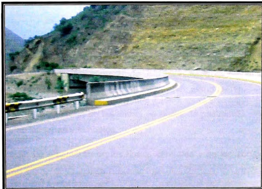
FIG N°27 Marca sobre el pavimento: Línea central
