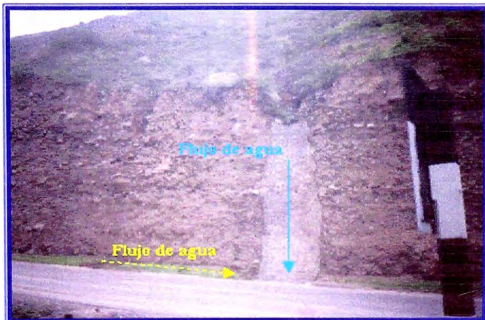
FIG N°10 Emboquillado construido para proteger el talud y encauzar la escorrentía superficial hacia la alcantarilla(KM 57+905)
