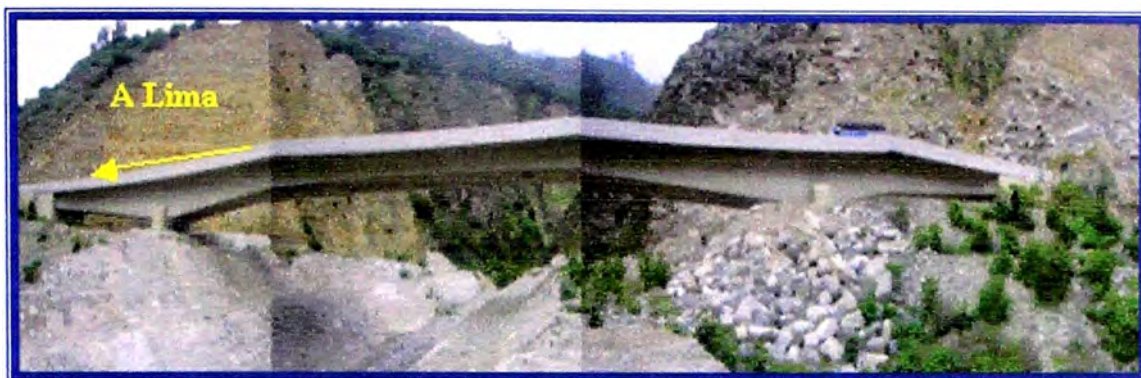
FIG N°14 Puente Collana (Km. 71+520) de longitud 200 m. en la vista se observa el tablero tipo cajón y de altura variable, aguas arriba se observa la vegetación, y el tipo distinto de material a ambos lados de la quebrada
