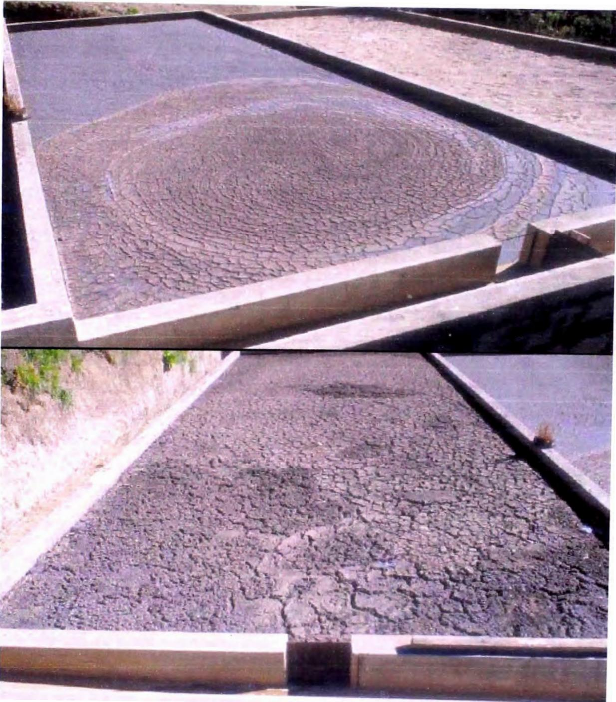
**Foto 4.2.** En el lecho de secado arriba los lodos están frescos y acaban de empezar secando con una capa superior duro que impide la evaporación de agua en las capas inferiores. Luego, después de secar más, los lodos empiezan a formar grietas, los cuales facilitan el secado de las capas inferiores como se ve en la foto abajo.
