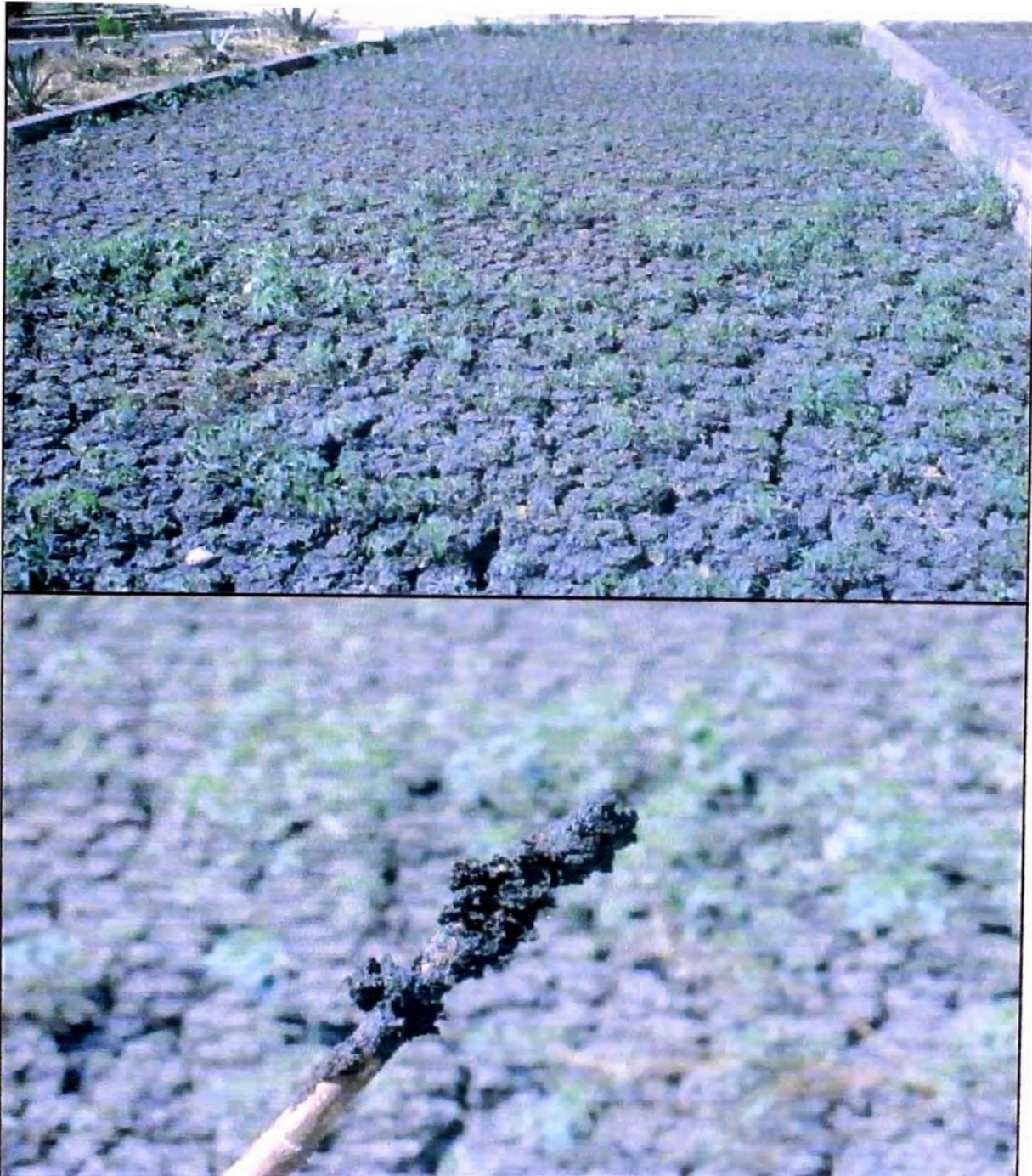
Foto 4.1. Cuando los lodos empiezan a secar la capa superficial forma una capa dura que previene el secado de las capas inferiores como se ve en las fotos de un lecho de secado. Mientras la capa superficial está seca (foto arriba), las capas inferiores mantienen su humedad como se ve después de meter un palo por adentro (foto abajo) ( Ciudad de Guatemala)
