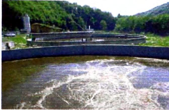
Fig. 2.1. Tanque de aireación biológica
