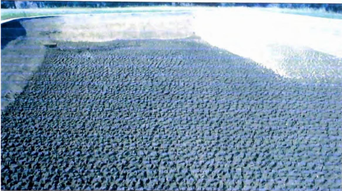
Foto 4.3. Un buen ejemplo de los lodos secos después de ser esparcidos y volteados periódicamente para facilitar el secado. Nótese la rampa para el acceso de equipo pesado (Or-oville, CaJifomia, EE.UU).
