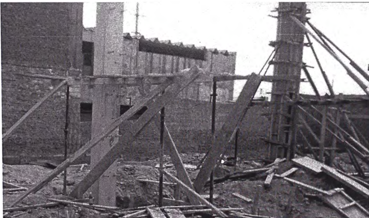
39. Encofrado, apuntalado y arrioste de columnas correspondientes al pórtico estructural del patio de llaves.
