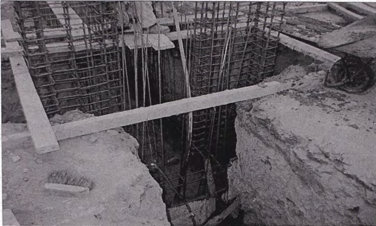
49. Vaciado de concreto para cimentaciones ( h=-1.60\text{m} ) del Edificio de Celdas, Columnas con acero de \varnothing 5/8" y estribos de \varnothing 3/8" .
