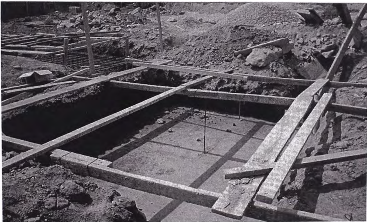
18. Vaciado de concreto ciclópeo ( f_c=100\text{kg/cm}^2 ), a nivel de falsa zapata. ( h=0.80\text{m} ). Nótese ubicación de puntos para nivelación y verificación de cotas.
