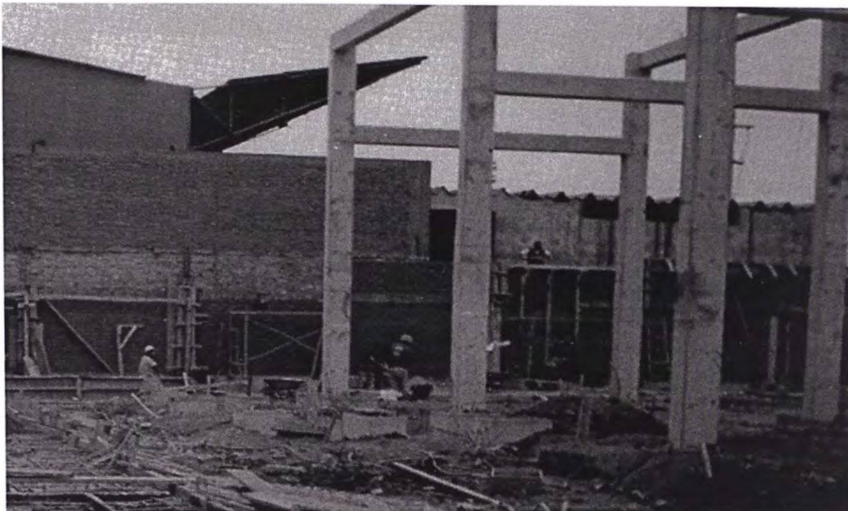
42. Desencofrado de vigas superiores en ambos sentidos; corresponden al pórtico estructural.
