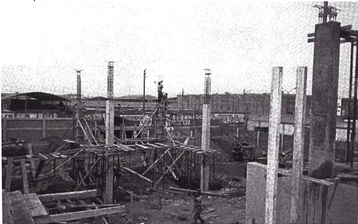
41. Habilitación y colocación de armadura correspondiente a zona de encuentro columna – viga. Culminación de encofrados.
