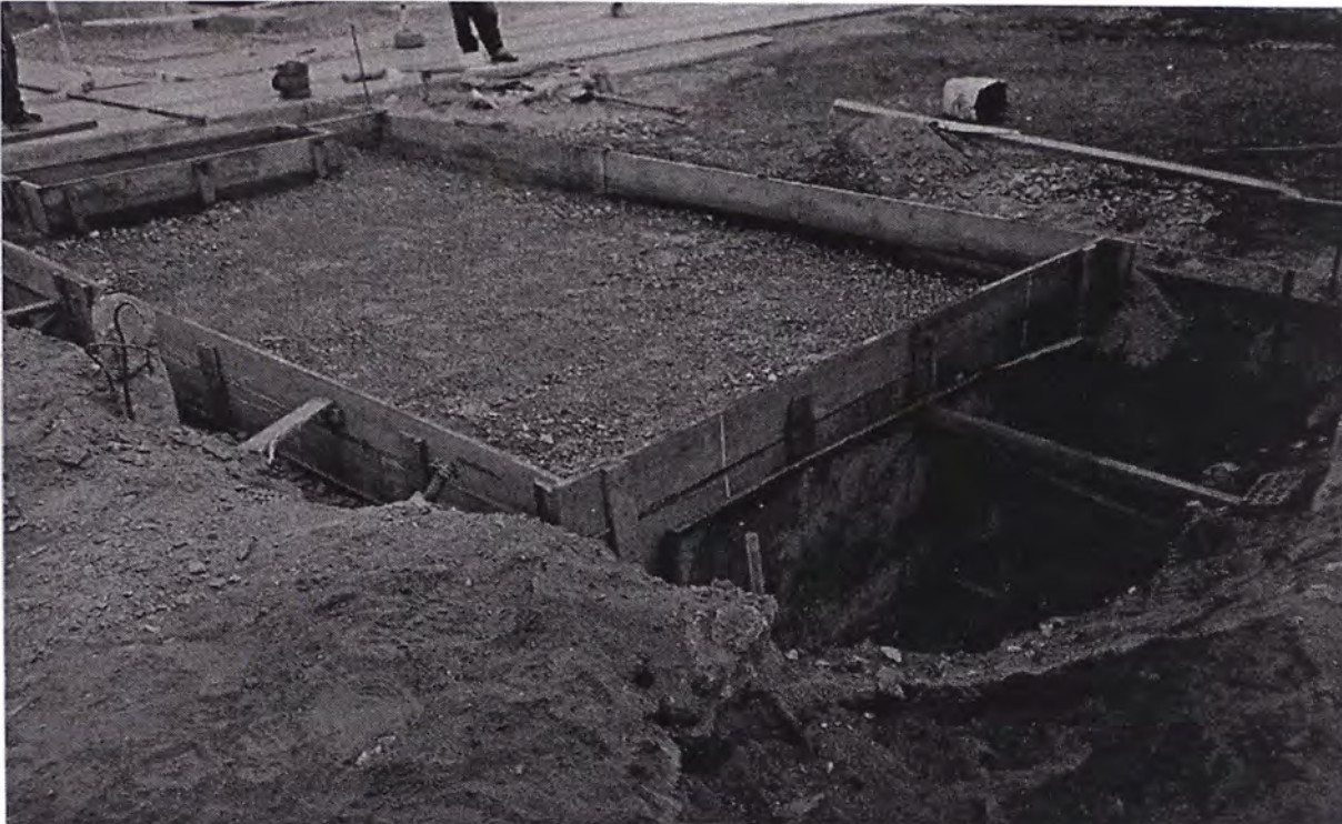
29. Proceso de encofrado de caras laterales de la losa de concreto armado en Base de transformador. Nótese conformación de sub zapata de concreto ciclópero f_c=100\text{kg/cm}^2 + 30\% \text{ PM} .
