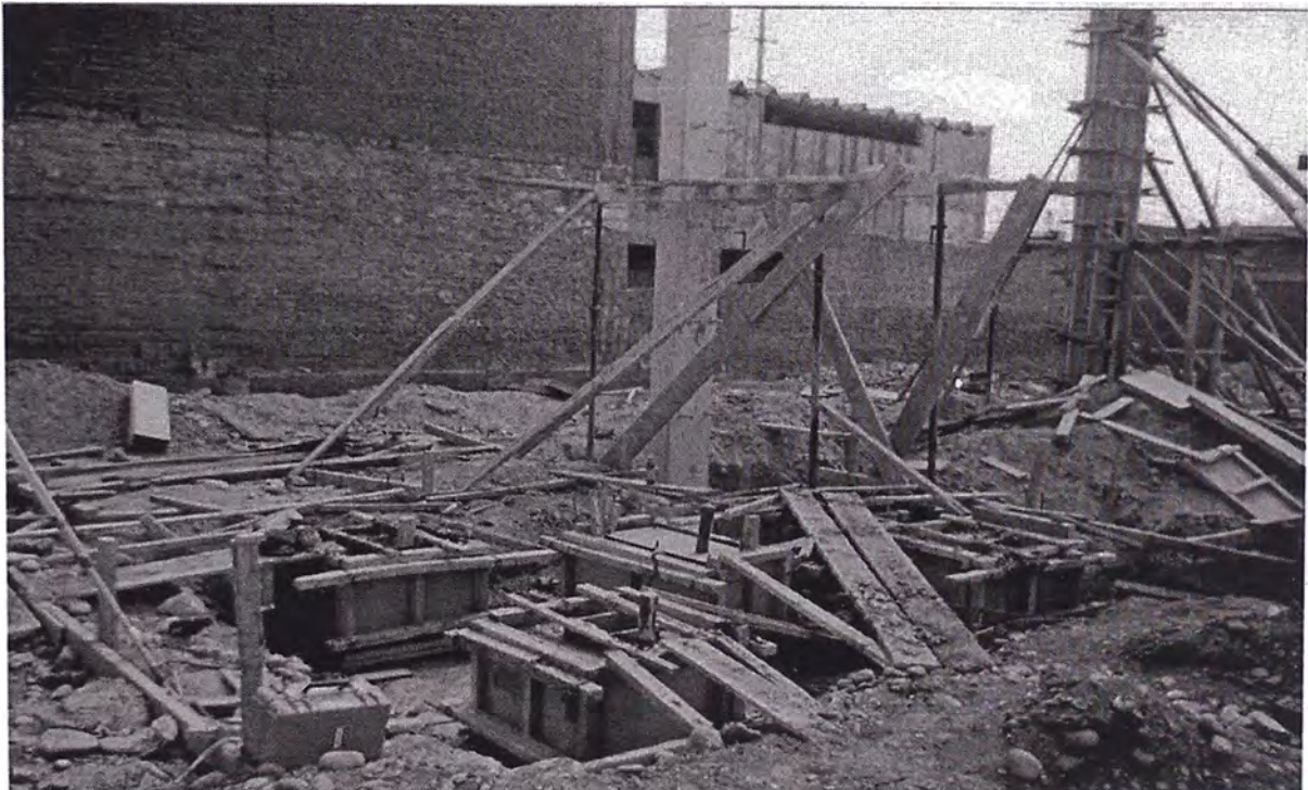
20. Culminación de vaciado de pedestales correspondientes a Base de celda del transformador, disposición de pernos y salidas PVC para comunicación.
