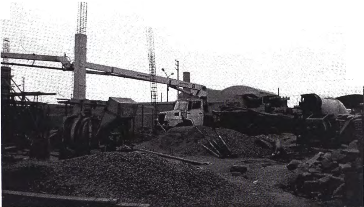
40. En todas las etapas de vaciado, se solicitó el uso de concreto pre mezclado con bomba impulsadora.
