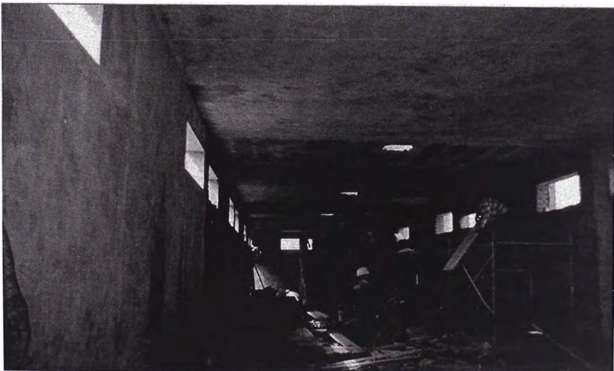
52. Vanos laterales correspondientes a iluminación, ventilación, en la parte posterior vano corresponde a sistema de ventilación mecánica.
