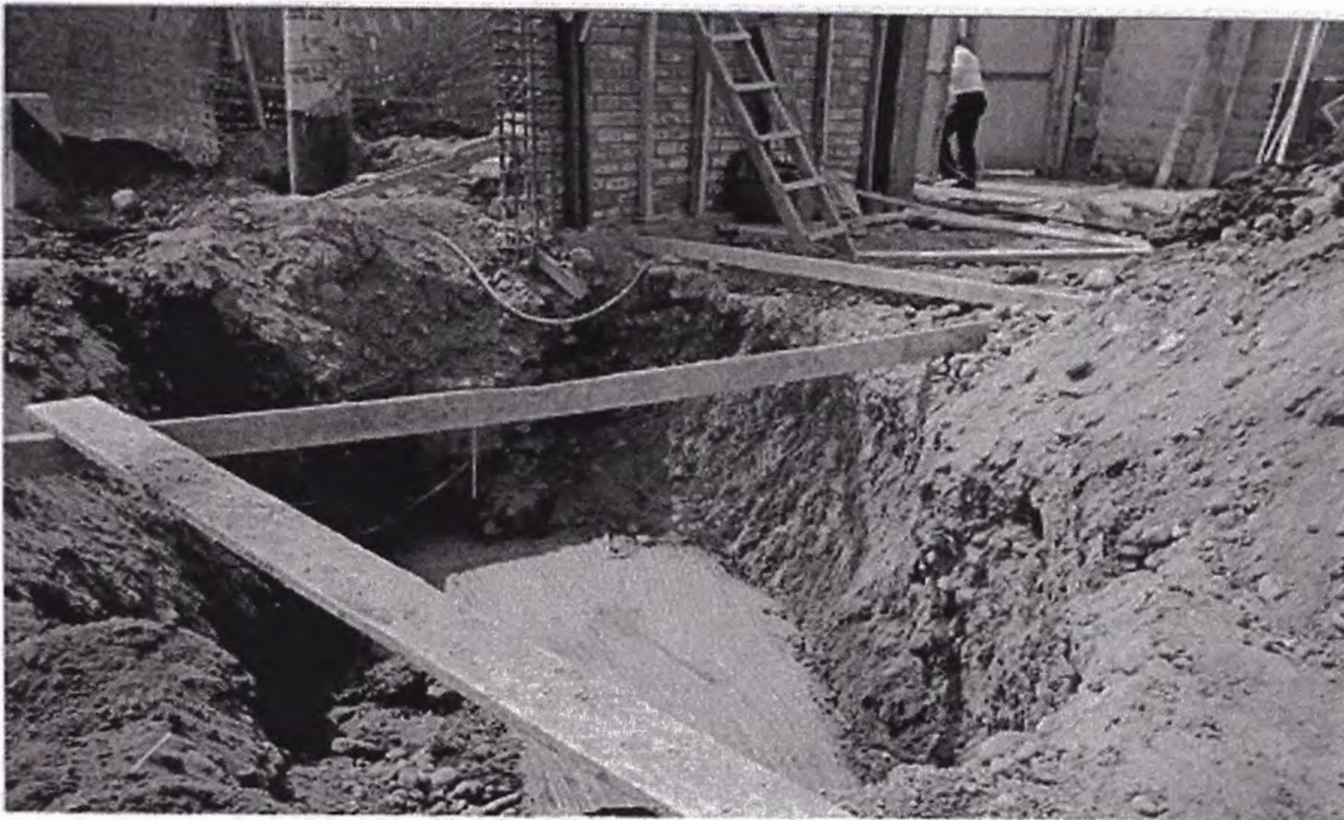
7. Vaciado de solado correspondiente a cimiento de cerco en lindero posterior
