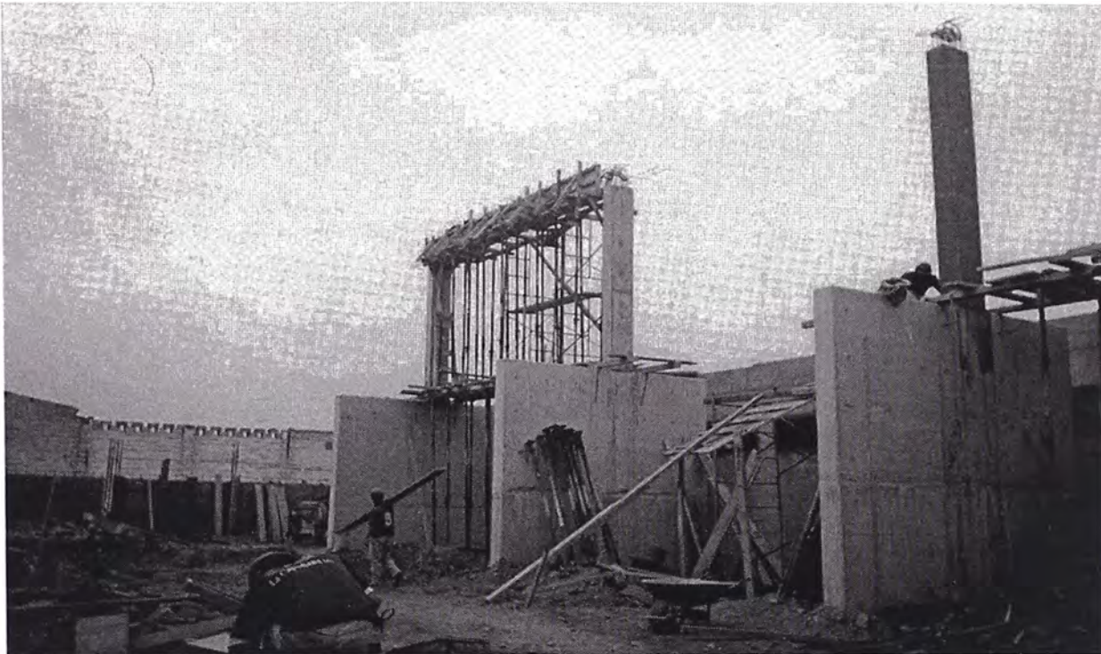
45. Encofrado de viga superior correspondiente a pórtico de llegada para líneas Allta Tensión. Vista derecha pantallas separadoras entre transformadores.
