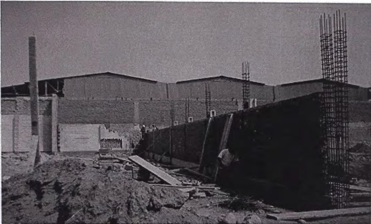
9. Preparación de encofrado caravista para columnas en cerco posterior.
