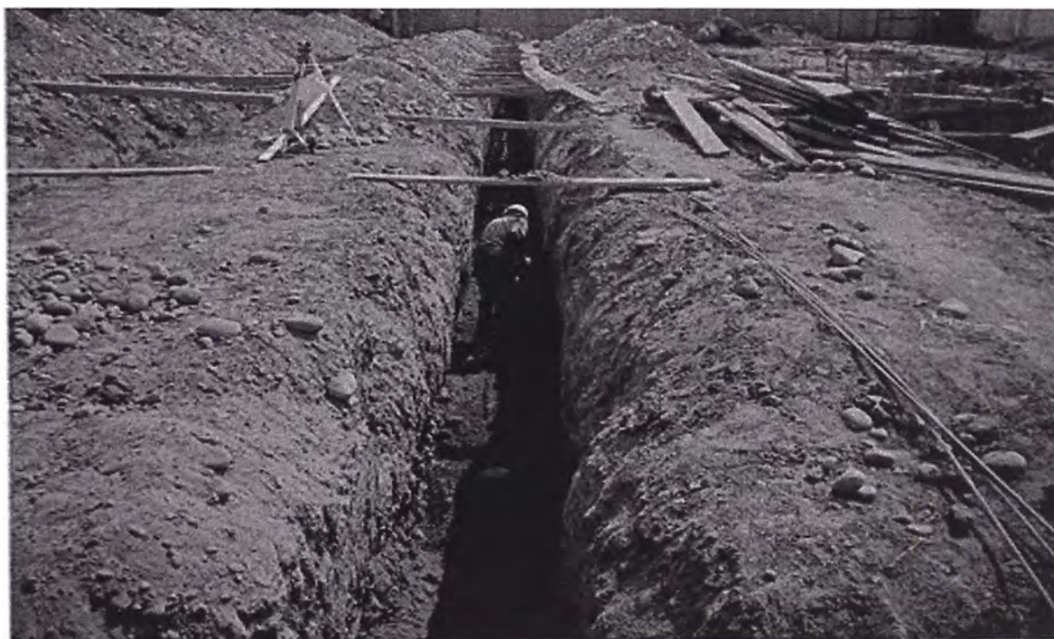
16. Cierre de zanjas, mediante relleno, nivelación y compactación mecánica cada 0.20m usando material de préstamo de baja resistividad (tierra de chacra).
