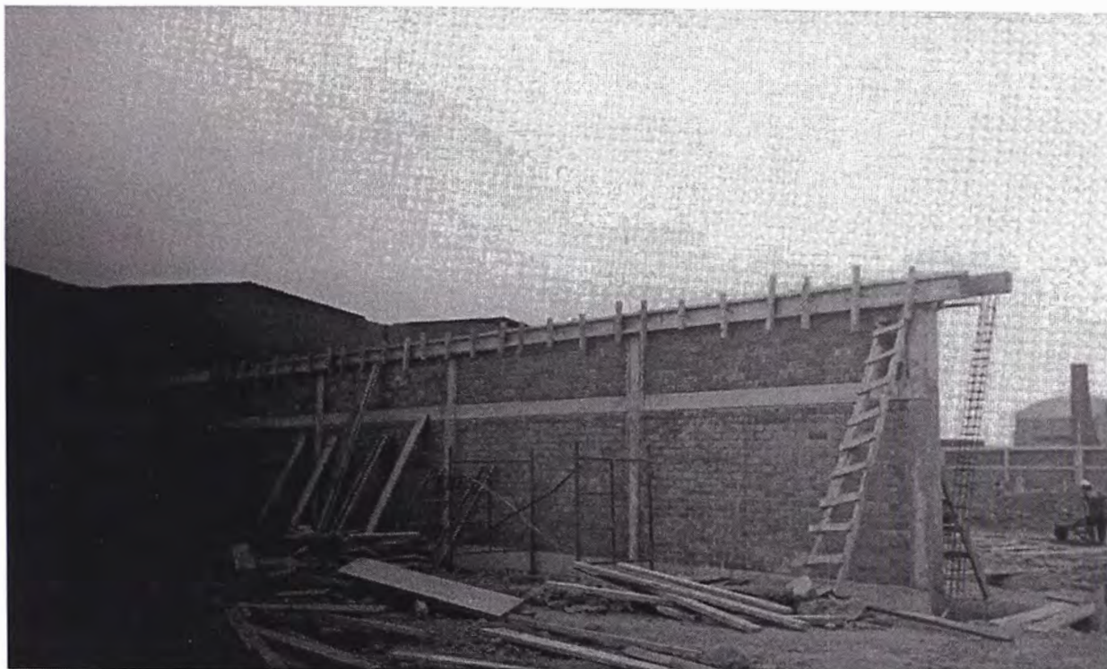
11. Encofrado cara vista de viga solera, correspondiente a muro lateral;
