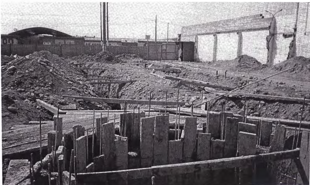
26. Culminado de vaciado de muro circular armado en cisterna de aceite h=2.75m ; e=0.25m . Se incluye impermeabilizante integral de fraguado normal.
