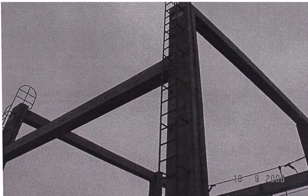
43. Pórtico estructural culminado, incluyendo fabricaciones metálicas.
