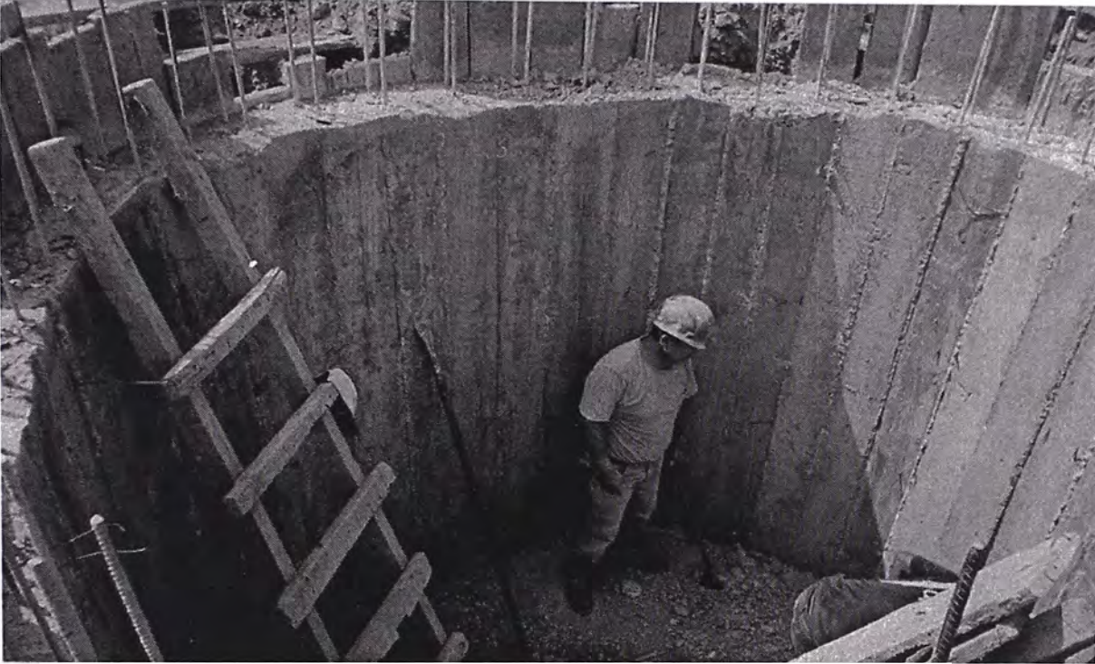
27. Desencofrado de paredes de concreto armado (placas) para cisterna de aceite.
