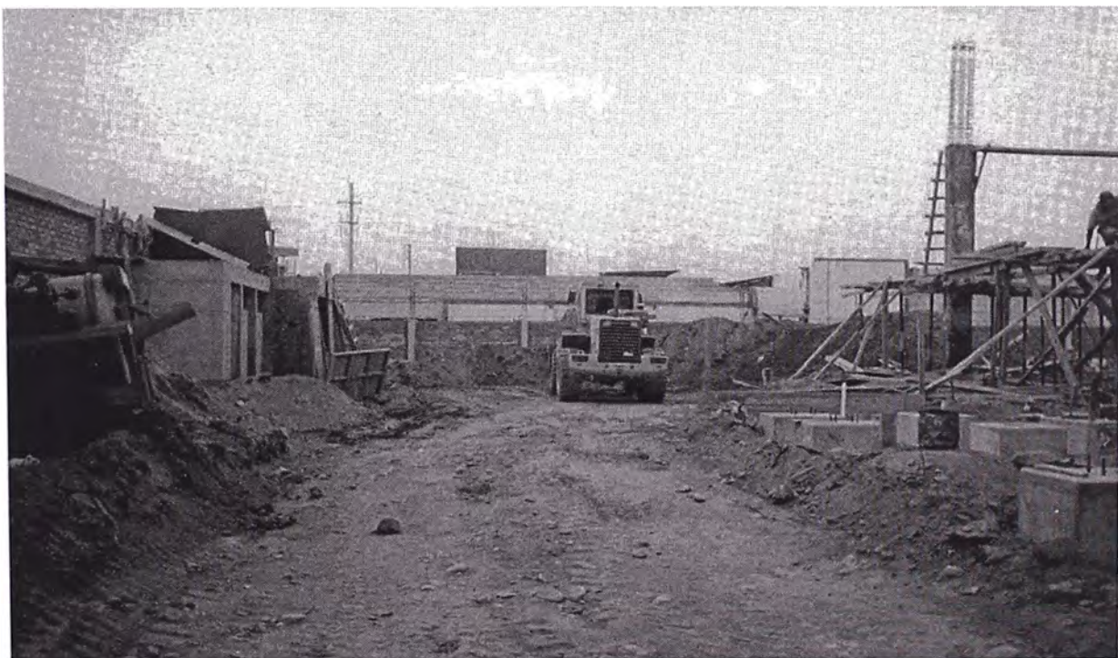
46. Corte a terreno natural para conformación de sub rasante correspondiente a pista perimétrica .
