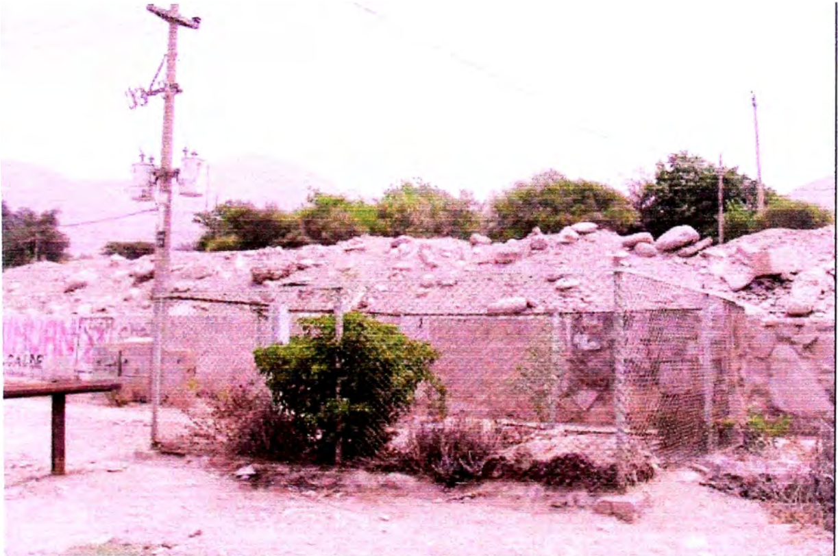
FOTO 4.-Estación de bombeo existente
